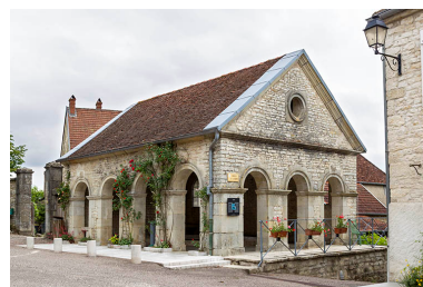
Lavoir rue de l'Eglise.
