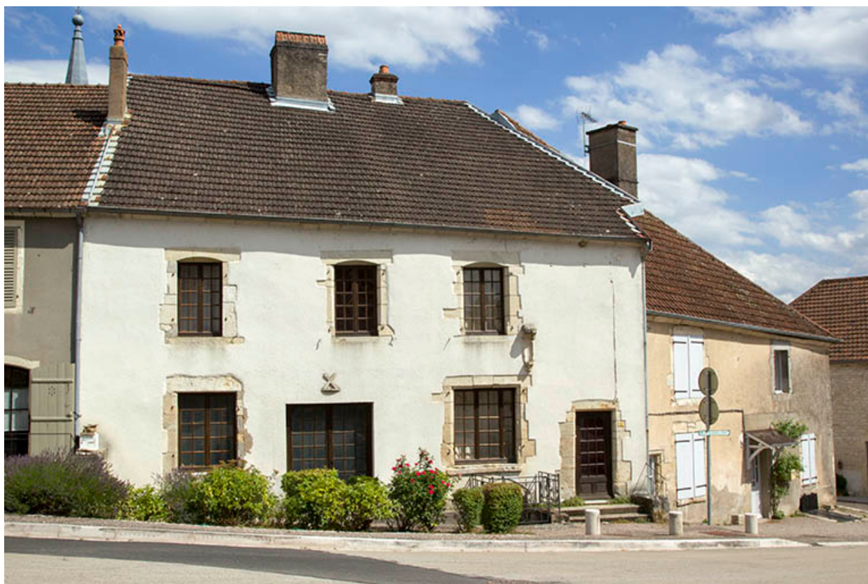
Maison place Gabrielle de Salverte, vue générale.
