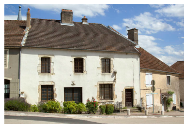
Maison place Gabrielle de Salverte, vue générale.
