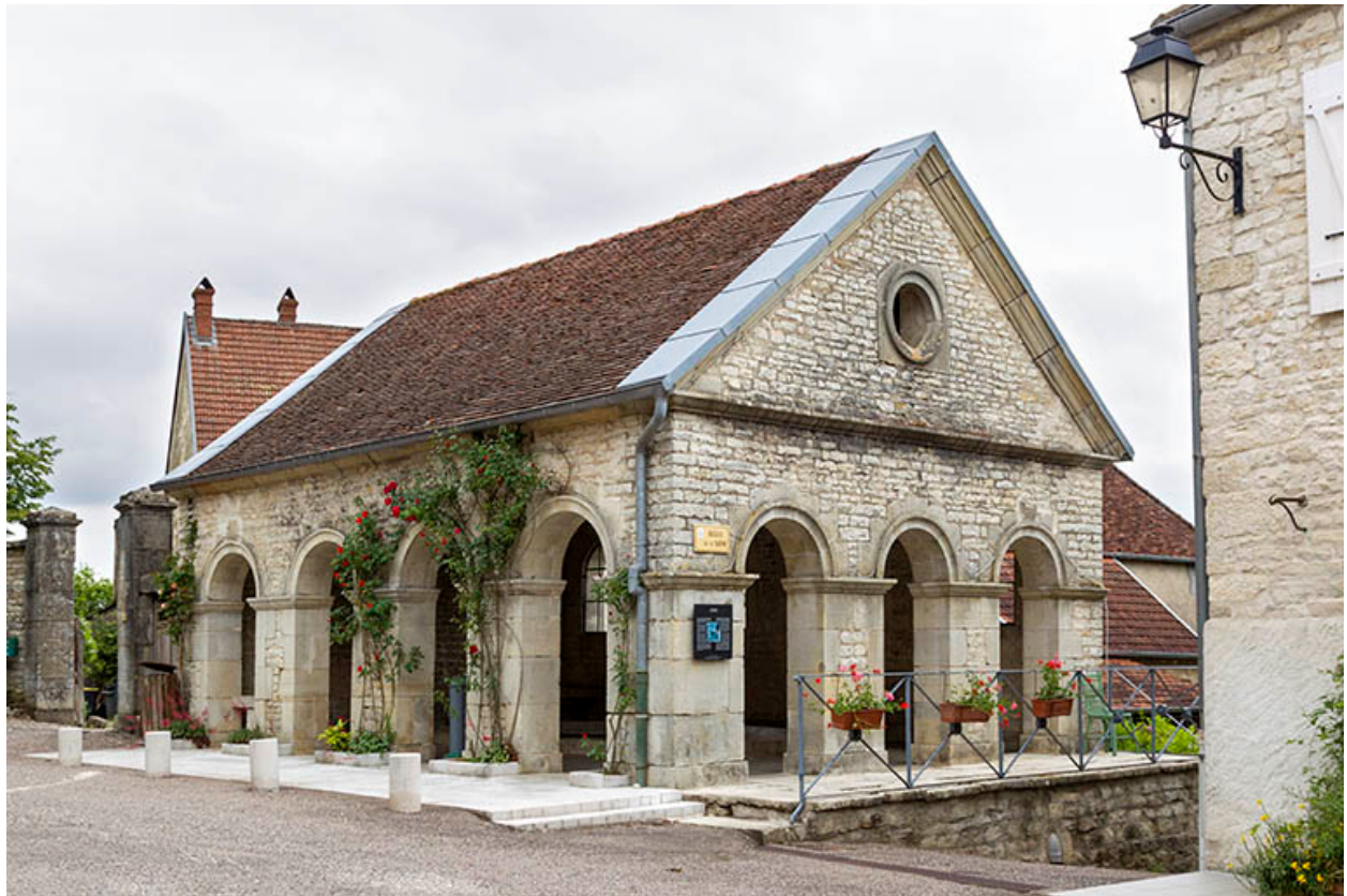
Lavoir rue de l'Eglise.
