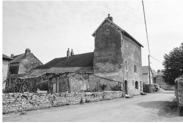
Vue d'ensemble : façade postérieure. Phot. Bernard Lardière IVR43_19817000241Z
