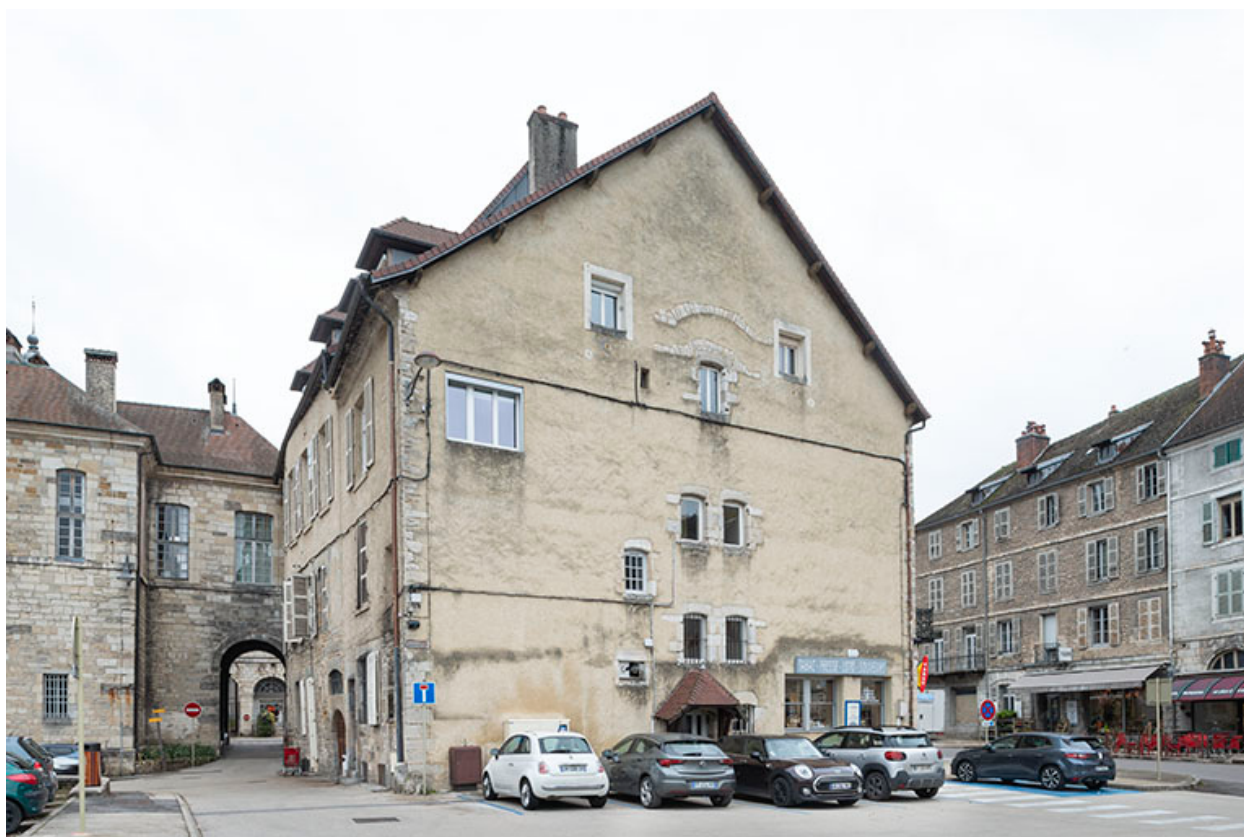
Mur pignon sud.
