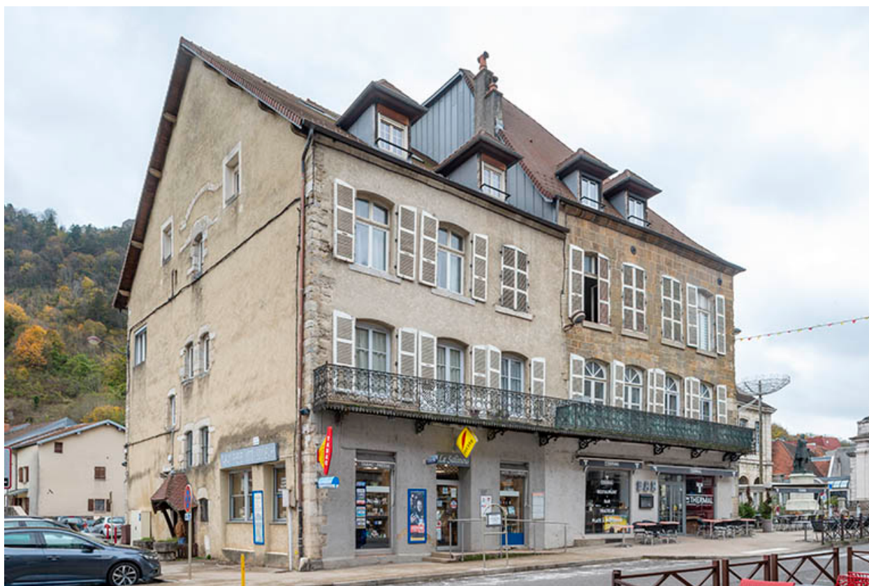
Vue de trois quarts, depuis le sud-est.
