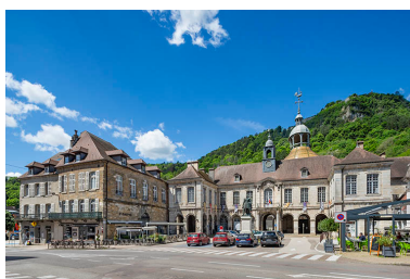
Vue d'ensemble, avec la place des Alliés. Phot. Jérôme Mongreville IVR43_20243900828NUC4A
