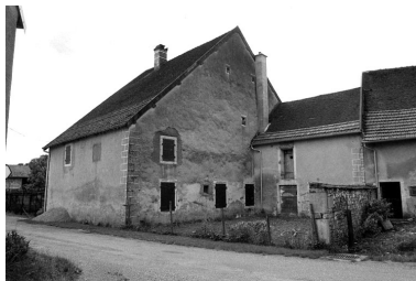
Façades postérieures et latérales droite. Phot. Bernard Lardière IVR43_19817000369Z
