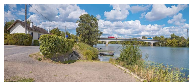
Rampe et perré du port. Phot. Thierry Kuntz IVR26_20207100363NUC4A
