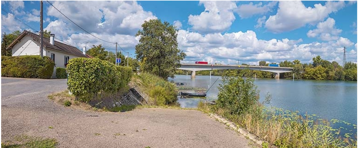
Rampe et perré du port.
