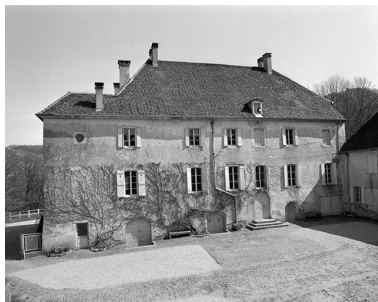
Logis : façade sur la cour. Phot. Jérôme Mongreville IVR43_19853900102X
