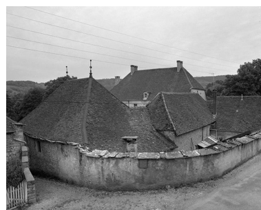
Les communs vus depuis la rue. Phot. Yves Sancey IVR43_19853900217X
