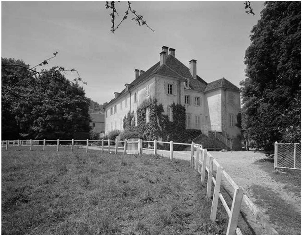
Logis : façades nord et ouest.
