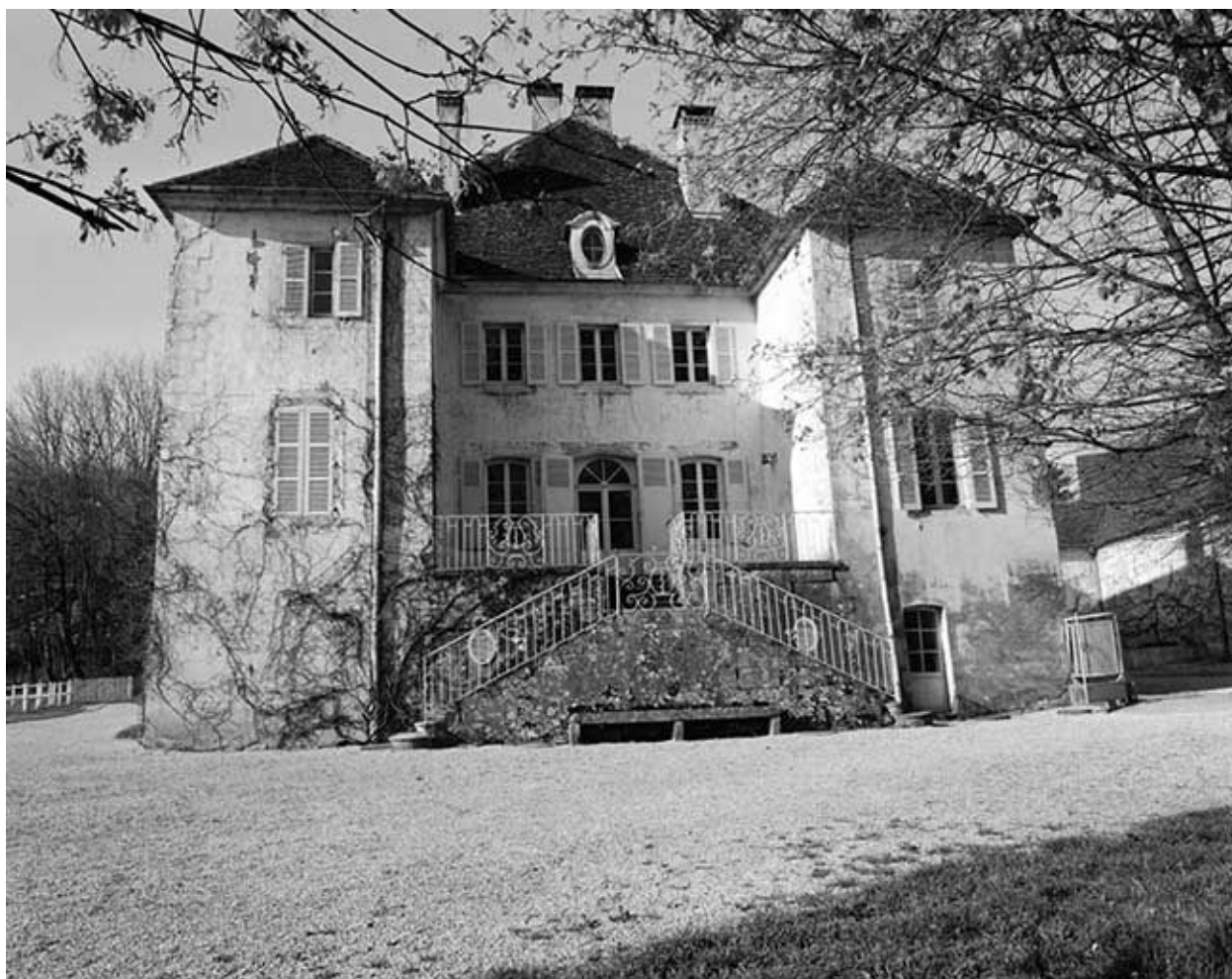
Logis : façade nord.
