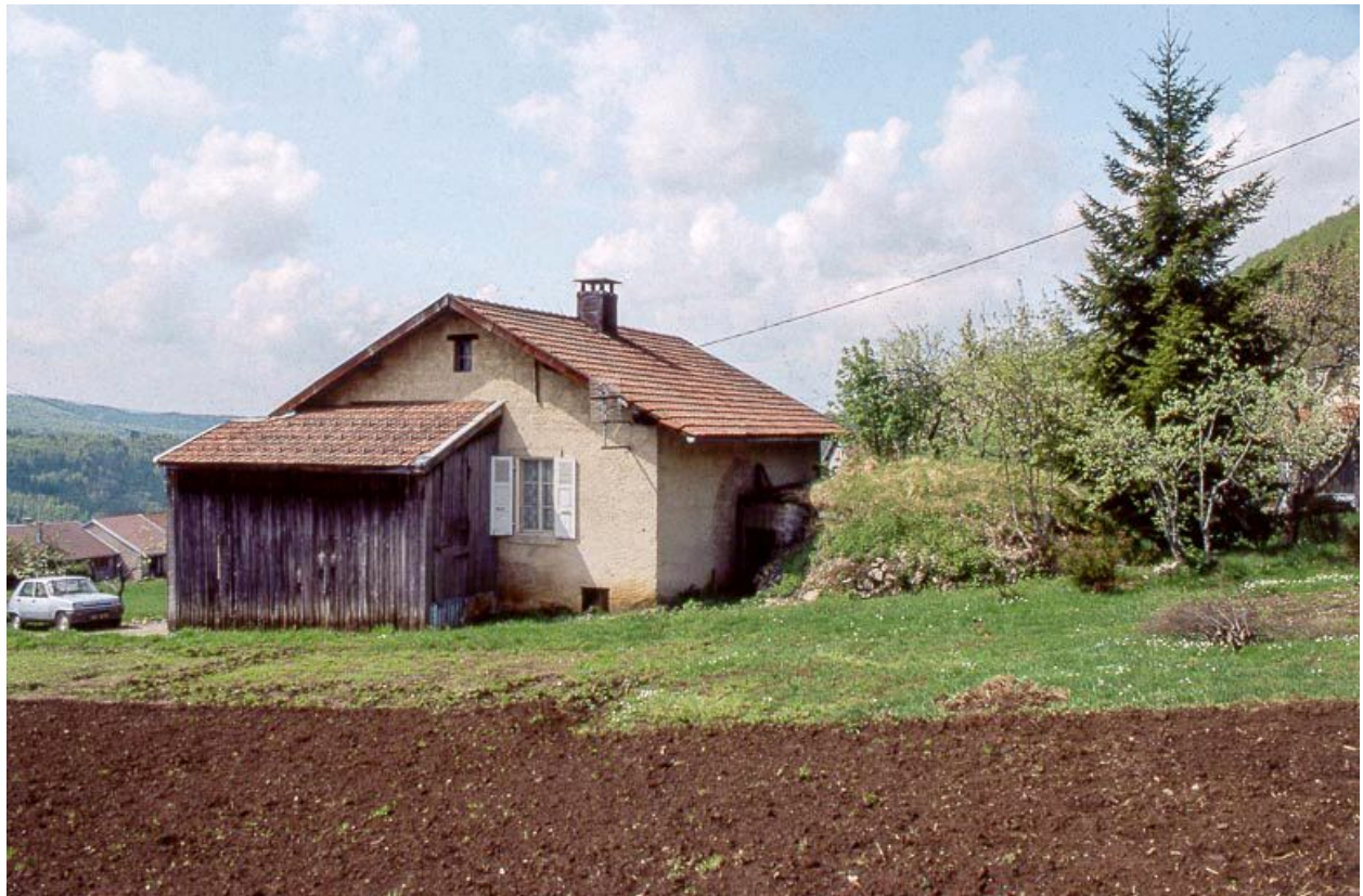
Façade postérieure et face droite.
