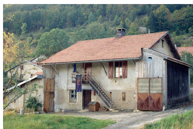
Façade antérieure. Phot. Laurent Poupard IVR43_19903900533ZA
