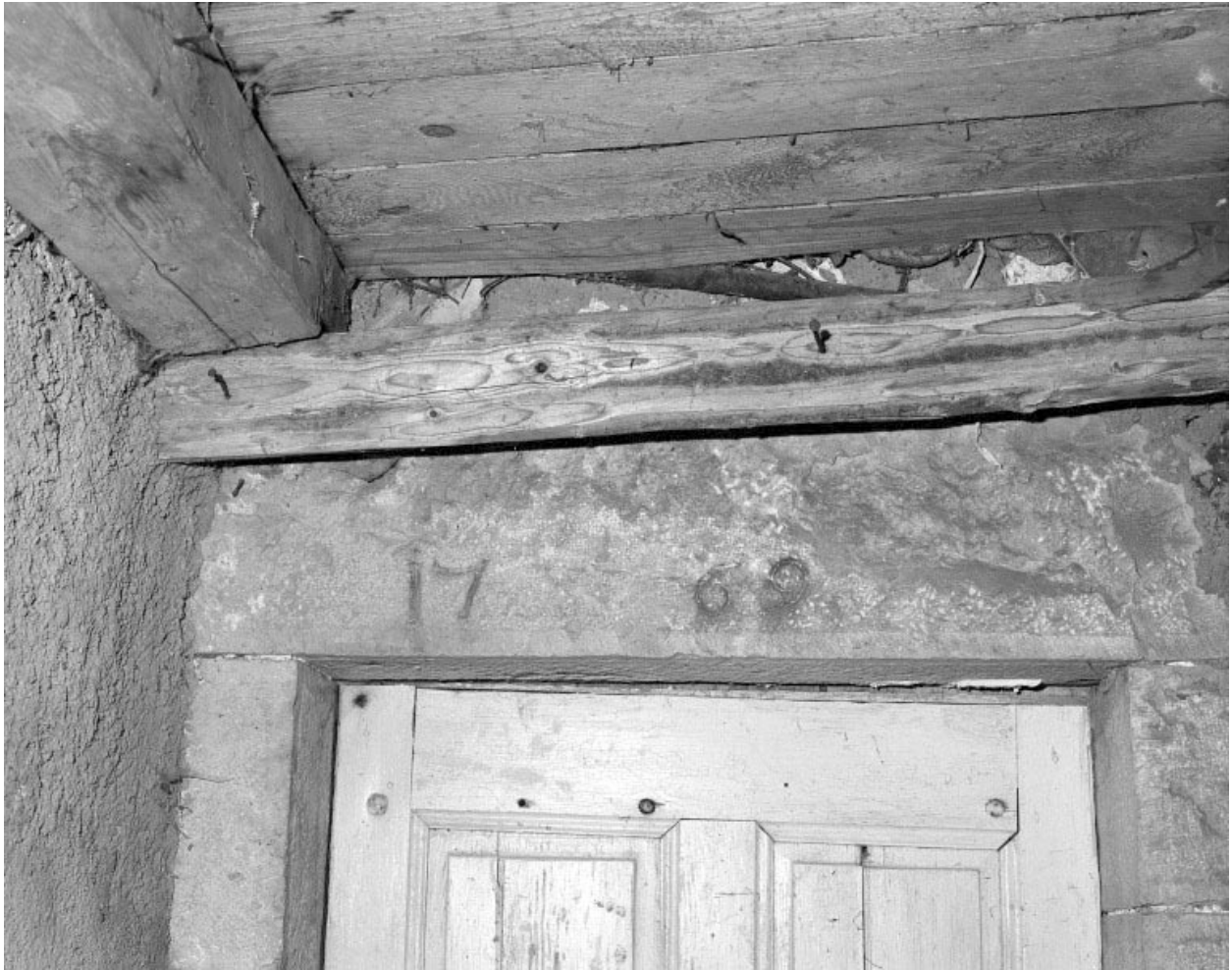
Porte d'accès au logis.
