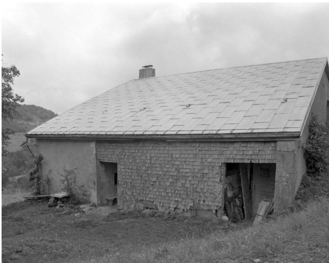
Façade antérieure avec galerie fermée en tavaillons.
