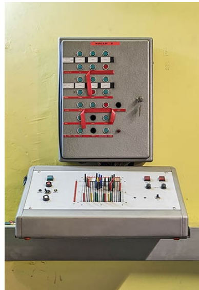
Pupitre à matrice à diodes et boîtier de commande à boutons poussoirs. Phot. Pierre-Marie Barbe-Richaud IVR26_20212100315NUC4A
