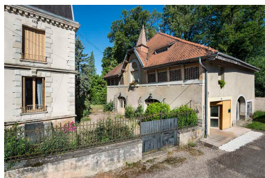
Vue d'ensemble. Phot. Jérôme Mongreville IVR43_20187000474NUC4A
