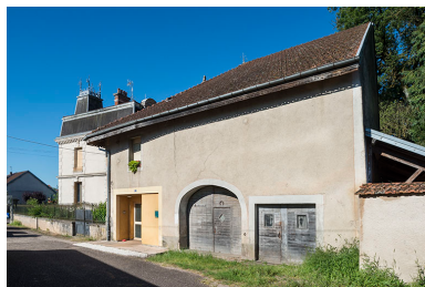
Élévation sur la rue. Phot. Jérôme Mongreville IVR43_20187000469NUC4A
