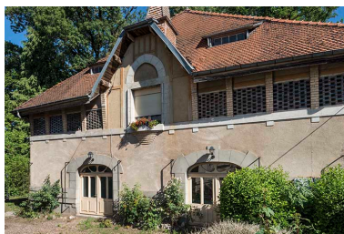
Façade principale. Phot. Jérôme Mongreville IVR43_20187000470NUC4A
