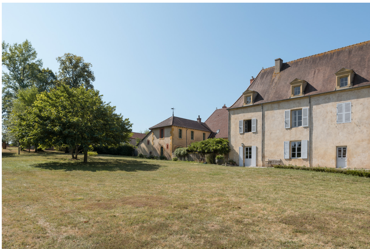
Vue d'ensemble des façades orientales postérieures.
