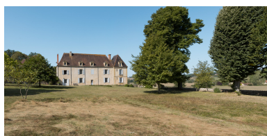
Vue d'ensemble du château depuis le parc au nord-est. Façade postérieure. Phot. Pierre-Marie Barbe-Richaud IVR26_20187100342NUC4AQ
