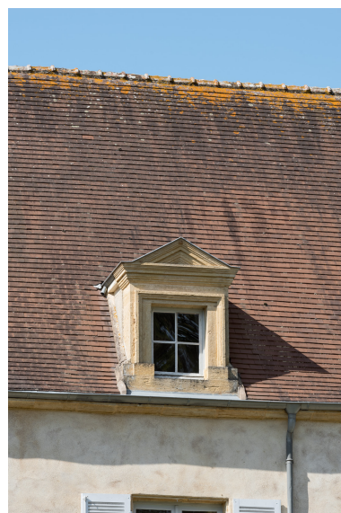
Détail de lucarne. Phot. Pierre-Marie Barbe-Richaud IVR26_20187100346NUC4A
