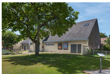
Decize : le Cinéal (rue des Halles). Phot. Pierre-Marie Barbe-Richaud IVR26_20235800227NUC4A
