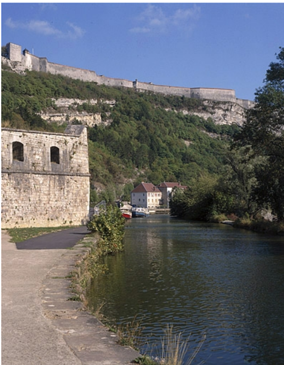
Vue d'ensemble depuis l'amont.
