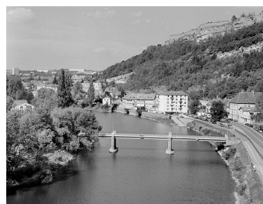
Vue d'ensemble plongeante depuis l'aval.
