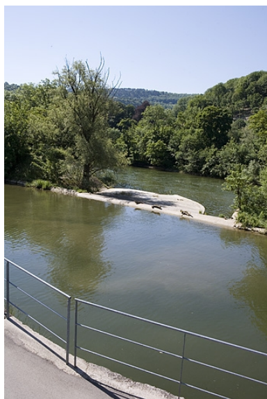
Le déversoir de superficie. Phot. Yves Sancey IVR43_20062500222NUCA
