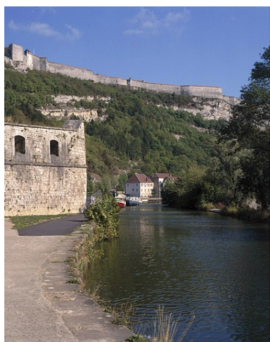
Vue d'ensemble depuis l'amont.
