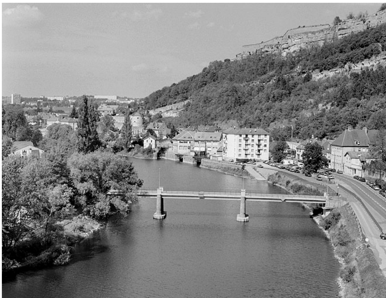
Vue d'ensemble plongeante depuis l'aval.
