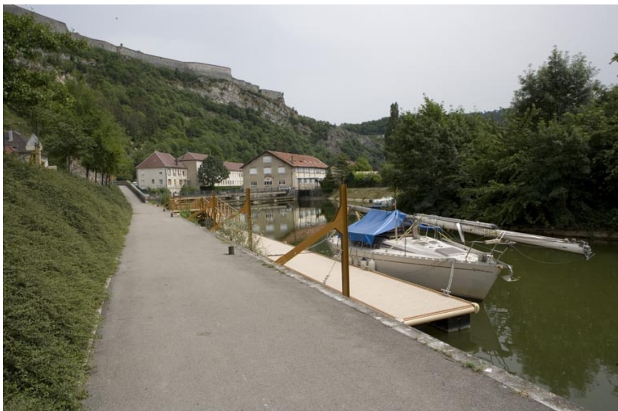
Vue d'ensemble rapprochée depuis l'amont.
