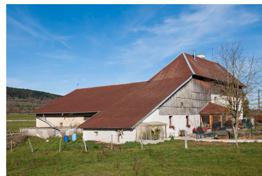
Ferme : façades sud et ouest. Phot. Jérôme Mongreville IVR43_20152502270NUC4A
