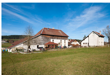
Ferme et atelier, depuis le nord. Phot. Jérôme Mongreville IVR43_20152502269NUC4A
