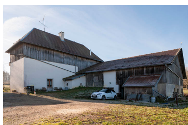
Ferme : façades nord et est. Phot. Jérôme Mongreville IVR43_20152502274NUC4A
