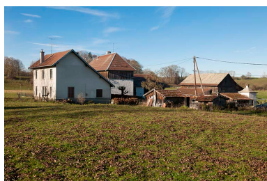
Atelier, ferme et remise agricole, depuis l'est. Phot. Jérôme Mongreville IVR43_20152502276NUC4A
