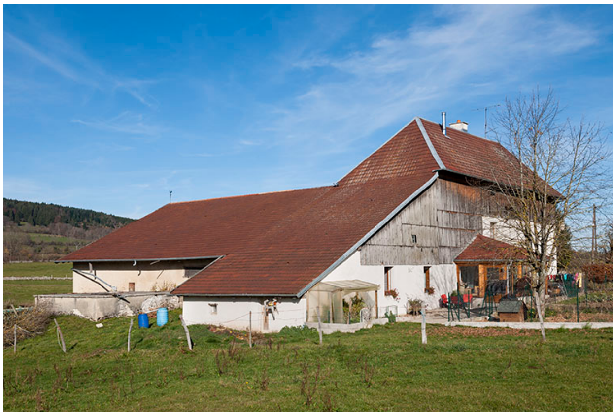
Ferme : façades sud et ouest.
