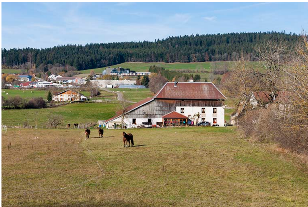
Vue d'ensemble du site, depuis le sud-est.
