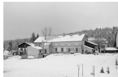
Façade postérieure. Phot. Laurent Poupard IVR43_19913901058Z
