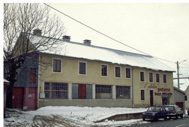
Façade antérieure. Phot. Laurent Poupard IVR43_19913901057ZA
