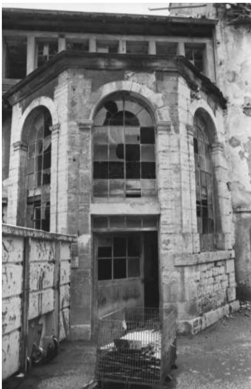
Atelier d'horlogerie. Détail de l'entrée en 1979.
