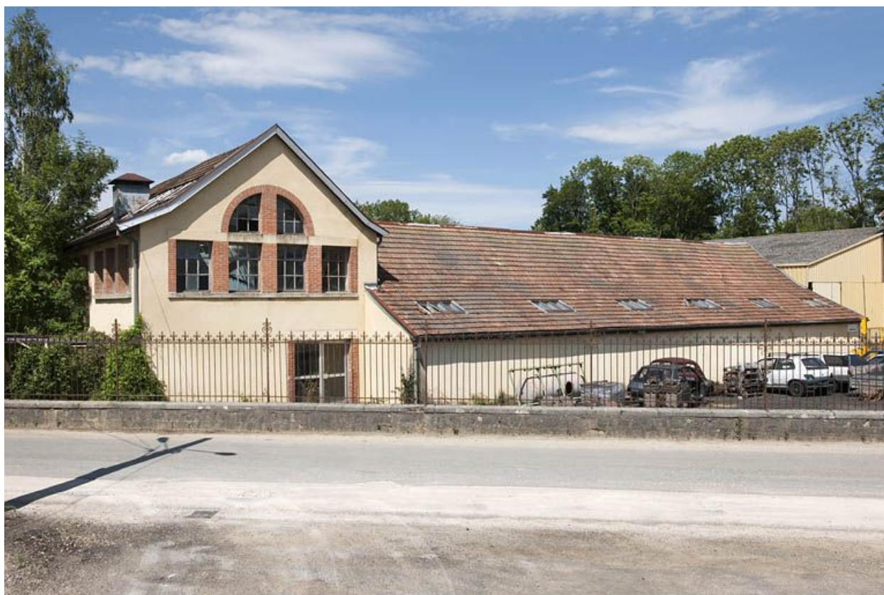
Atelier de fabrication (emboutissage, décolletage).
