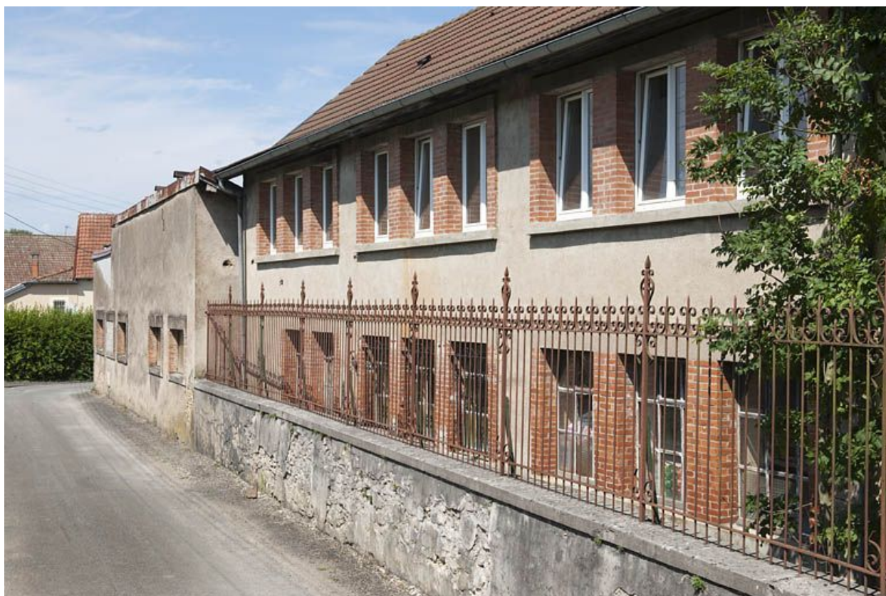
Façade ouest d'un bâtiment industriel (atelier).
