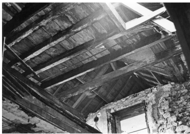
Atelier de fabrication : détail de la charpente. Photogr., 1978.
