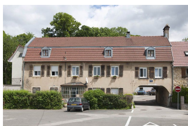
Logement patronal. Phot. Jérôme Mongreville IVR43_20122501008NUC4A
