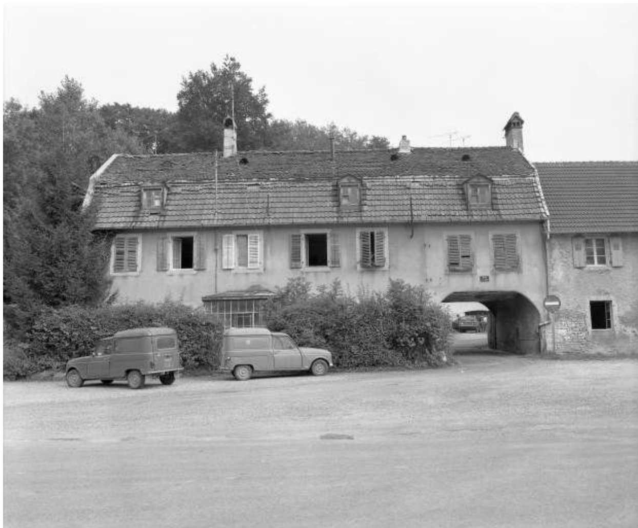
Maison de direction. Vue de face en 1981.
