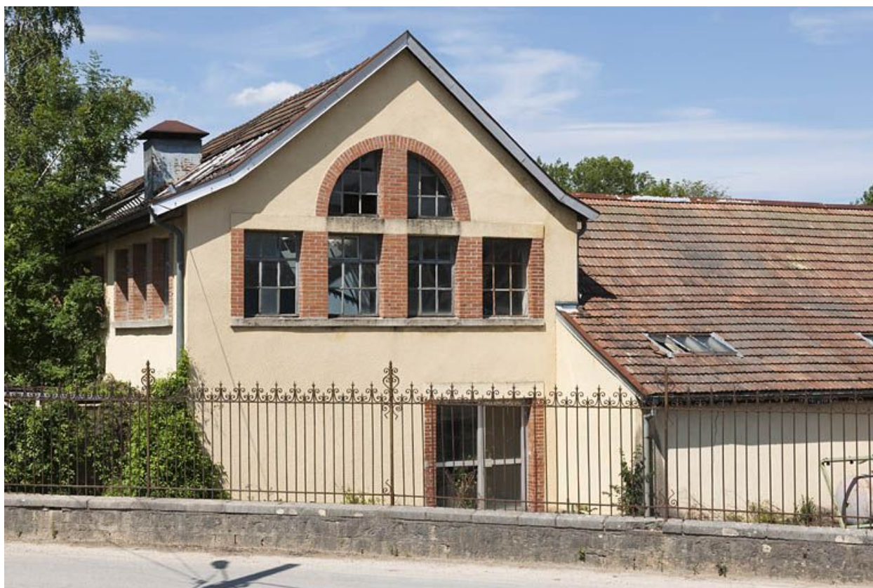
Pignon sud d'un bâtiment industriel (atelier).
