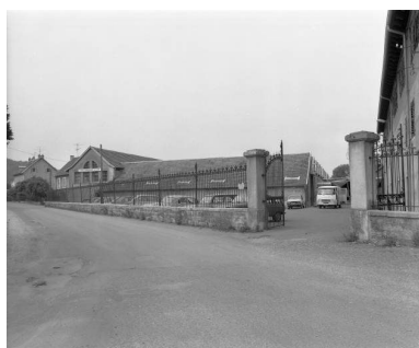
Ateliers en rez-de-chaussée depuis le sud en 1981. Phot. Yves Sancey IVR43_19812500485X
