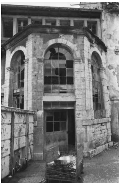
Atelier d'horlogerie. Détail de l'entrée en 1979.
