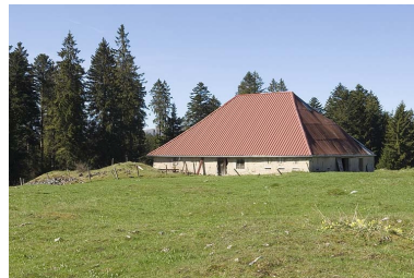
Ferme (chalet d'estive) de la Ravette. Phot. Jérôme Mongreville IVR43_20092500479NUC2A
