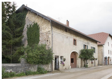
Ferme au 4 rue du Faubourg (2008 AB 47). Phot. Jérôme Mongreville IVR43_20092500795NUC2A
