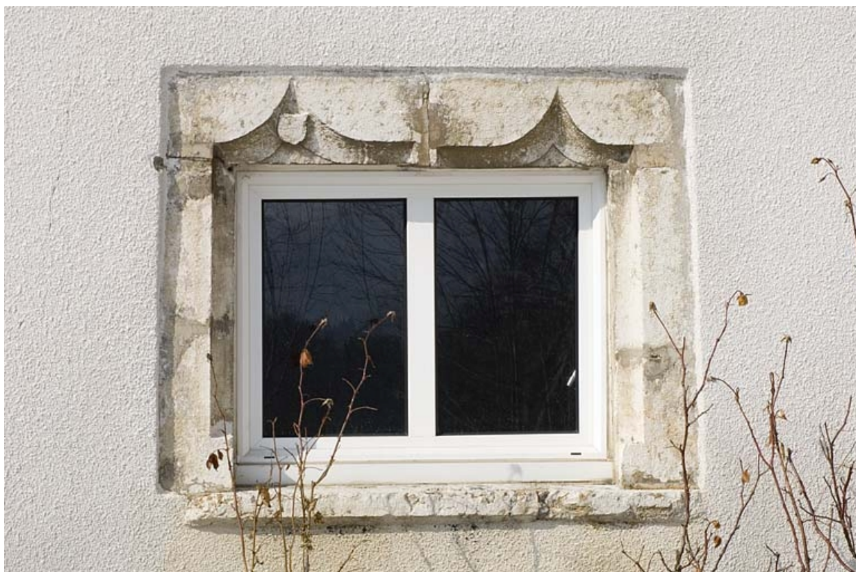
Ferme à Entre-les-Fourgs : baie du 16e siècle.
