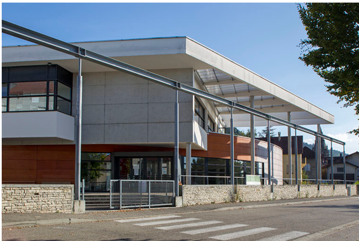
Restauration : façades sur rue.
