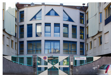
Internat : façade Nord, détail. Phot. Sonia Dourlot IVR43_20143900755NUC2A
