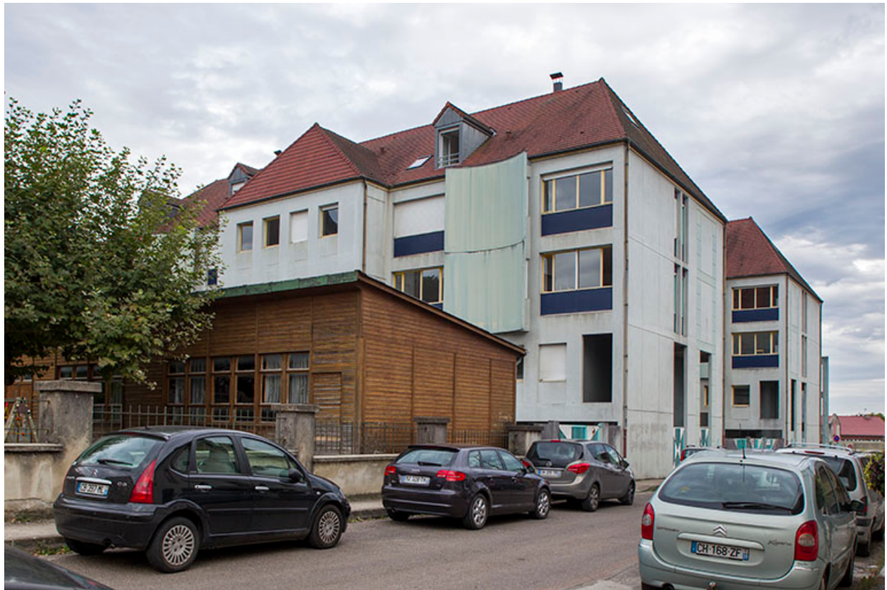
Internat : façades arrière.
