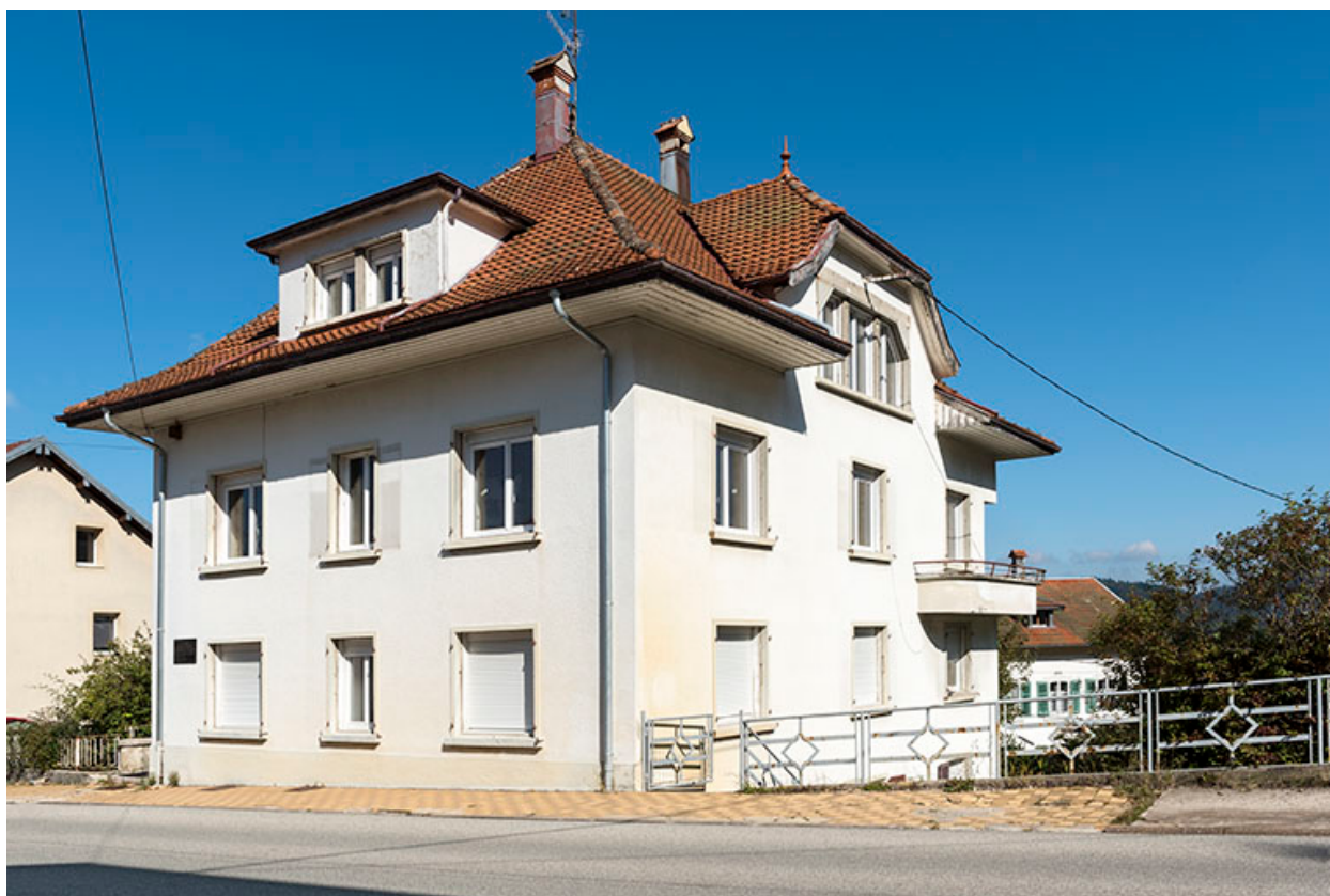
Façades antérieure et latérale droite.
