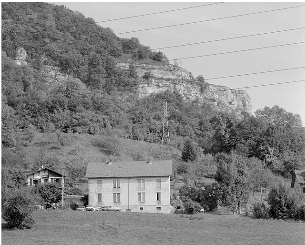
Logement ouvrier collectif depuis l'ouest.
