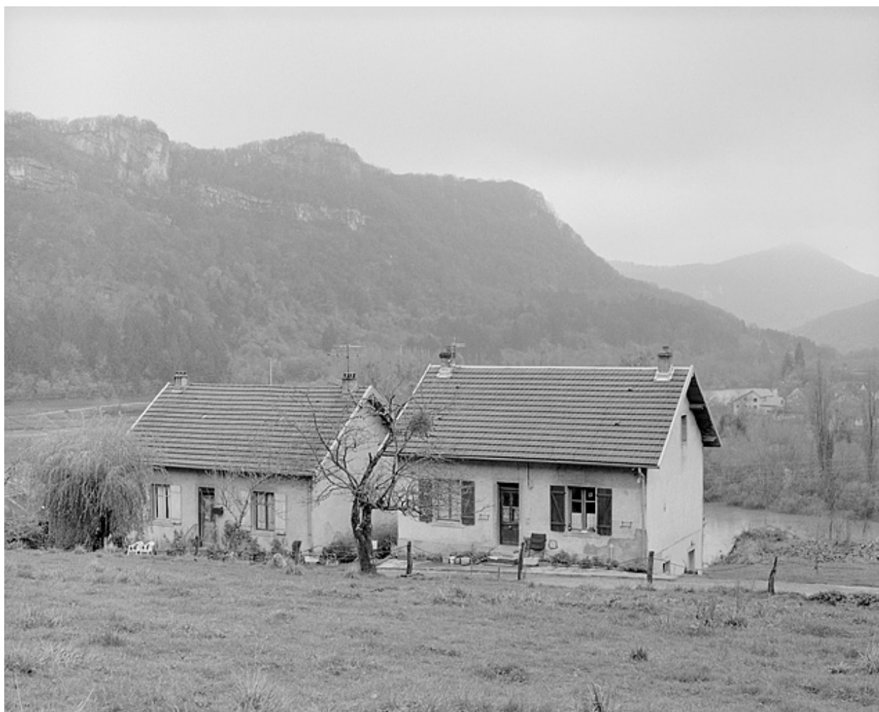
Vue d'ensemble des logements ouvriers individuels.
