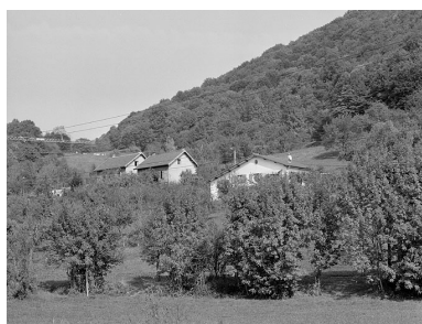
Logements ouvriers individuels en haut de la rue. Phot. Yves Sancey IVR43_20022500700X
