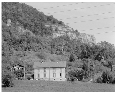
Logement ouvrier collectif depuis l'ouest. Phot. Yves Sancey IVR43_20022500699X
