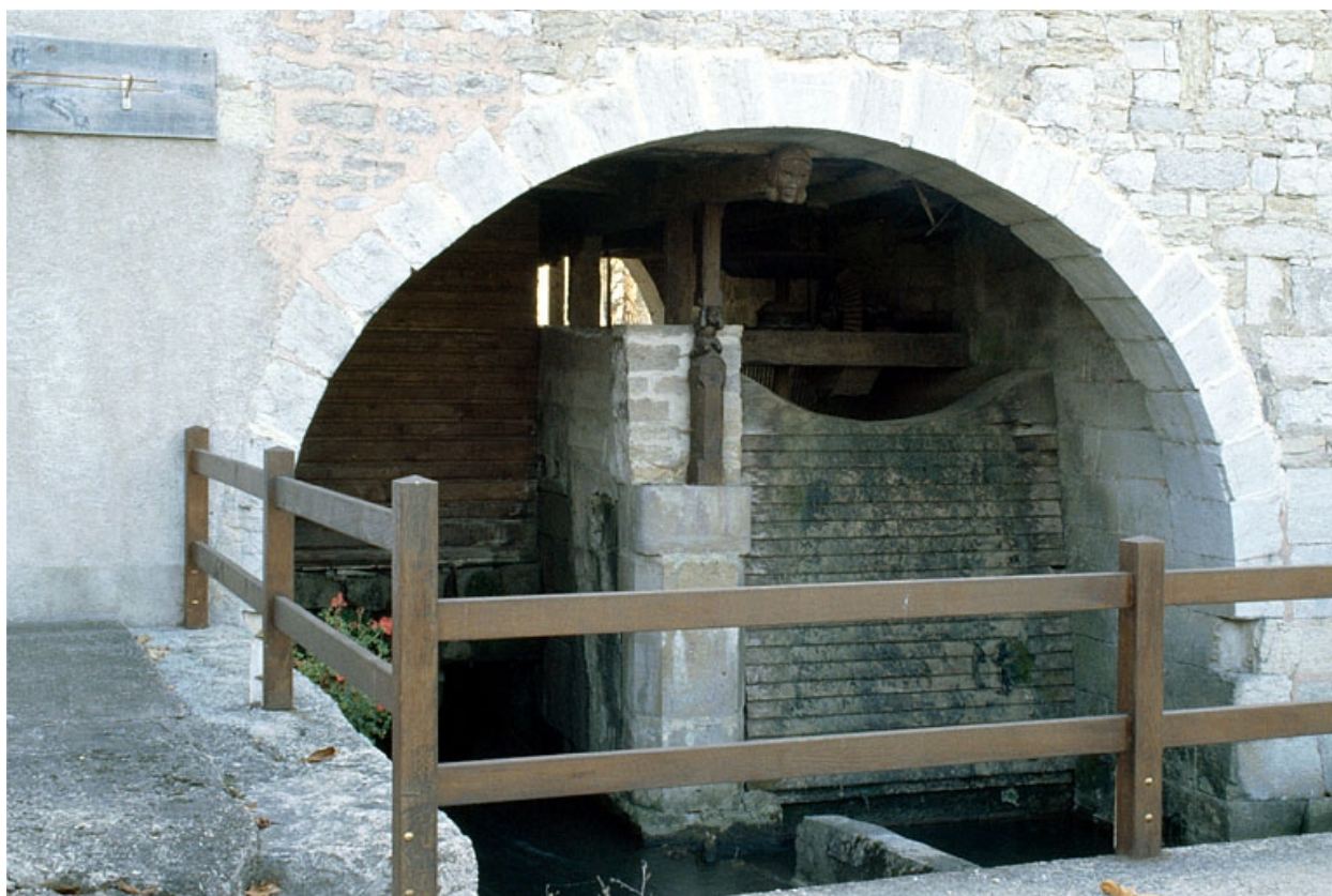
Chambre d'eau de la turbine, depuis l'aval.
