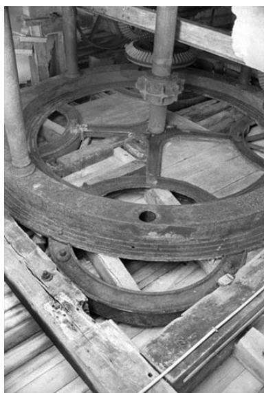
Minoterie, rez-de-chaussée : support des meules et transmission (beffroi). Phot. Laurent Poupard IVR43_19883900644Z
