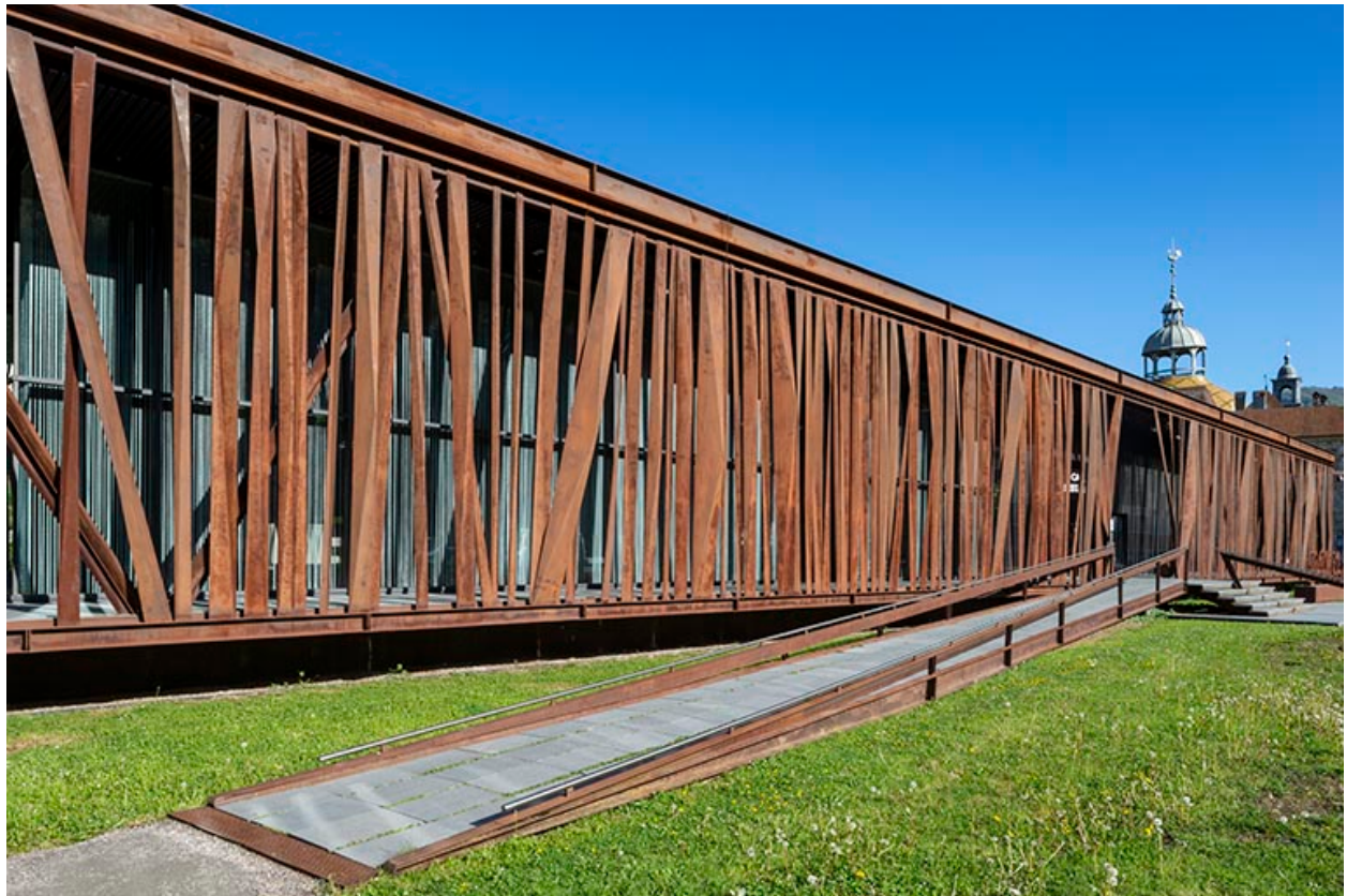
Vue depuis le sud-est.
