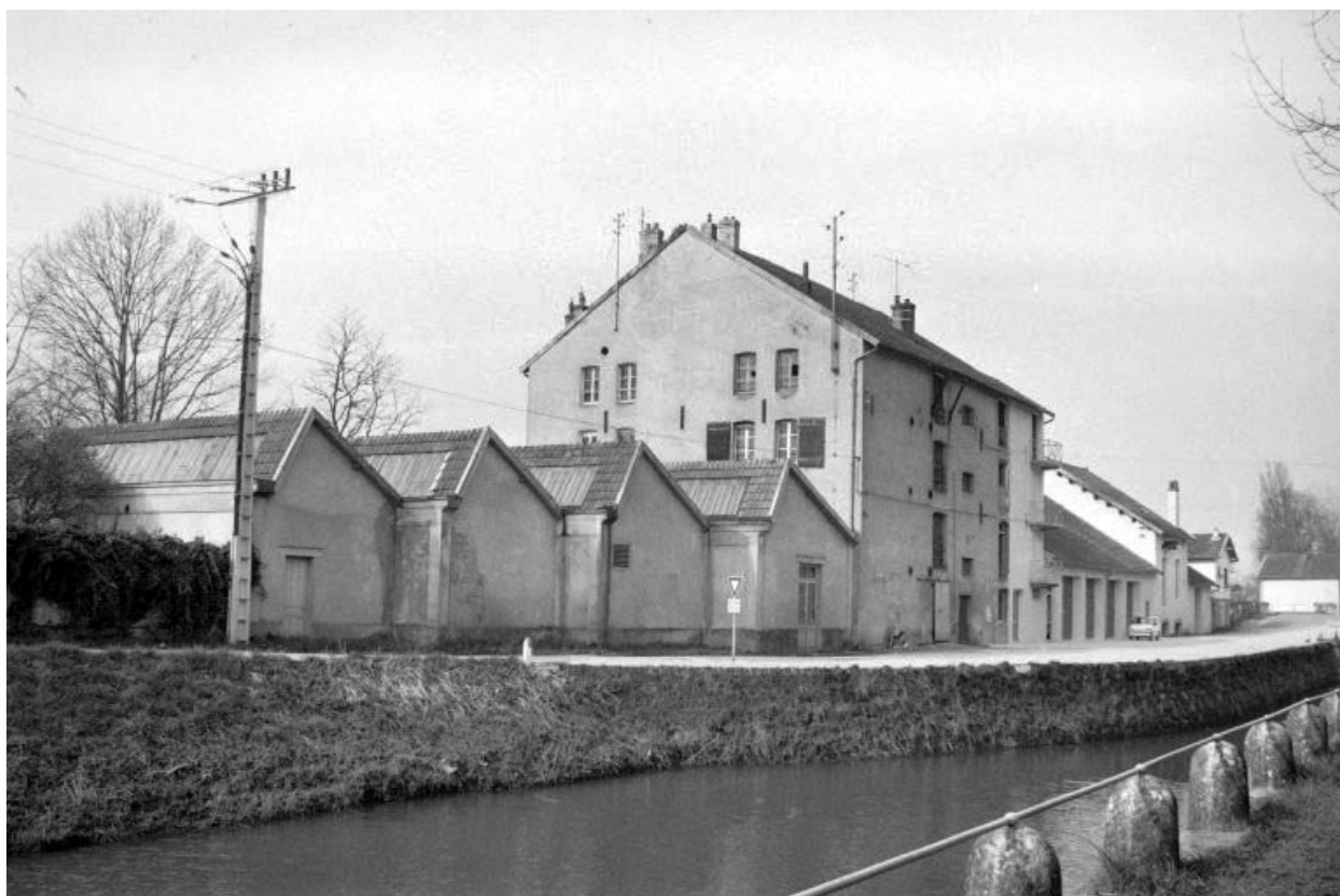
Façade antérieure vue de l'est.
