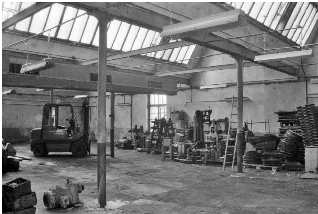
Vue intérieure des ateliers couverts en shed.
