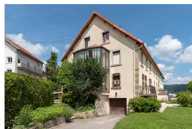
Ancien site : façades latérale droite et postérieure.
