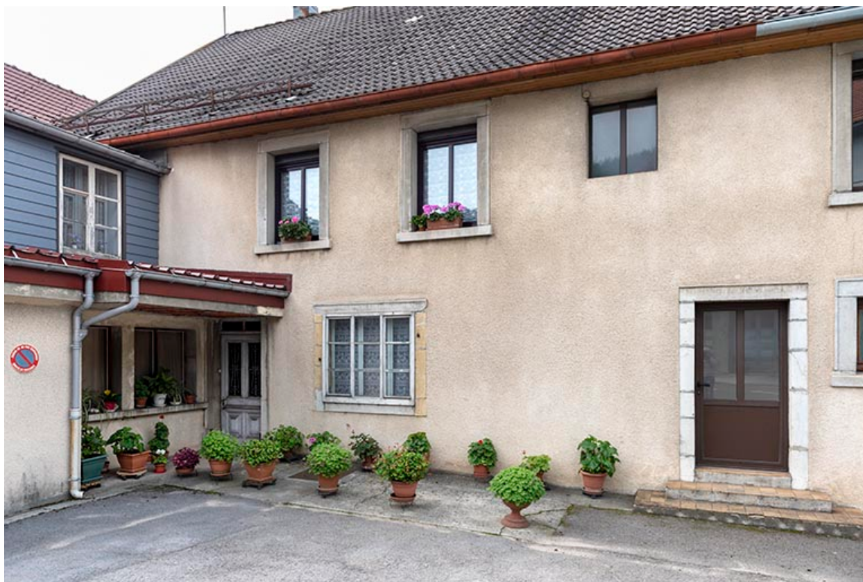
Ancien site : façade antérieure de la fonderie.
