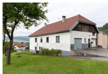
Ancien site : ferme, vue du nord-est. Phot. Sonia Dourlot IVR43_20182500969NUC4A
