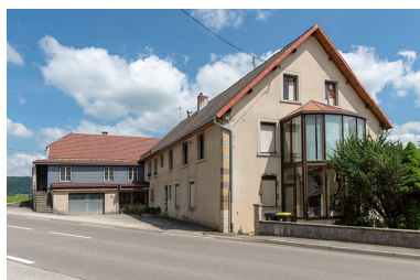
Ancien site : vue d'ensemble depuis l'ouest.
