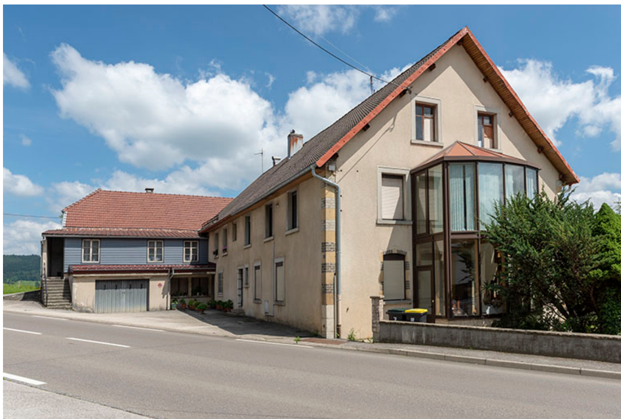
Ancien site : vue d'ensemble depuis l'ouest.
