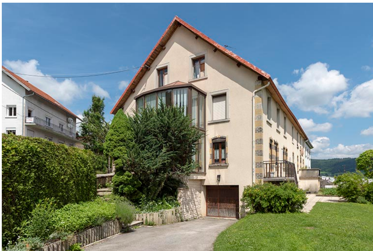
Ancien site : façades latérale droite et postérieure.
