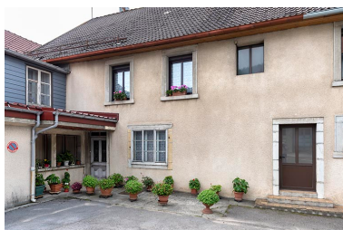
Ancien site : façade antérieure de la fonderie.
