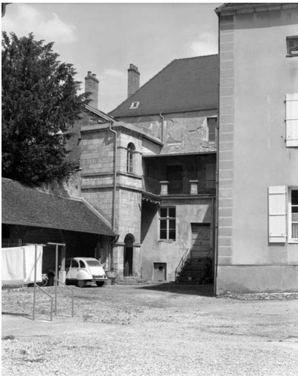
Façade antérieure : détail.
