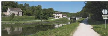
Le pont isolé de Crugey vu d'aval. Phot. Thierry Kuntz IVR26_20122102337NUC4AQ
