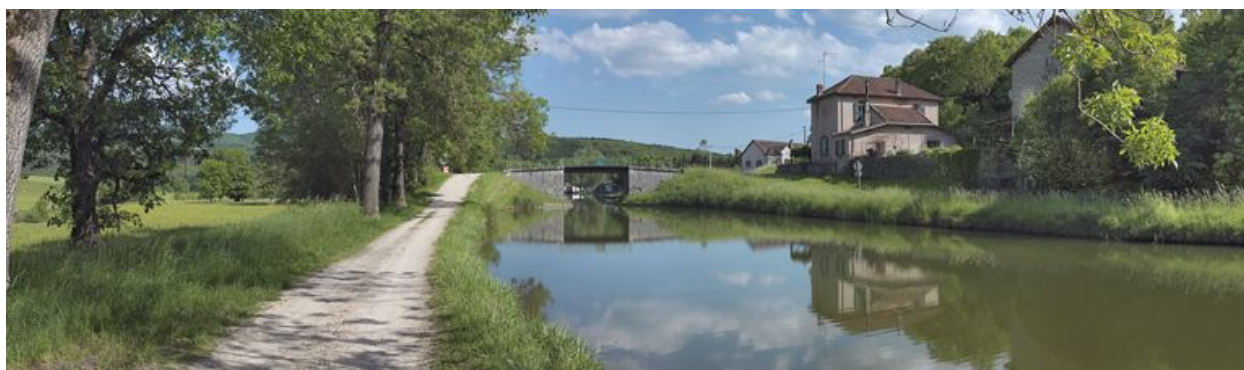
Le pont isolé de Crugey vu d'amont.
