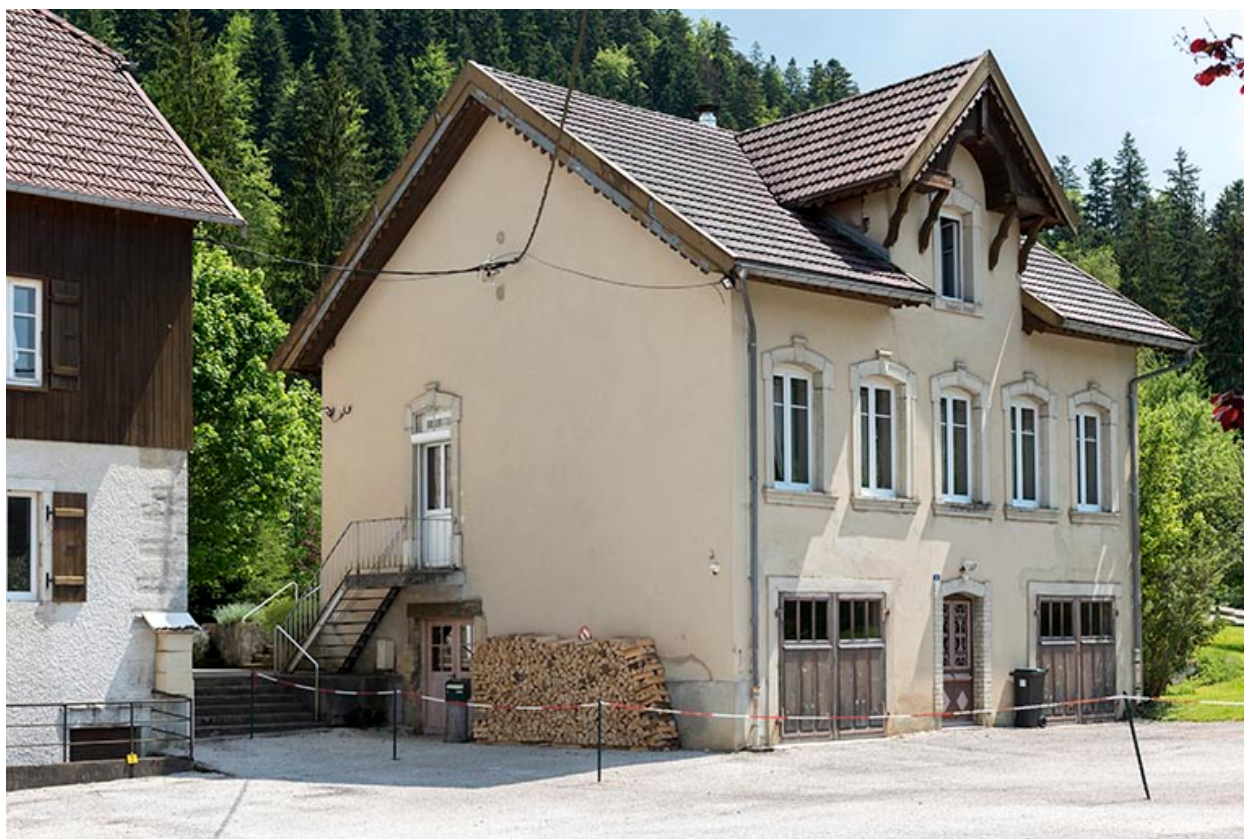
Maison : façades antérieure et latérale gauche.
