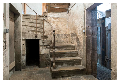
Chaudronnerie : escalier, au sous-sol. Phot. Sonia Dourlot IVR43_20172500760NUC4A
