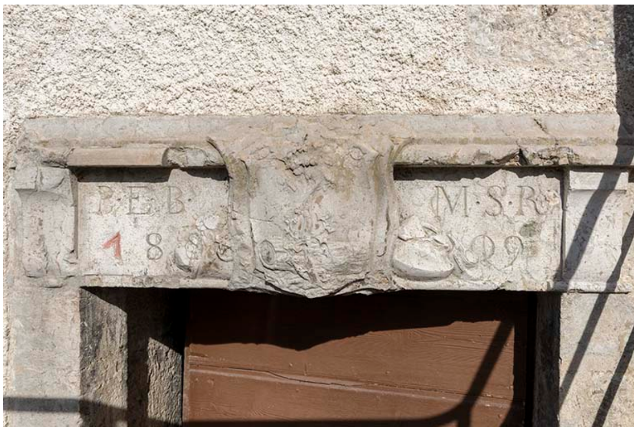
Chaudronnerie, façade antérieure : linteau daté 1809.
