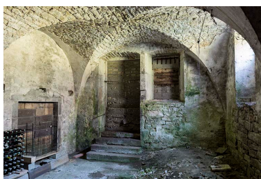
Chaudronnerie : cave voûtée. Phot. Sonia Dourlot IVR43_20172500759NUC4A
