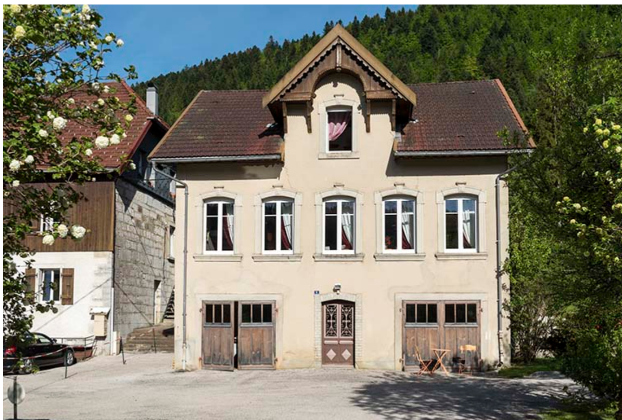
Maison : façade antérieure.
