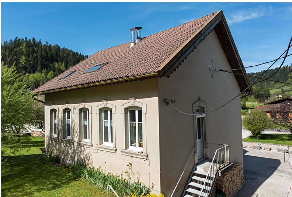
Maison : façades postérieure et latérale gauche.
