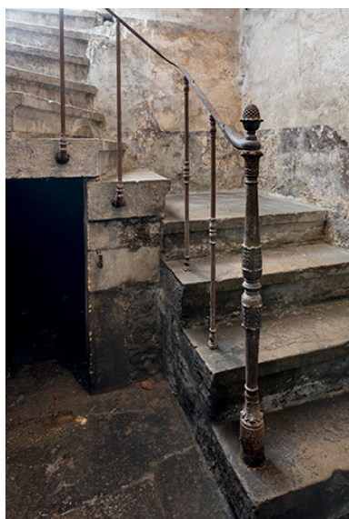
Chaudronnerie : rampe d'appui de l'escalier, au sous-sol. Phot. Sonia Dourlot IVR43_20172500761NUC4A
