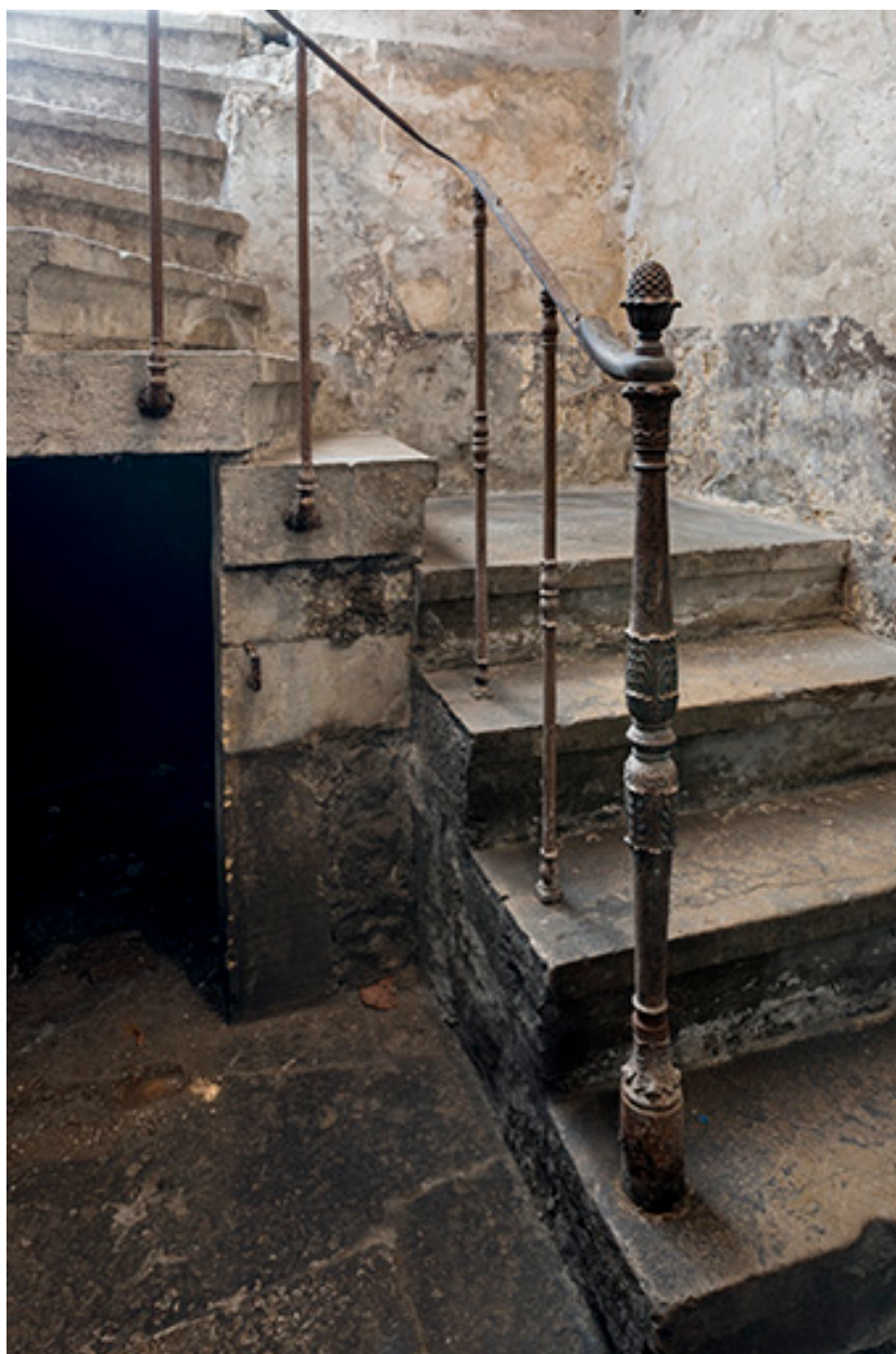
Chaudronnerie : rampe d'appui de l'escalier, au sous-sol.
