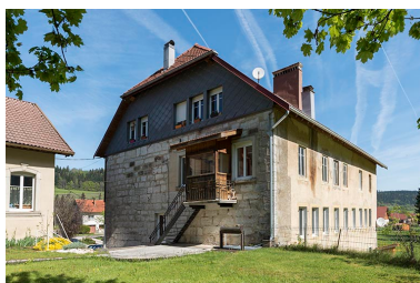
Chaudronnerie : façades postérieure et latérale gauche. Phot. Sonia Dourlot IVR43_20172500753NUC4A
