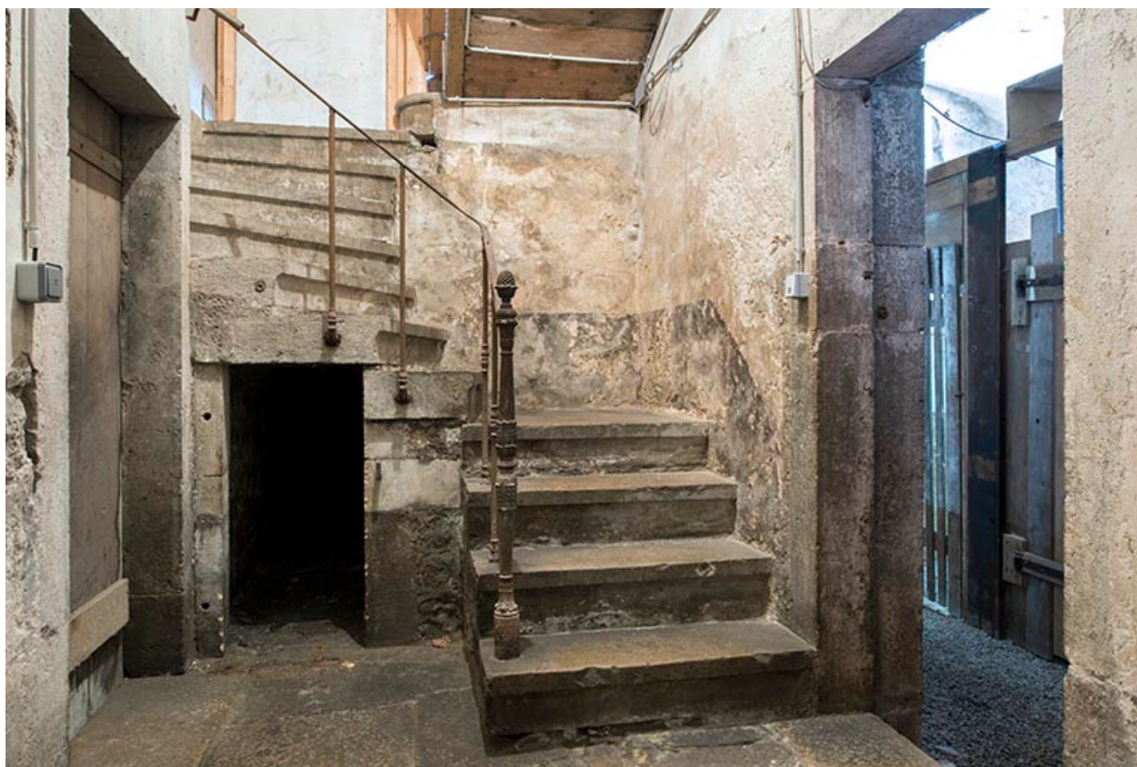
Chaudronnerie : escalier, au sous-sol.
