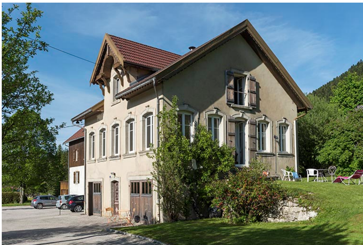
Maison : façades antérieure et latérale droite.
