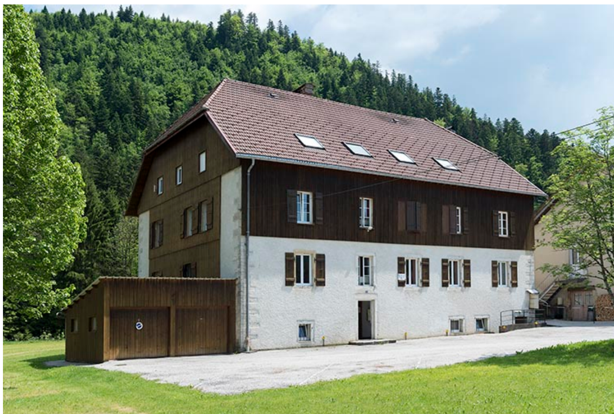
Chaudronnerie : façades antérieure et latérale gauche.
