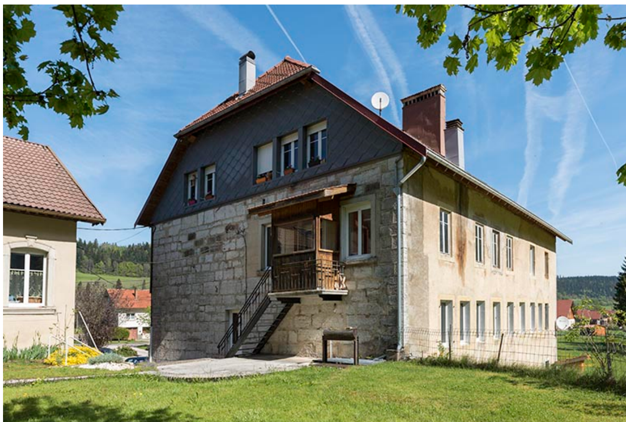
Chaudronnerie : façades postérieure et latérale gauche.
