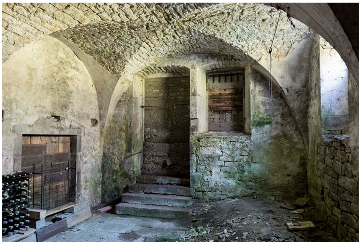
Chaudronnerie : cave voûtée.
