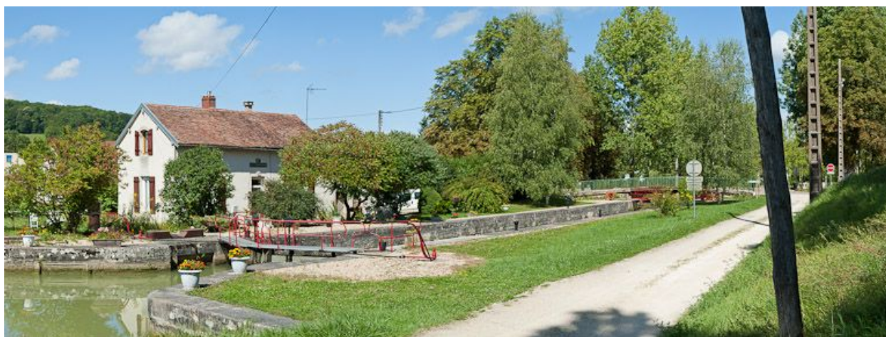
Vue d'ensemble du site d'écluse.
