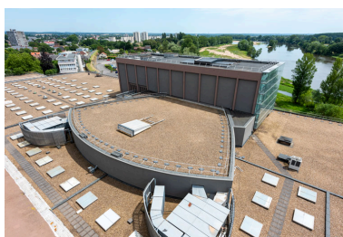
Maison de la culture : vue plongeante sur le haut de la salle et la cage de scène, depuis la bourse du travail. Phot. Pierre-Marie Barbe-Richaud IVR26_20245800891NUC4A
