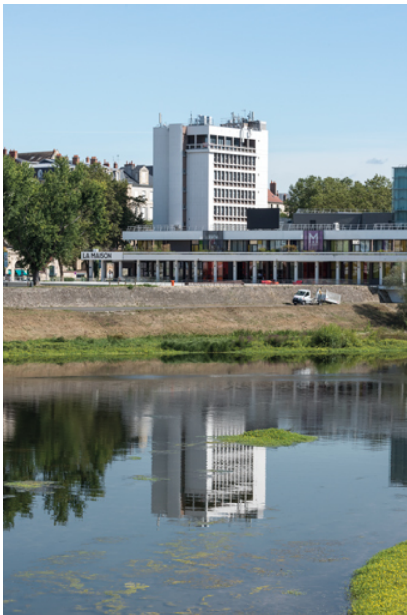
Bourse du travail : façades postérieure et latérale droite.
