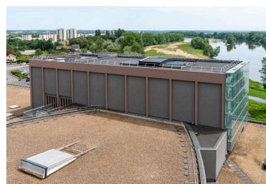
Maison de la culture : vue plongeante rapprochée sur la cage de scène, depuis la bourse du travail. Phot. Pierre-Marie Barbe-Richaud IVR26_20245800892NUC4A
