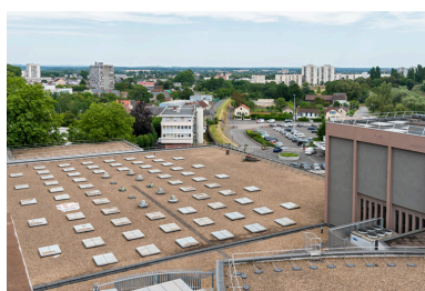
Maison des sports : vue plongeante sur le toit, depuis la bourse du travail. Phot. Pierre-Marie Barbe-Richaud IVR26_20245800893NUC4A
