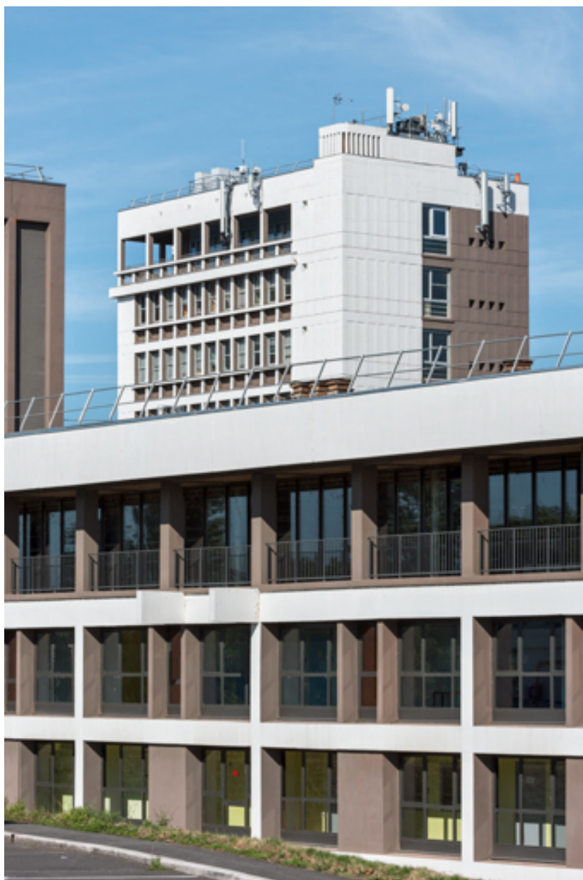
Bourse du travail : façades postérieure et latérale gauche.
