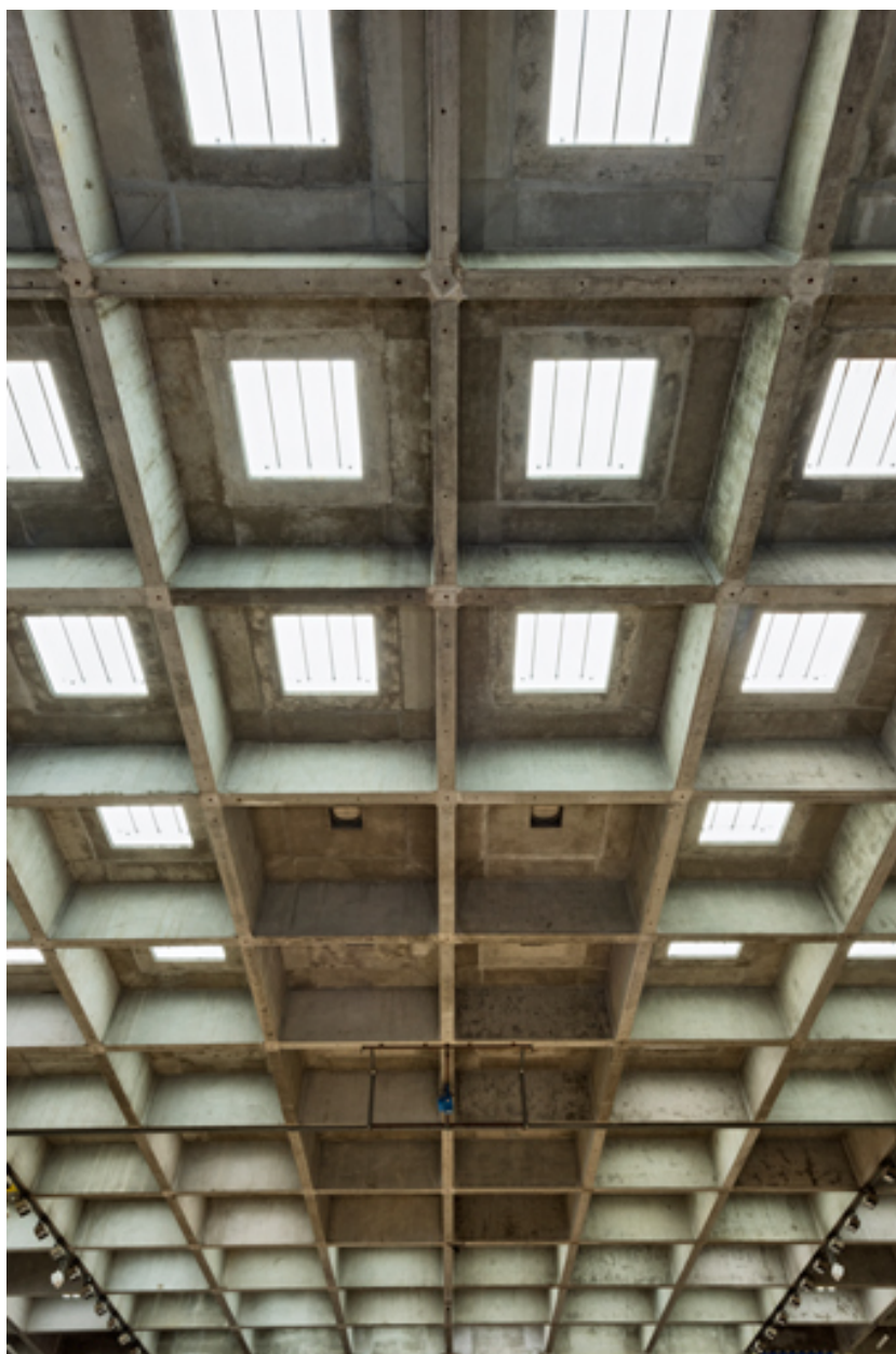
Maison des sports, grand gymnase : plafond.
