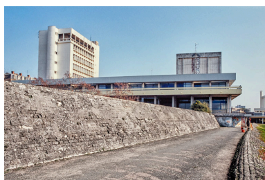
Façade latérale droite, vue en contre-bas de la levée de Médine, en 2000. Phot. Jean-Luc Duthu IVR26_20025800123ZA
