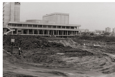
Maison de la culture et des sports. Construction. Aménagement des abords. 1971.
