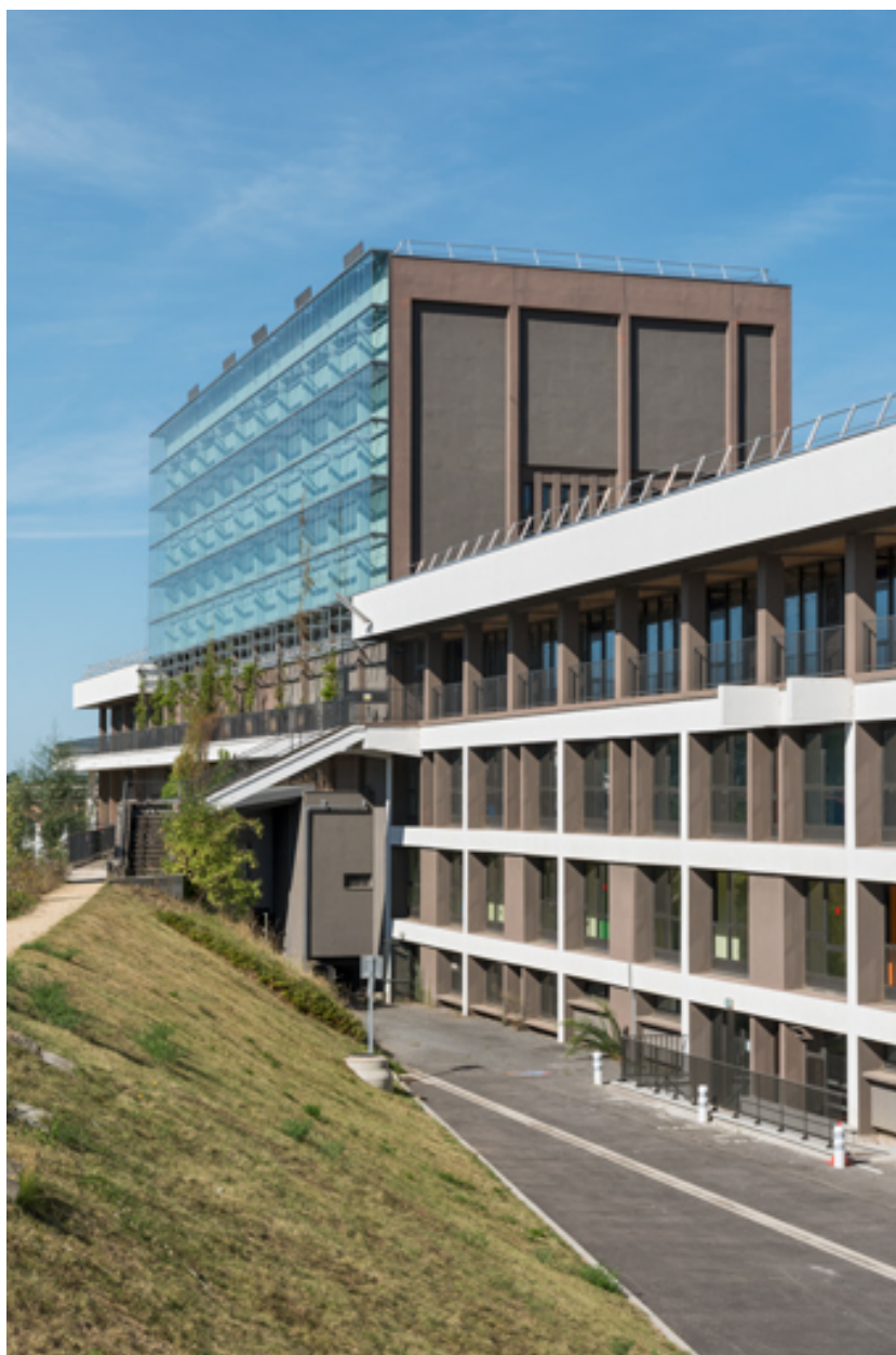
Maison de la culture : cage de scène (façades postérieure et latérale gauche), vue en enfilade.
