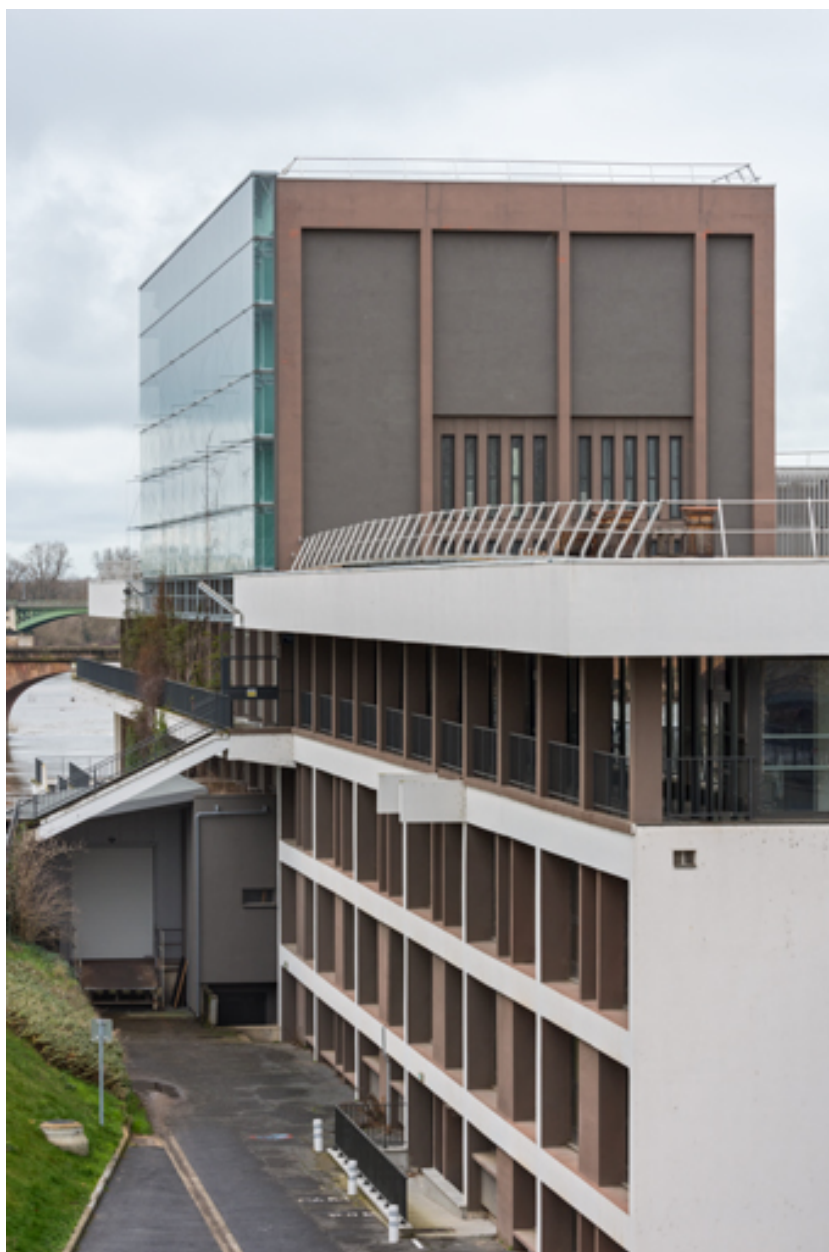
Maison de la culture : cage de scène (façades postérieure et latérale gauche), vue plongeante en enfilade.
