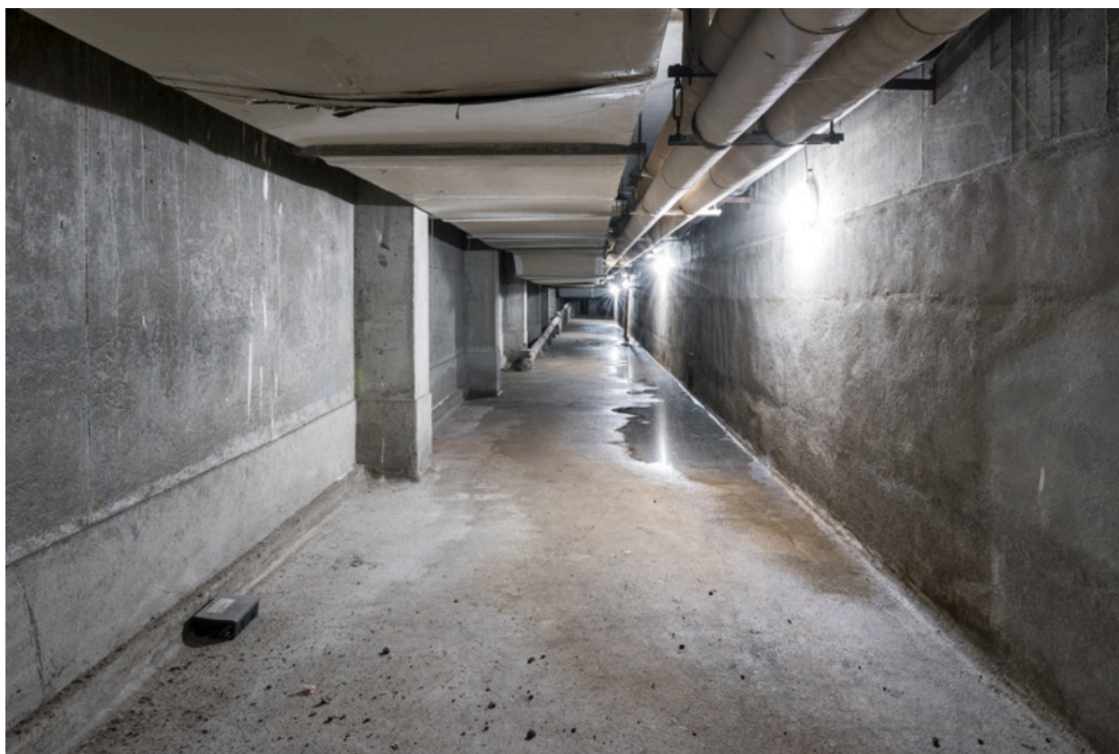
Maison des sports : galerie technique (étage de soubassement côté RN). Le couloir se situe derrière le mur à gauche.
