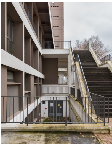
Maison des sports : accès extérieur aux gradins. Phot. Pierre-Marie Barbe-Richaud IVR26_20245800009NUC4A
