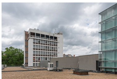
Bourse du travail, depuis le toit. Phot. Pierre-Marie Barbe-Richaud IVR26_20245800942NUC4A
