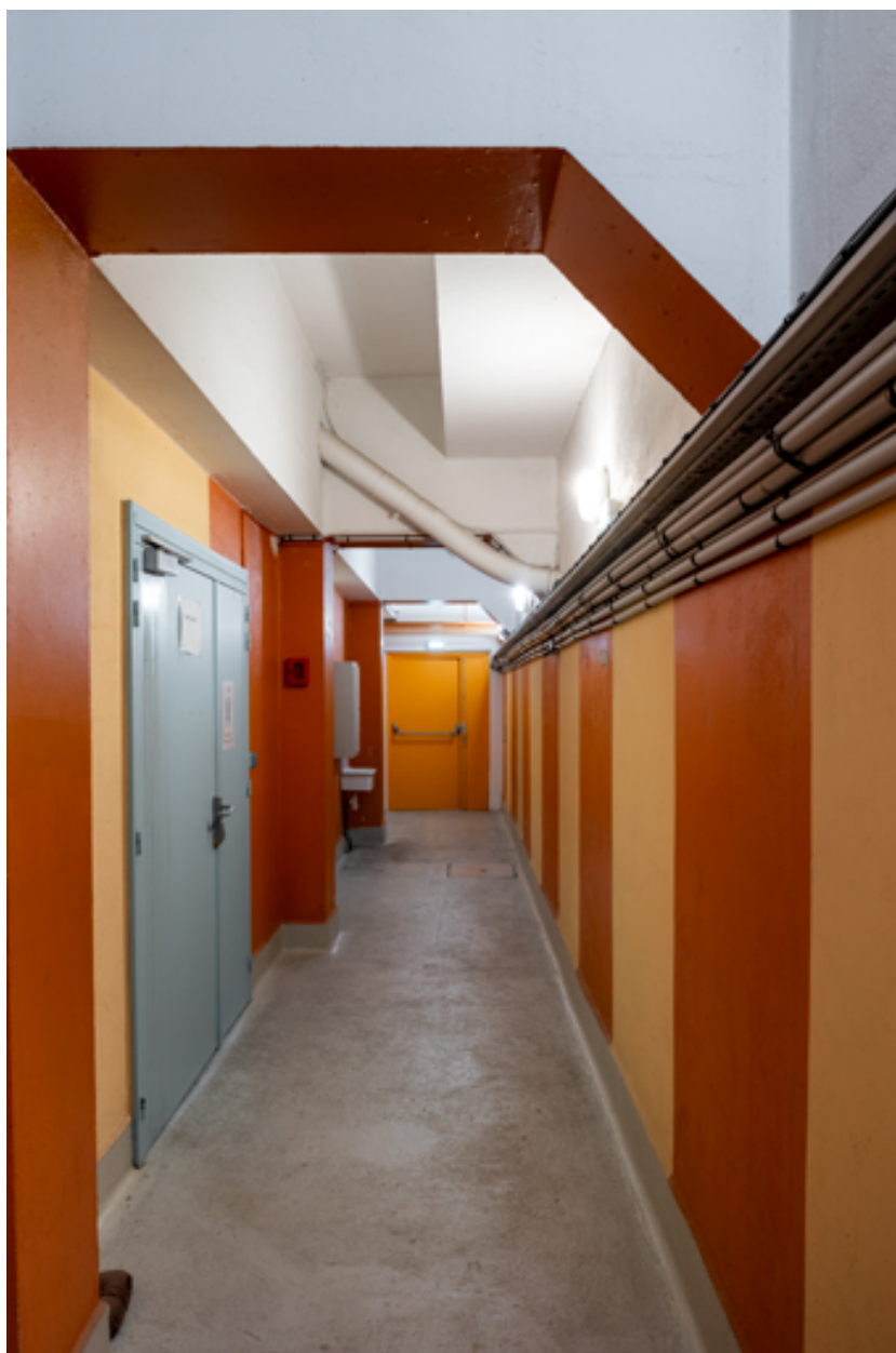
Maison des sports : couloir (étage de soubassement côté RN).
