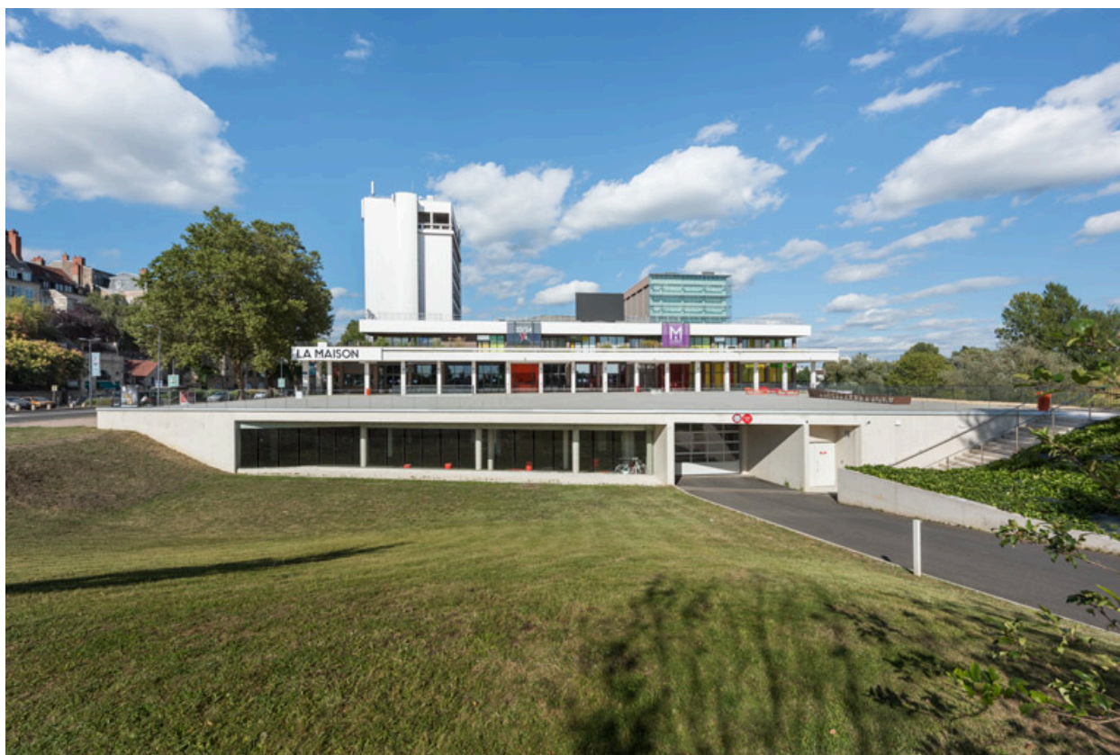
Façade latérale droite.
