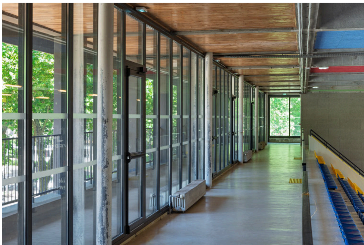
Maison des sports, grand gymnase : galerie vitrée en haut des gradins côté RN.
