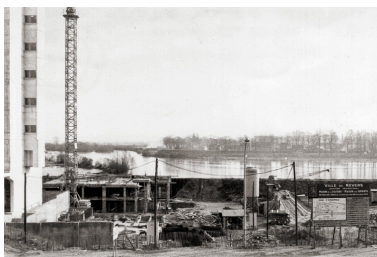
Maison de la culture et des sports. Construction [chantier de la maison de la culture]. Fin janvier 1967.
