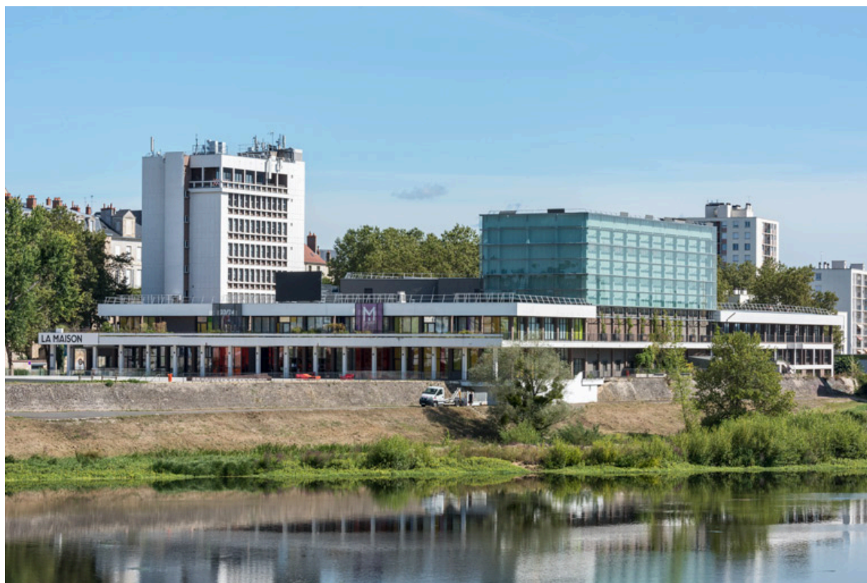
Façades postérieure et latérale droite.
