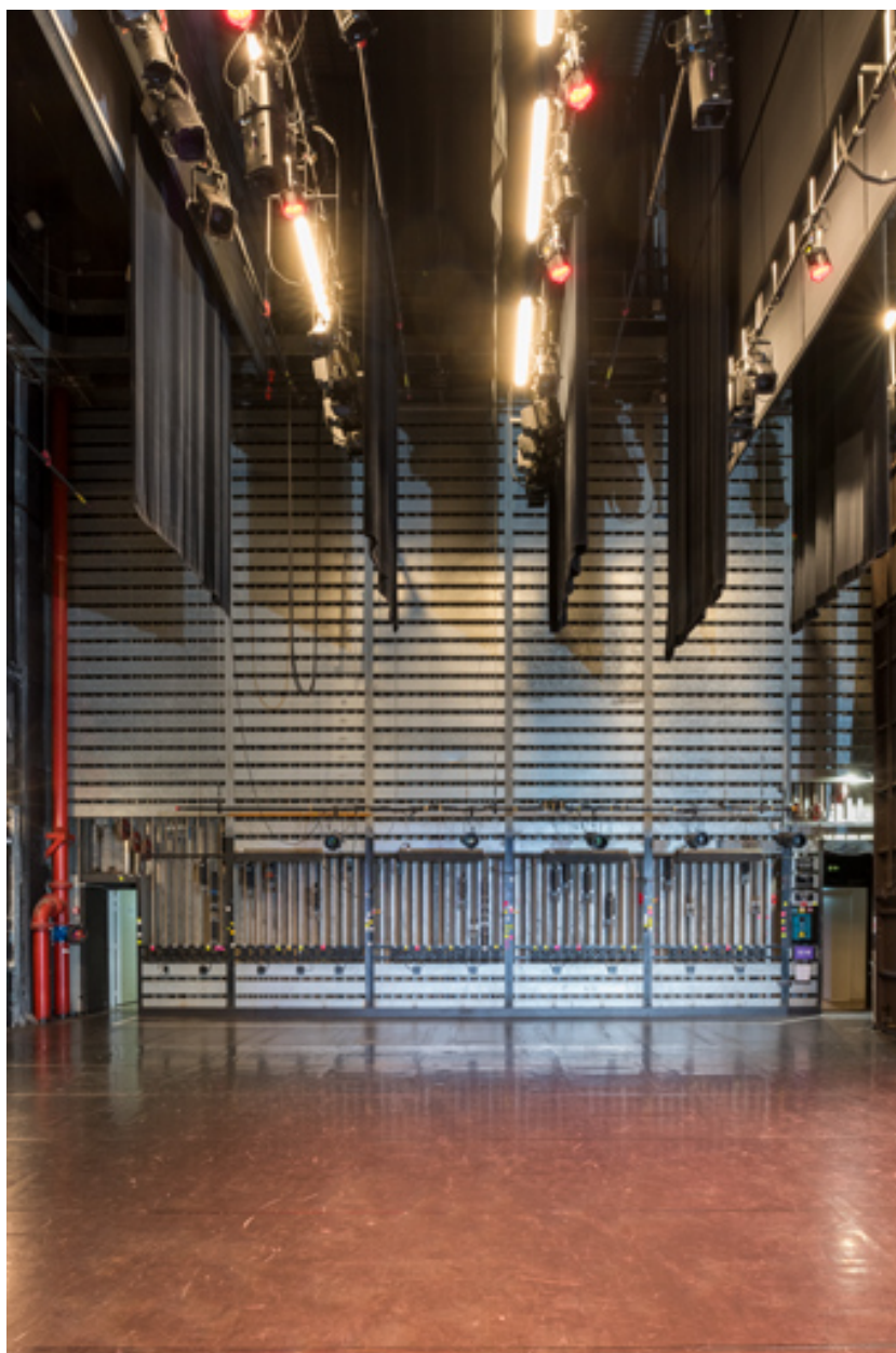
Maison de la culture, grande salle : cheminée de contrepoids dans les coulisses côté cour.
