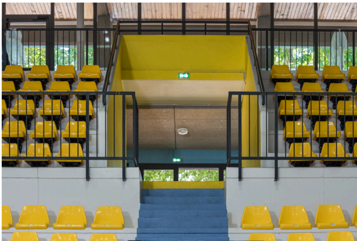
Maison des sports, grand gymnase : circulations dans les gradins côté RN. L'escalier donne accès à une galerie vitrée.
