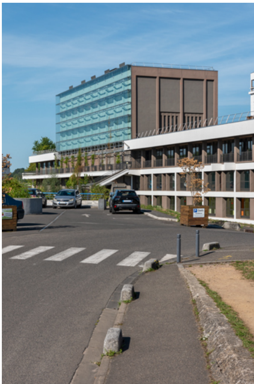
Maison de la culture : cage de scène (façades postérieure et latérale gauche).
