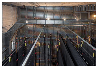
Maison de la culture, grande salle : le gril, vu depuis une passerelle technique. Phot. Pierre-Marie Barbe-Richaud IVR26_20245800938NUC2A
