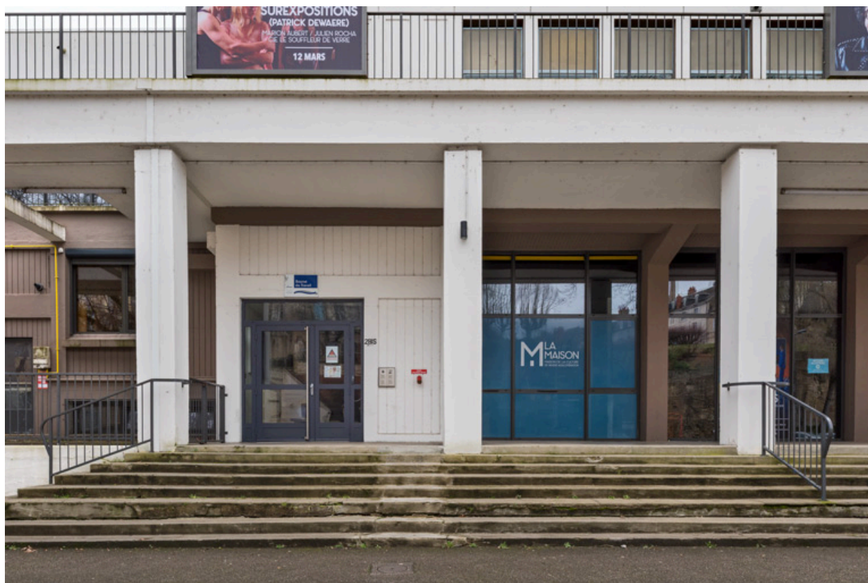
Façade antérieure : accès à la maison de la culture et à la bourse du travail.
