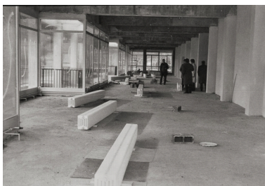
Maison de la culture et des sports. Construction [intérieur]. S.d. [1970-1971].
