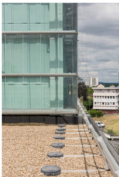
Maison de la culture : détail de la cage de scène et du mur pariéto-dynamique, depuis le toit. Phot. Pierre-Marie Barbe-Richaud IVR26_20245800944NUC4A
