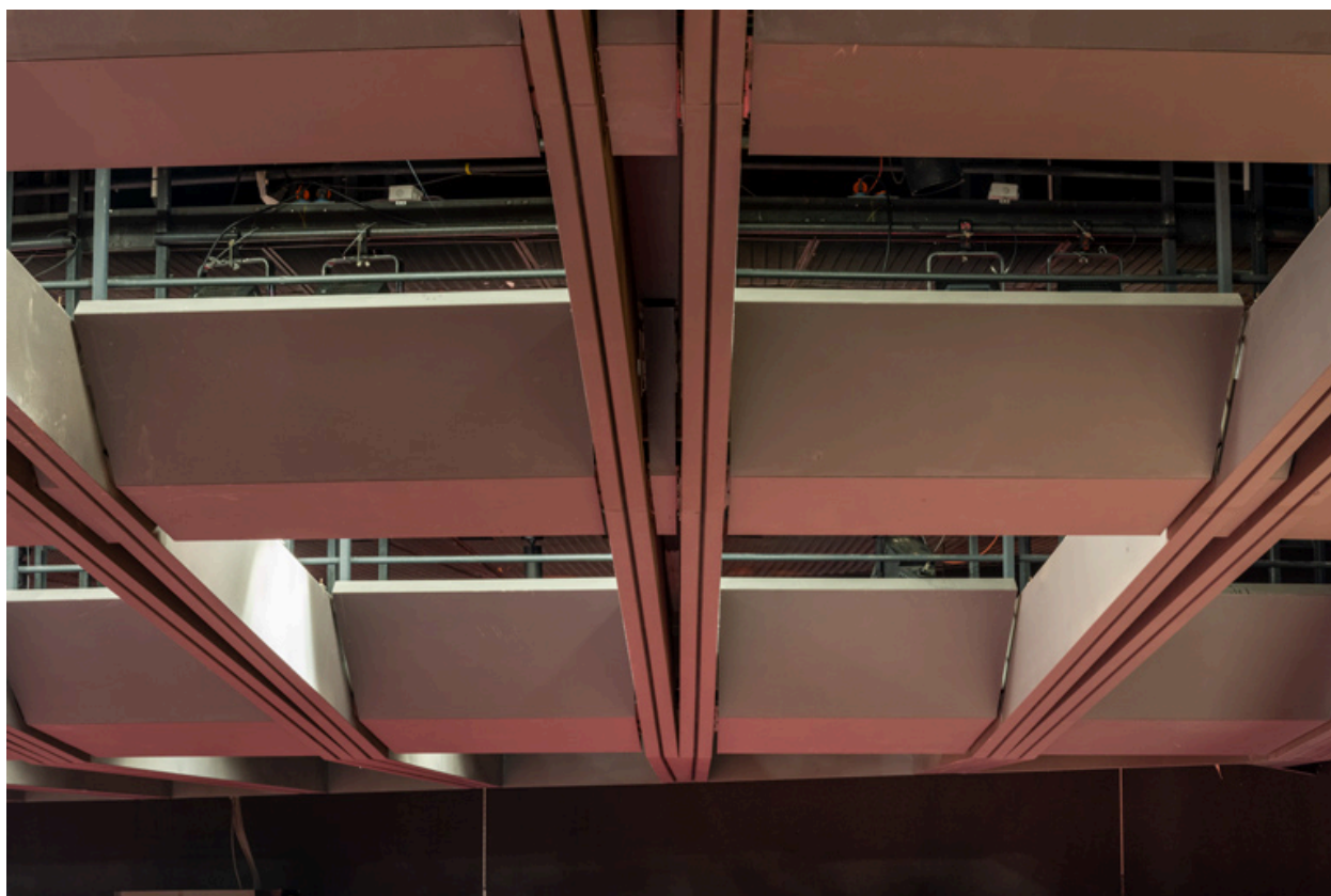
Maison de la culture, grande salle : détail de la charpente.
