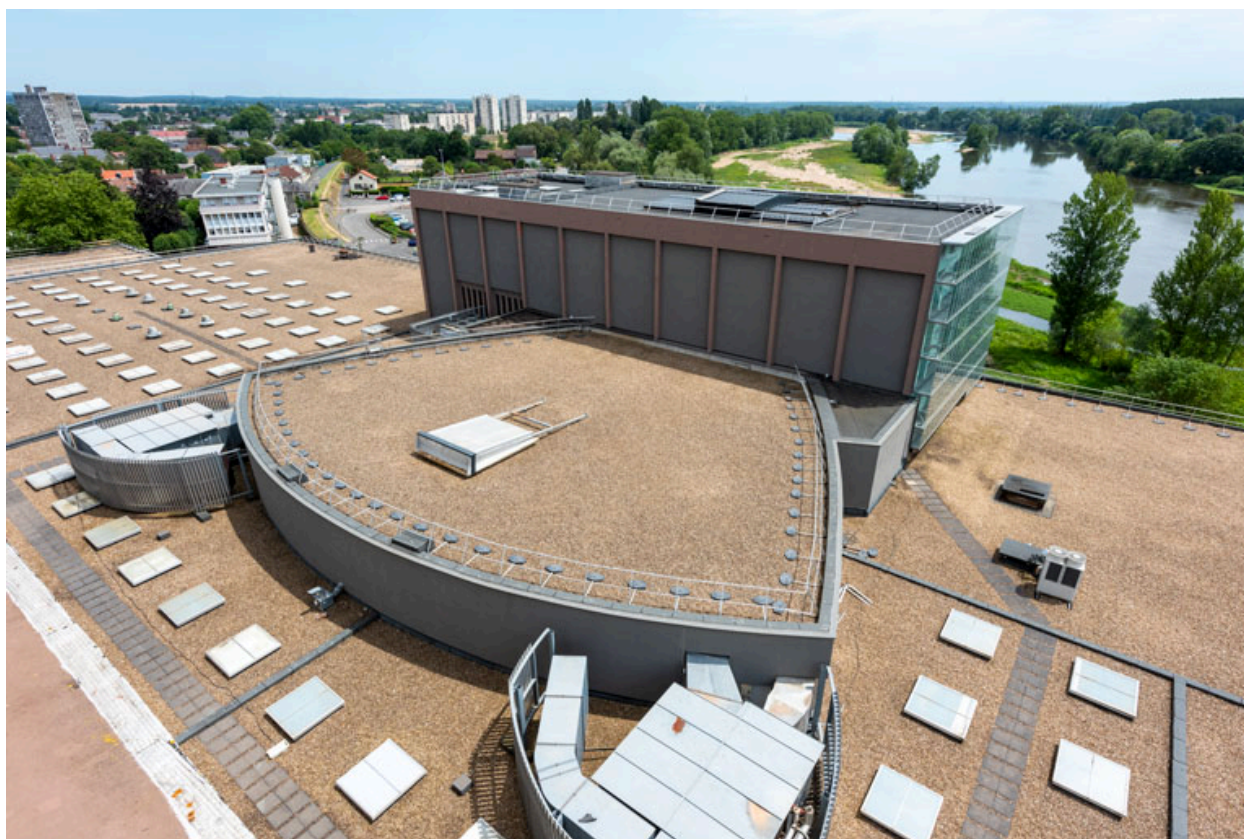
Maison de la culture : vue plongeante sur le haut de la salle et la cage de scène, depuis la bourse du travail.
