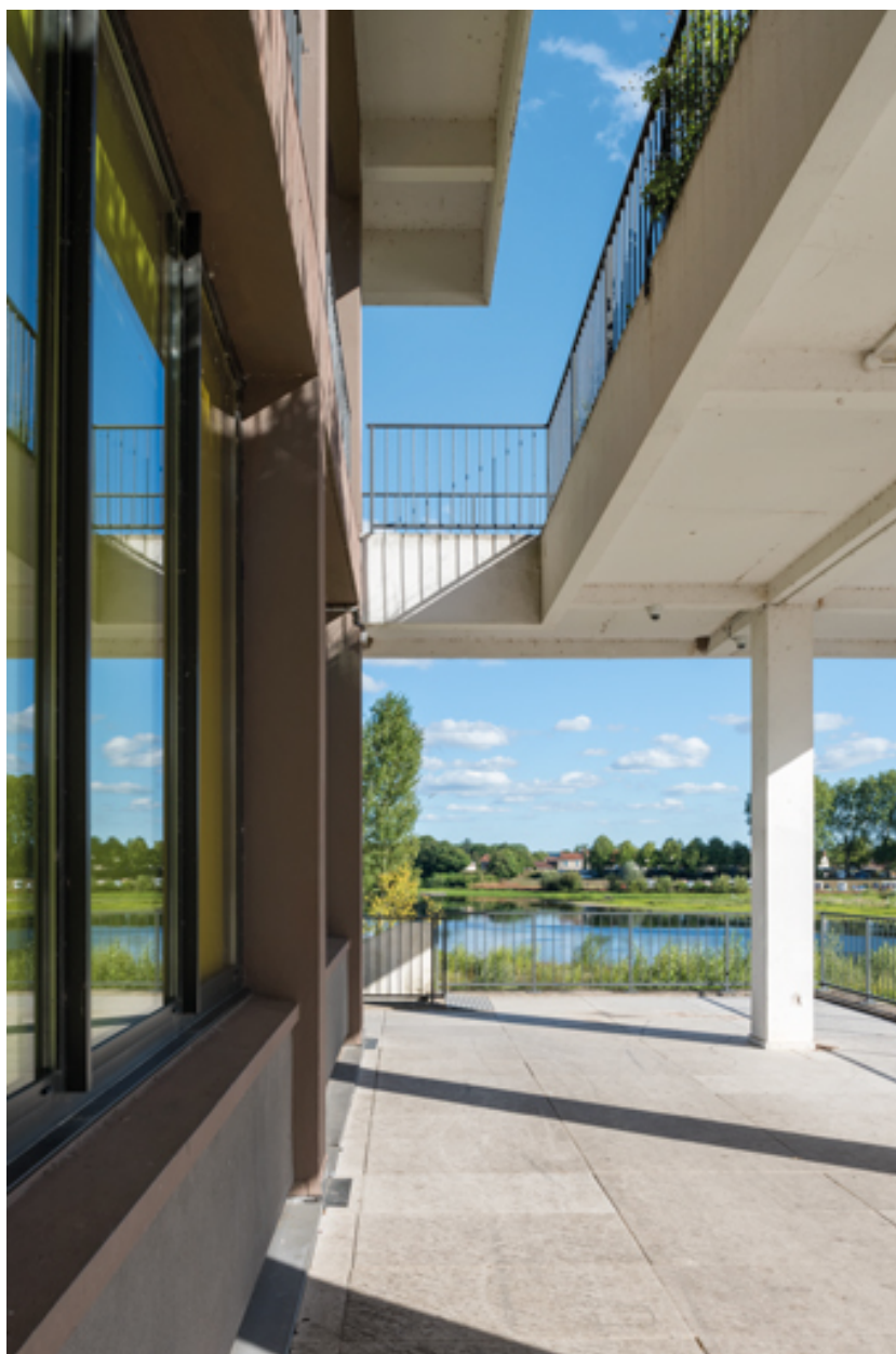
Maison de la culture, façade latérale droite : portique.
