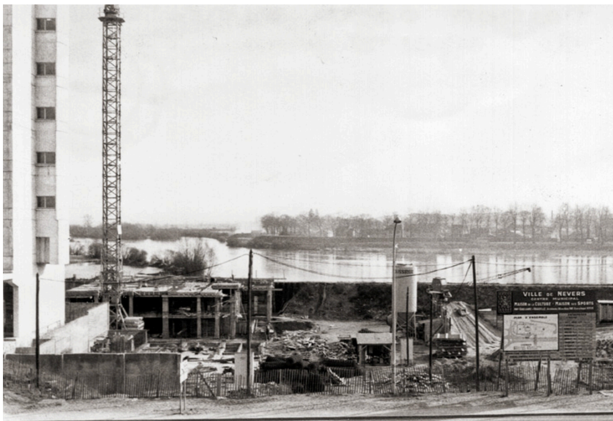
Maison de la culture et des sports. Construction [chantier de la maison de la culture]. Fin janvier 1967.
