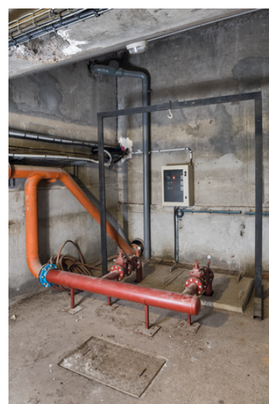
Maison des sports : pompe de relevage (étage de soubassement côté RN). Phot. Pierre-Marie Barbe-Richaud IVR26_20245800887NUC4A
