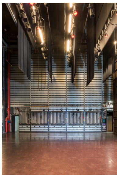
Maison de la culture, grande salle : cheminée de contrepoids dans les coulisses côté cour. Phot. Pierre-Marie Barbe-Richaud IVR26_20245800906NUC4A
