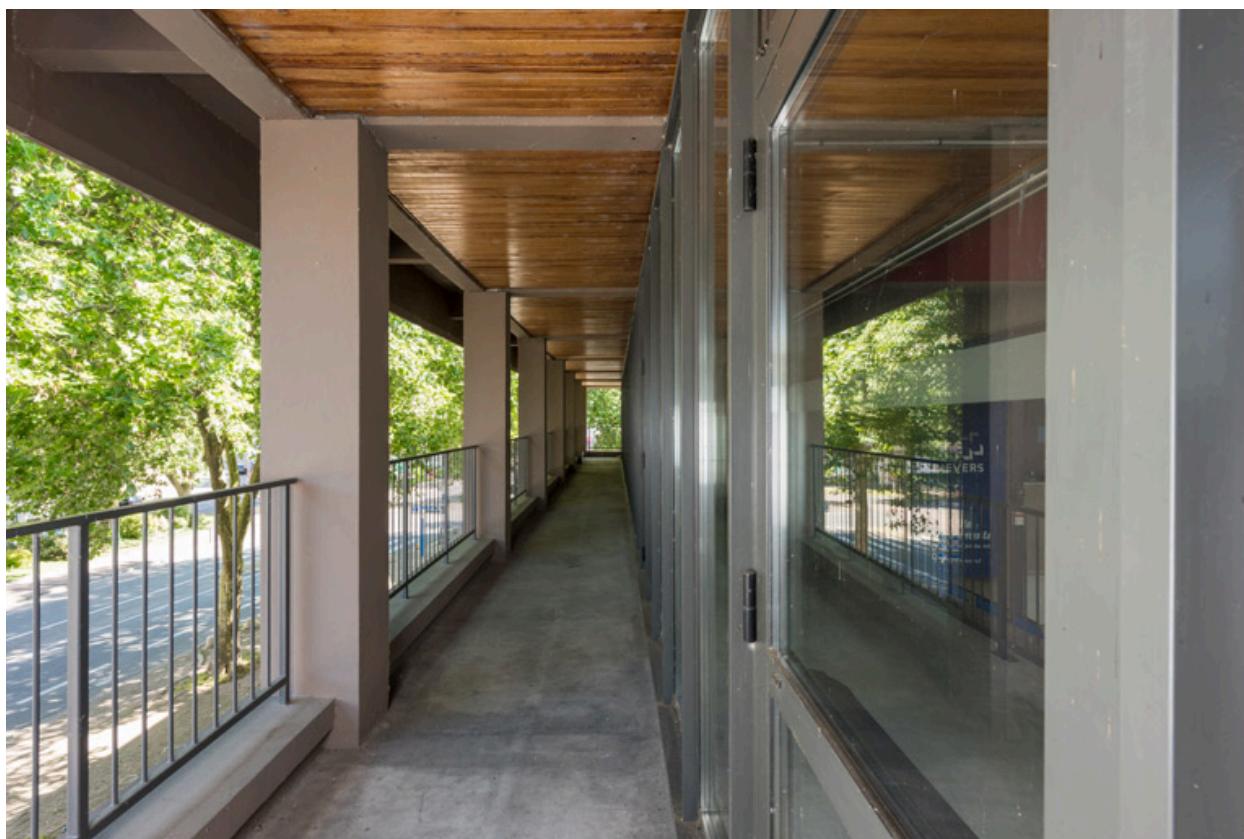
Maison des sports : galerie extérieure au niveau des gradins.
