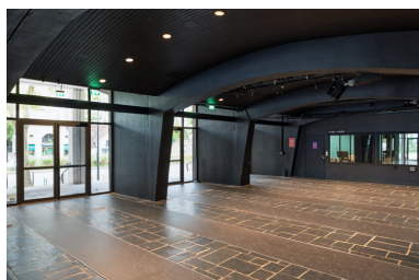
Maison de la culture : ancienne entrée, de trois quarts. Phot. Pierre-Marie Barbe-Richaud IVR26_20245800500NUC4A
