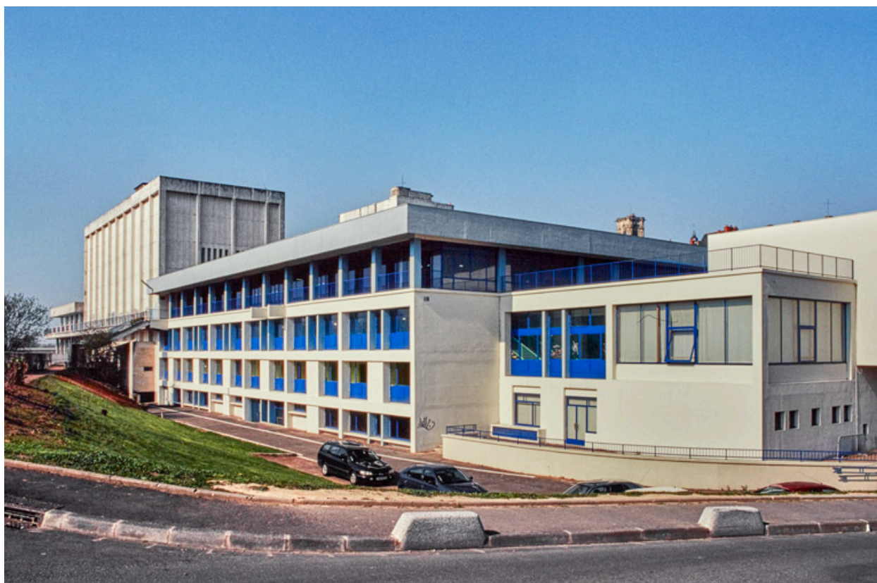
Façade postérieure, de trois quarts droite, en 2000.
