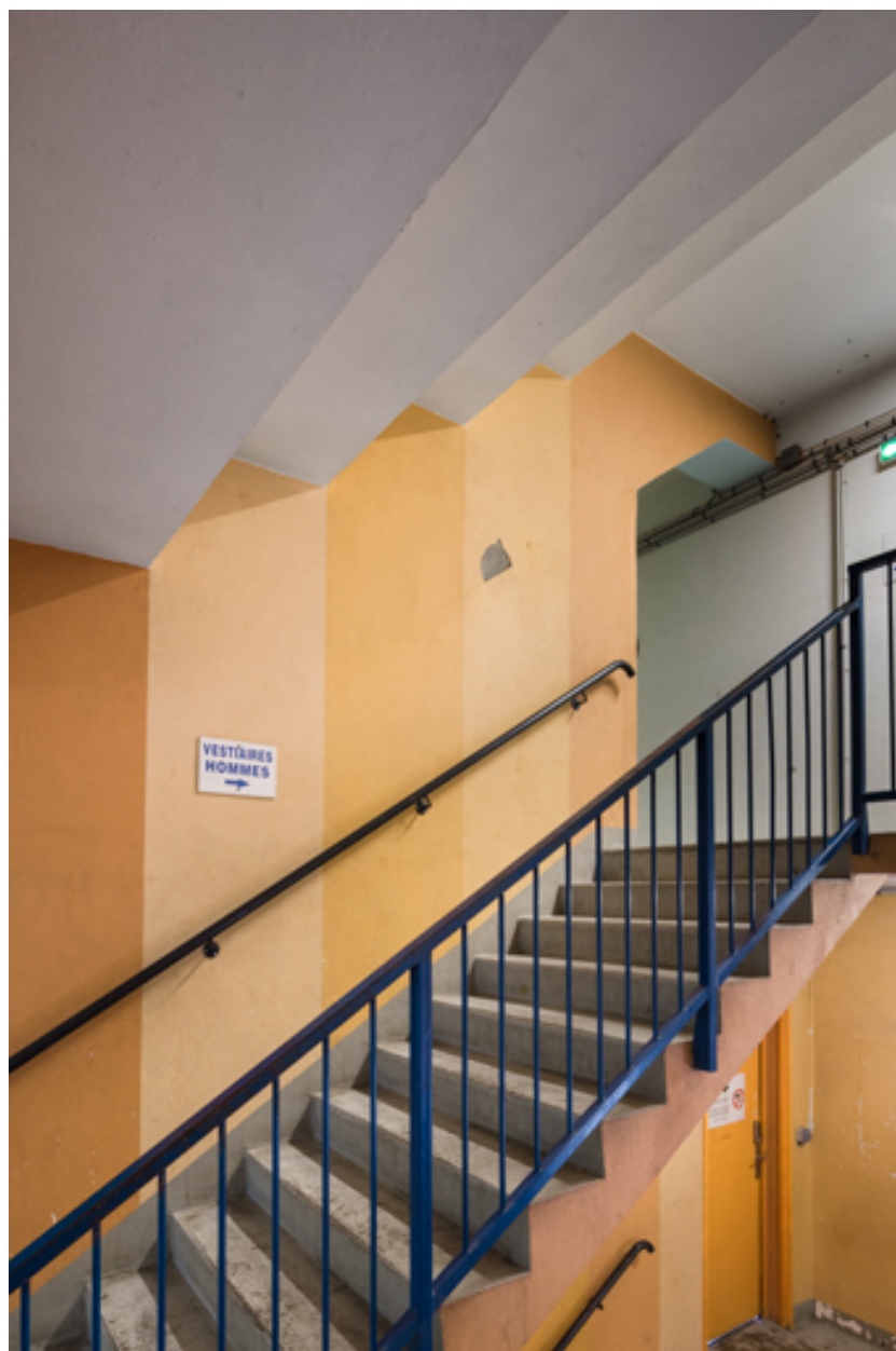
Maison des sports, grand gymnase : escalier sous les gradins côté Loire.
