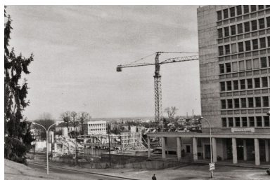
Maison de la culture et des sports. Construction [chantier de la maison des sports]. Fin janvier 1967.
