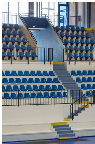
Maison des sports, grand gymnase : circulations dans les gradins côté Loire. L'escalier donne accès à une galerie vitrée. Phot. Pierre-Marie Barbe-Richaud IVR26_20245800862NUC4A
