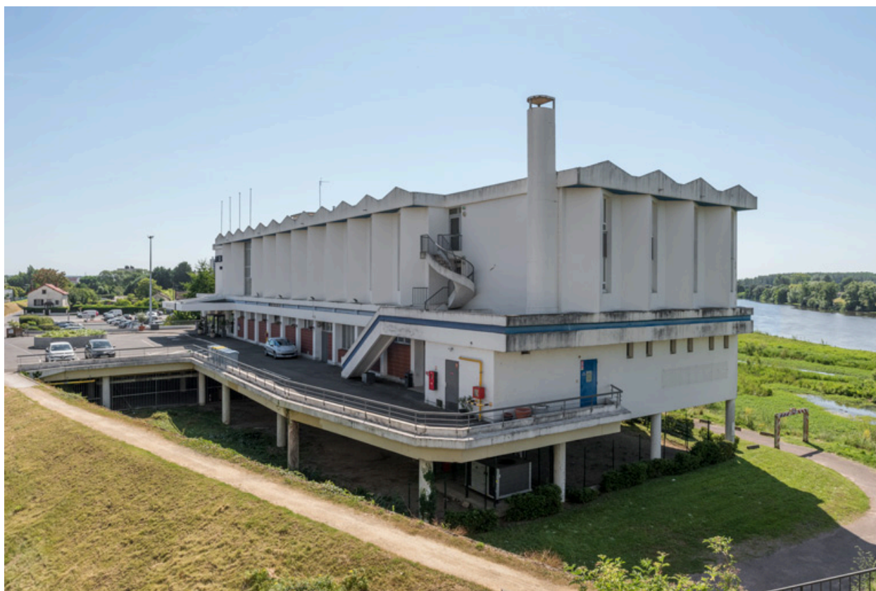
Hôtel bâti entre la maison des sports et la Loire, vu de trois quarts.
