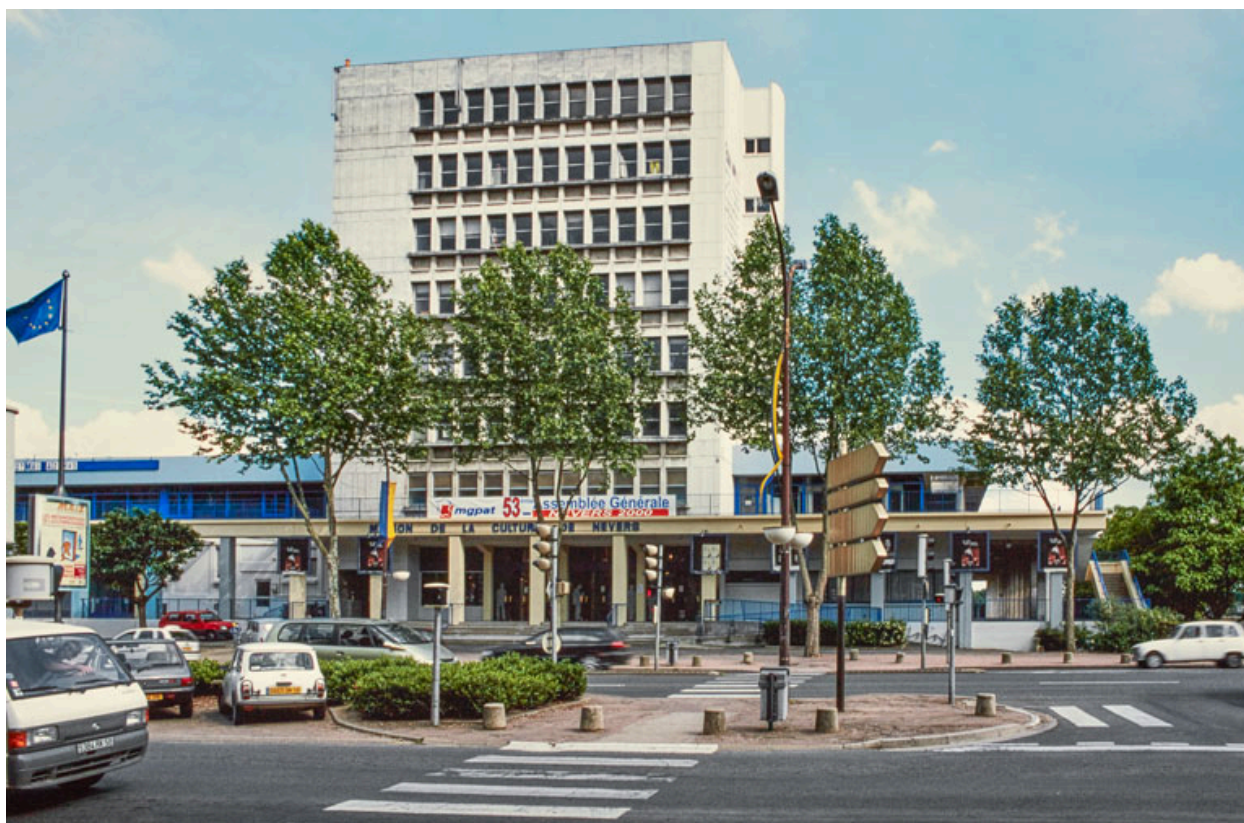
Façade antérieure, en 2000 : bourse du travail et entrée de la maison de la culture.
