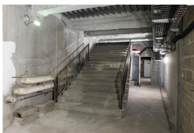
Maison de la culture : escalier menant à la maison des sports, sous le hall. Phot. Pierre-Marie Barbe-Richaud IVR26_20245800954NUC4A
