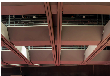
Maison de la culture, grande salle : détail de la charpente. Phot. Pierre-Marie Barbe-Richaud IVR26_20245800916NUC4A
