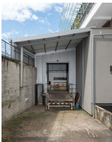
Maison de la culture : quai de chargement (façade postérieure). Phot. Pierre-Marie Barbe-Richaud IVR26_20245800929NUC4A
