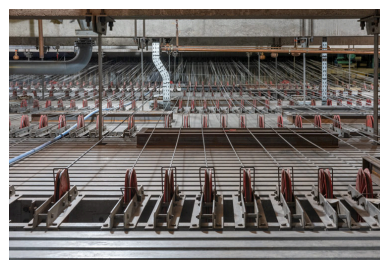
Maison de la culture, grande salle : le gril. Phot. Pierre-Marie Barbe-Richaud IVR26_20245800946NUC4A
