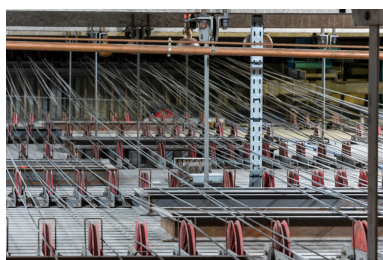
Maison de la culture, grande salle : le gril, vue rapprochée de trois quarts. Phot. Pierre-Marie Barbe-Richaud IVR26_20245800947NUC4A
