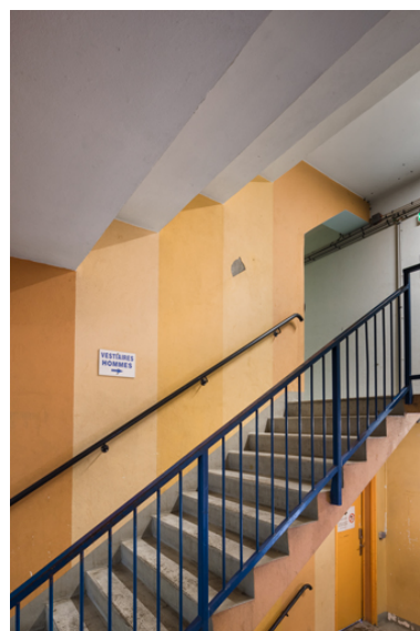
Maison des sports, grand gymnase : escalier sous les gradins côté Loire. Phot. Pierre-Marie Barbe-Richaud IVR26_20245800877NUC4A
