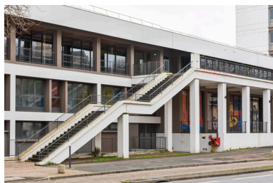
Maison des sports : accès extérieur aux gradins. Phot. Pierre-Marie Barbe-Richaud IVR26_20245800013NUC4A
