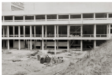
Maison de la culture et des sports. Construction [maison de la culture : façade latérale droite, sans les huisseries]. S.d. [1967-1968].
