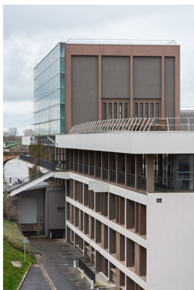
Maison de la culture : cage de scène (façades postérieure et latérale gauche), vue plongeante en enfilade. Phot. Pierre-Marie Barbe-Richaud IVR26_20245800006NUC4A
