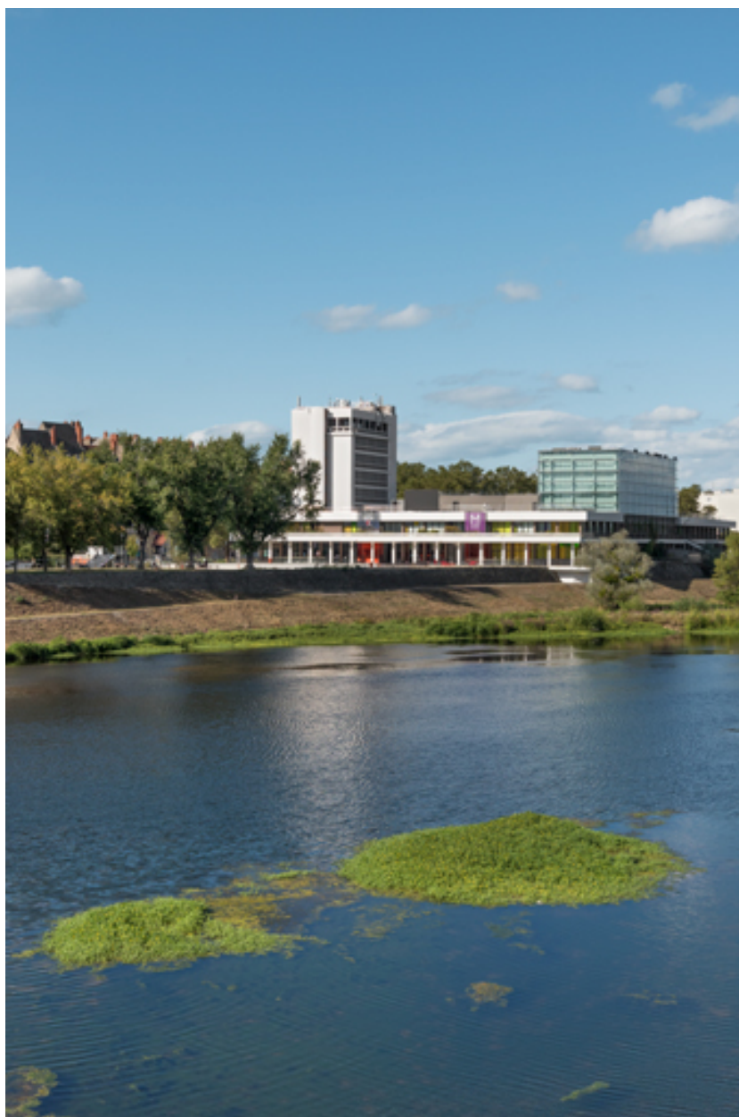
Vue d'ensemble, depuis le sud (cadrage vertical).
