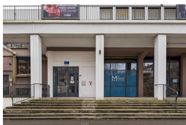
Façade antérieure : accès à la maison de la culture et à la bourse du travail. Phot. Pierre-Marie Barbe-Richaud IVR26_20245800011NUC4A
