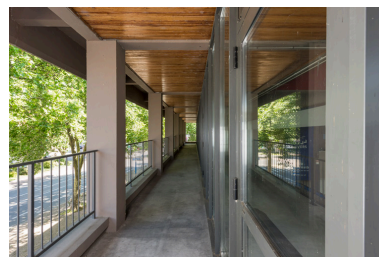
Maison des sports : galerie extérieure au niveau des gradins. Phot. Pierre-Marie Barbe-Richaud IVR26_20245800082NUC4A
