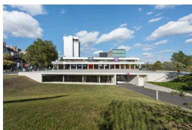
Façade latérale droite. Phot. Pierre-Marie Barbe-Richaud IVR26_20235800238NUC4A
