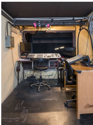
Maison de la culture, petite salle : régie. Phot. Pierre-Marie Barbe-Richaud IVR26_20245800901NUC4A
