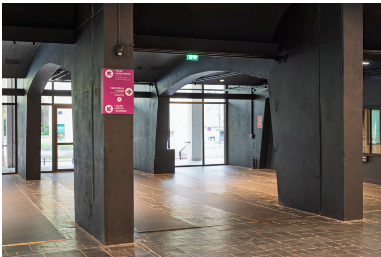
Maison de la culture : arcs de l'ancienne entrée, vus du hall.
