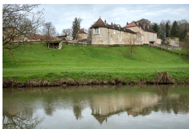
Partie sud du château. Phot. Sonia Dourlot IVR43_20167000654NUC4A
