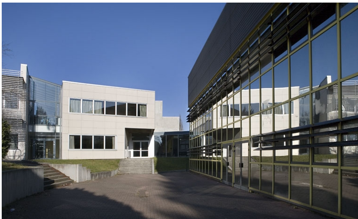
Vue de la façade antérieure bâtiment B.
