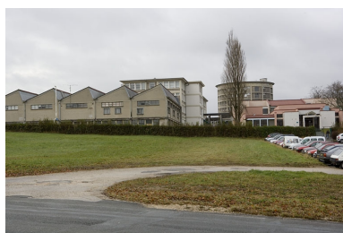
Vue d'ensemble. Façade postérieure du bâtiment B. Phot. Yves Sancey IVR43_20072501001NUCA
