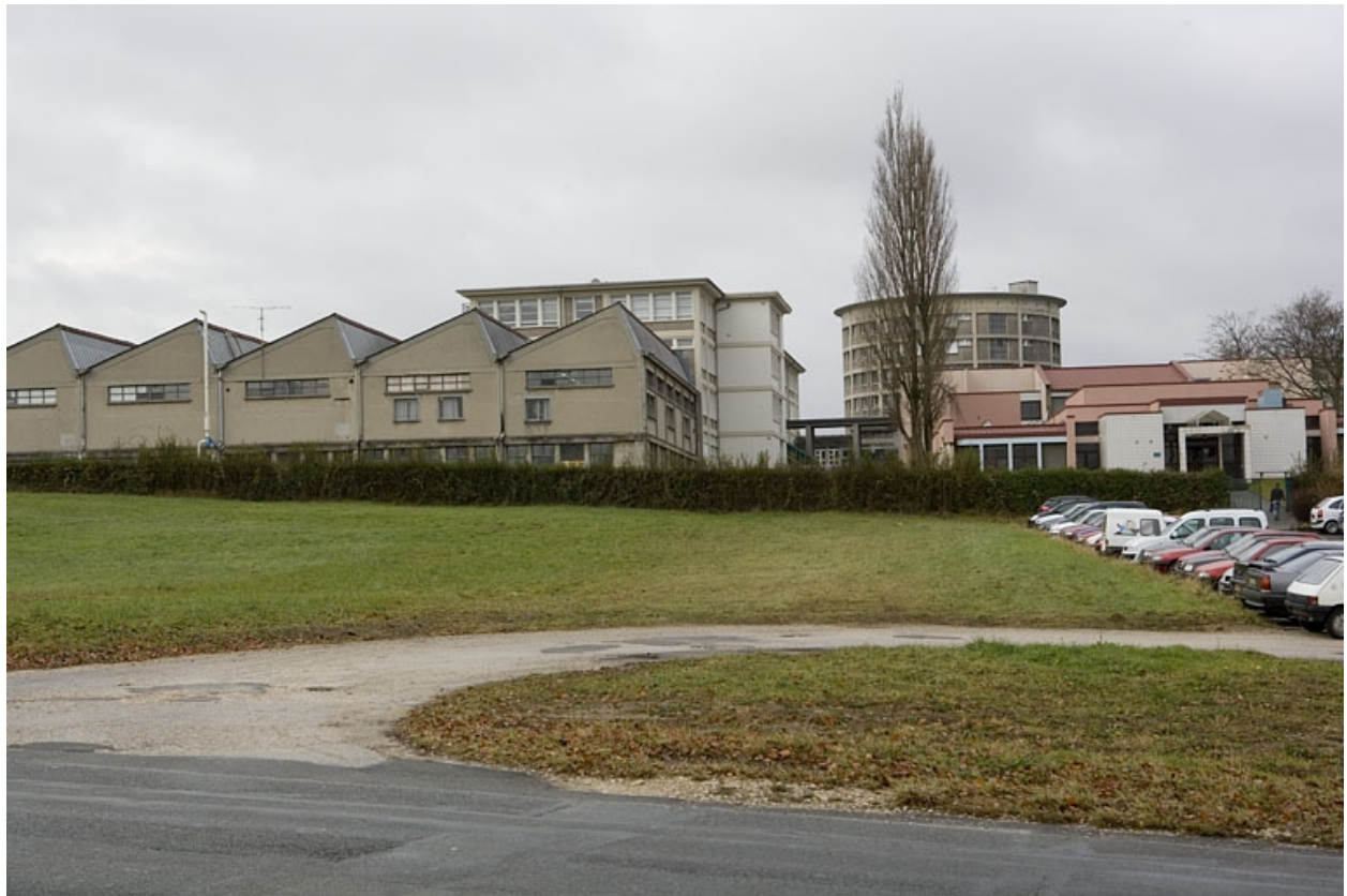
Vue d'ensemble. Façade postérieure du bâtiment B.
