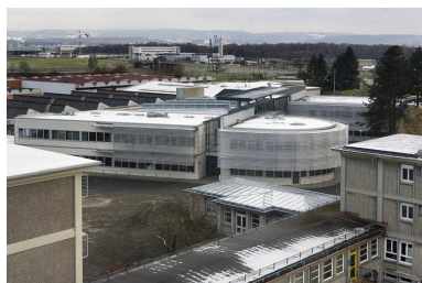
Vue d'ensemble depuis tour internat. Phot. Yves Sancey IVR43_20072500999NUCA
