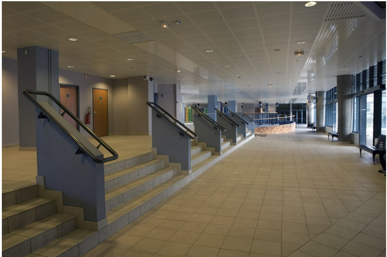
Bâtiment A. Vue du hall d'accueil.
