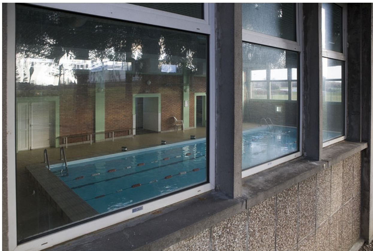
Bâtiment G. Vue piscine.
