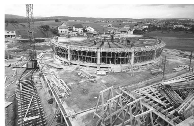
Vue du chantier de construction. Phot. Mary Ruffinoni IVR43_20152500275NUC1A
