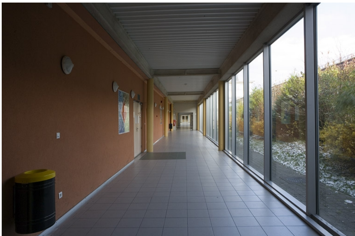
Bâtiment B. Vue couloir.
