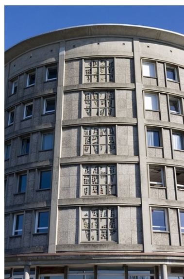
Bâtiment D. Tour internat. Détail vitrail. Phot. Yves Sancey IVR43_20072501015NUCA
