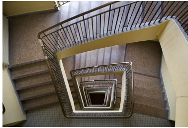
Bâtiment D : internat. Vue plongeante de l'escalier. Phot. Yves Sancey IVR43_20072500997NUCA
