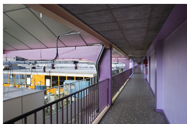
Bâtiment B. Atelier section technologique. Vue passerelle. Phot. Yves Sancey IVR43_20072500976NUCA
