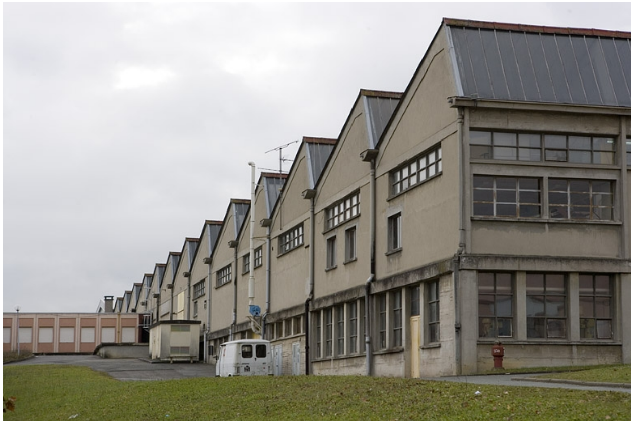
Vue de trois quarts droit bâtiment B.
