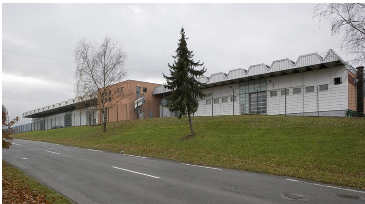
Vue façade postérieure bâtiment F.
