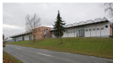
Vue façade postérieure bâtiment F. Phot. Yves Sancey IVR43_20072501000NUCA
