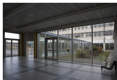
Couloir entre bâtiment A et B. Phot. Yves Sancey IVR43_20072500990NUCA
