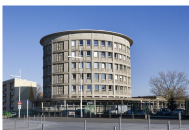
Bâtiment D. Tour internat. Phot. Yves Sancey IVR43_20072501014NUCA
