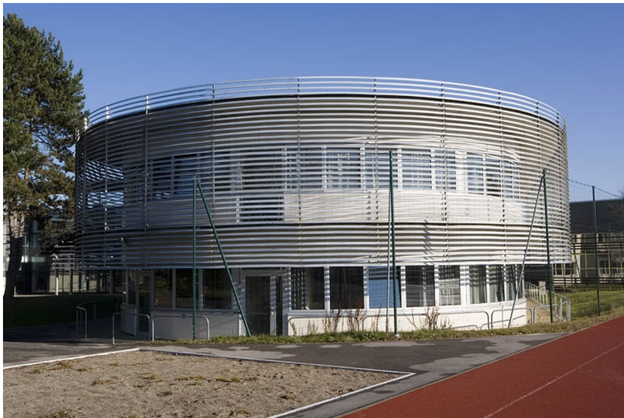
Vue de l'aile droite bâtiment L. Détail.
