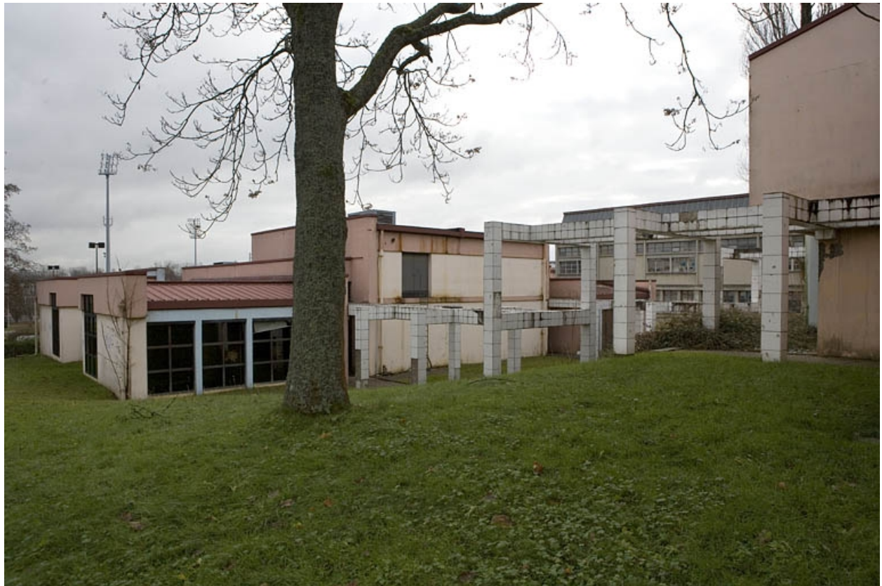
Vue de trois quarts gauche bâtiment J.
