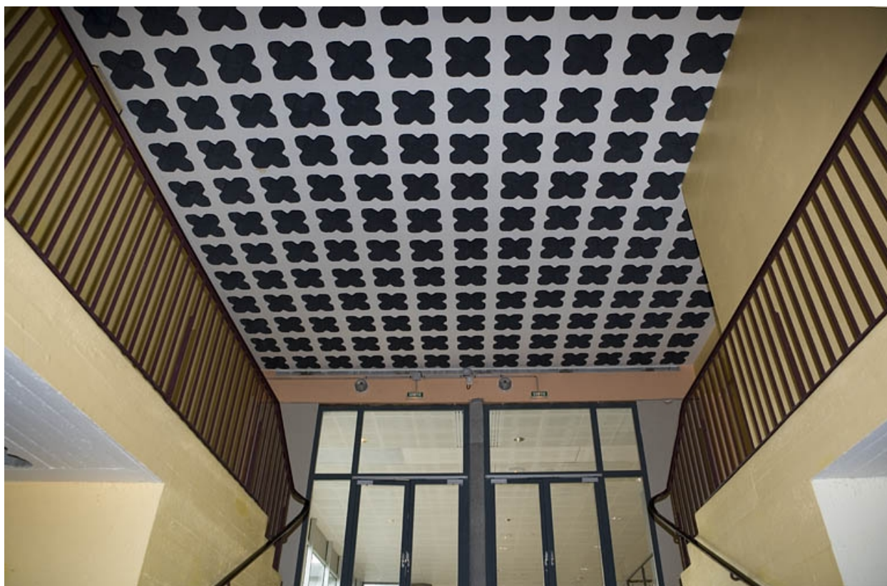
Bâtiment B. Détail plafond.
