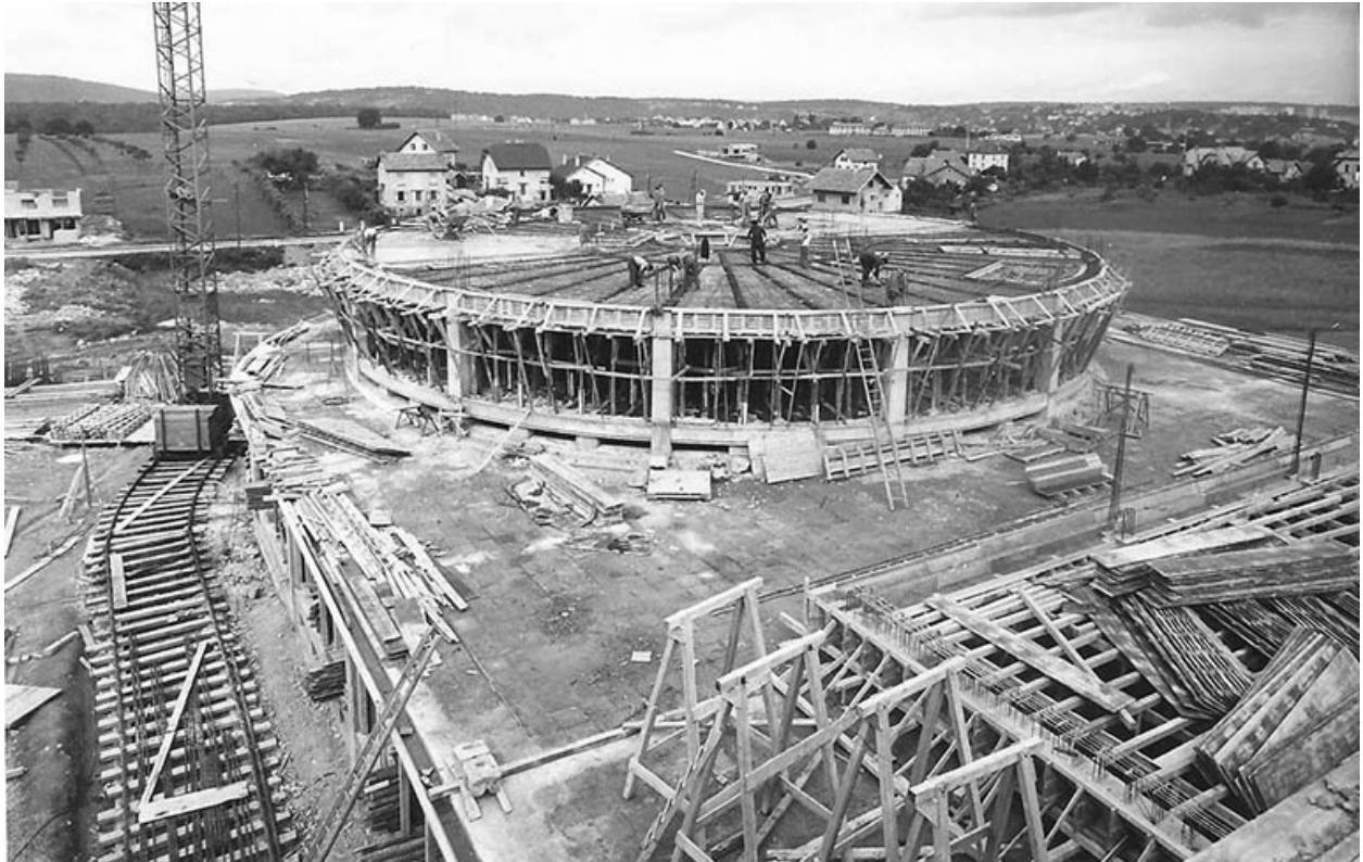
Vue du chantier de construction.
