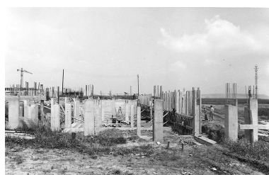
Vue du chantier de construction. Phot. Mary Ruffinoni IVR43_20152500277NUC1A
