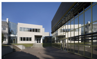
Vue de la façade antérieure bâtiment B. Phot. Yves Sancey IVR43_20072501011NUCA
