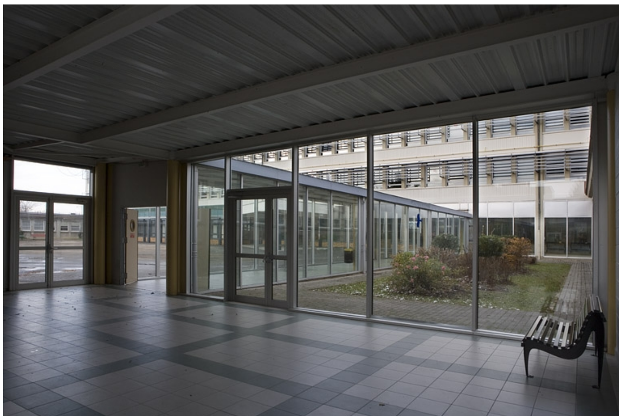
Couloir entre bâtiment A et B.
