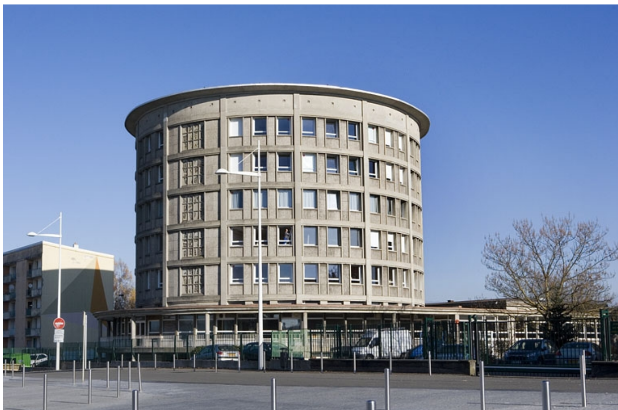
Bâtiment D. Tour internat.
