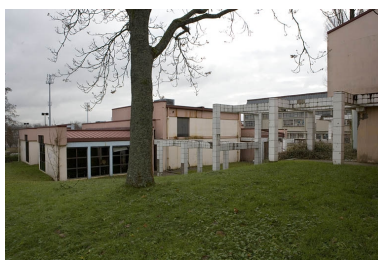
Vue de trois quarts gauche bâtiment J. Phot. Yves Sancey IVR43_20072501003NUCA
