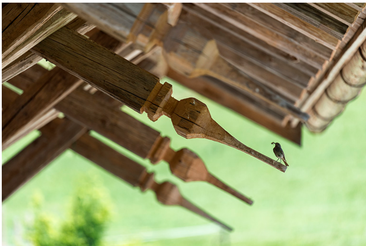
Extrémité sculptée des arbalétriers (façade antérieure).
