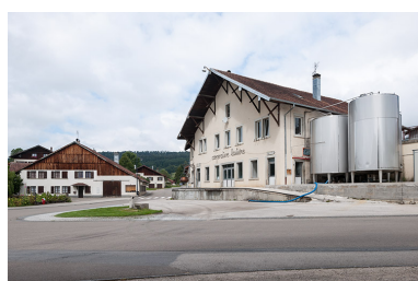
Vue rapprochée depuis l'est. Phot. Jérôme Mongreville IVR43_20142501186NUC4A
