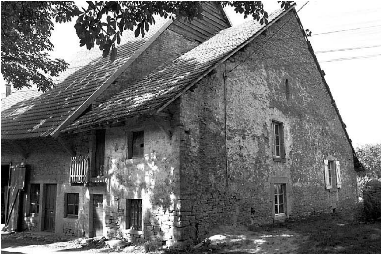
Façade antérieure et face latérale droite.
