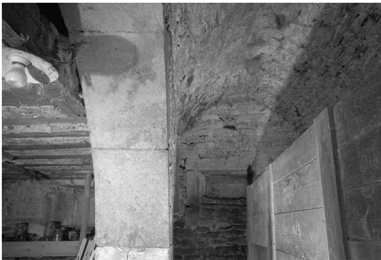
Intérieur : voûte de la cave.
