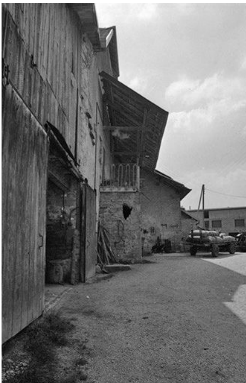
maison de vigneron (18e maison) : façades postérieure et latérale gauche.
