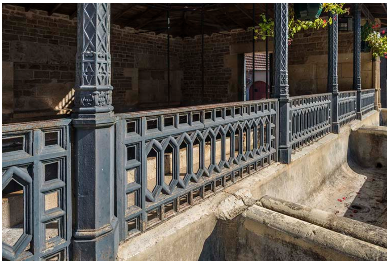
Le garde-corps en fonte.
