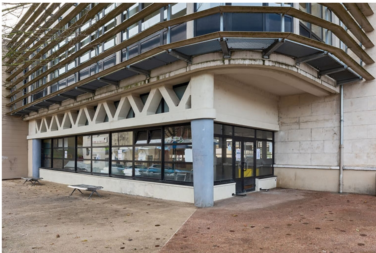
Façade latérale gauche : baies du marché.
