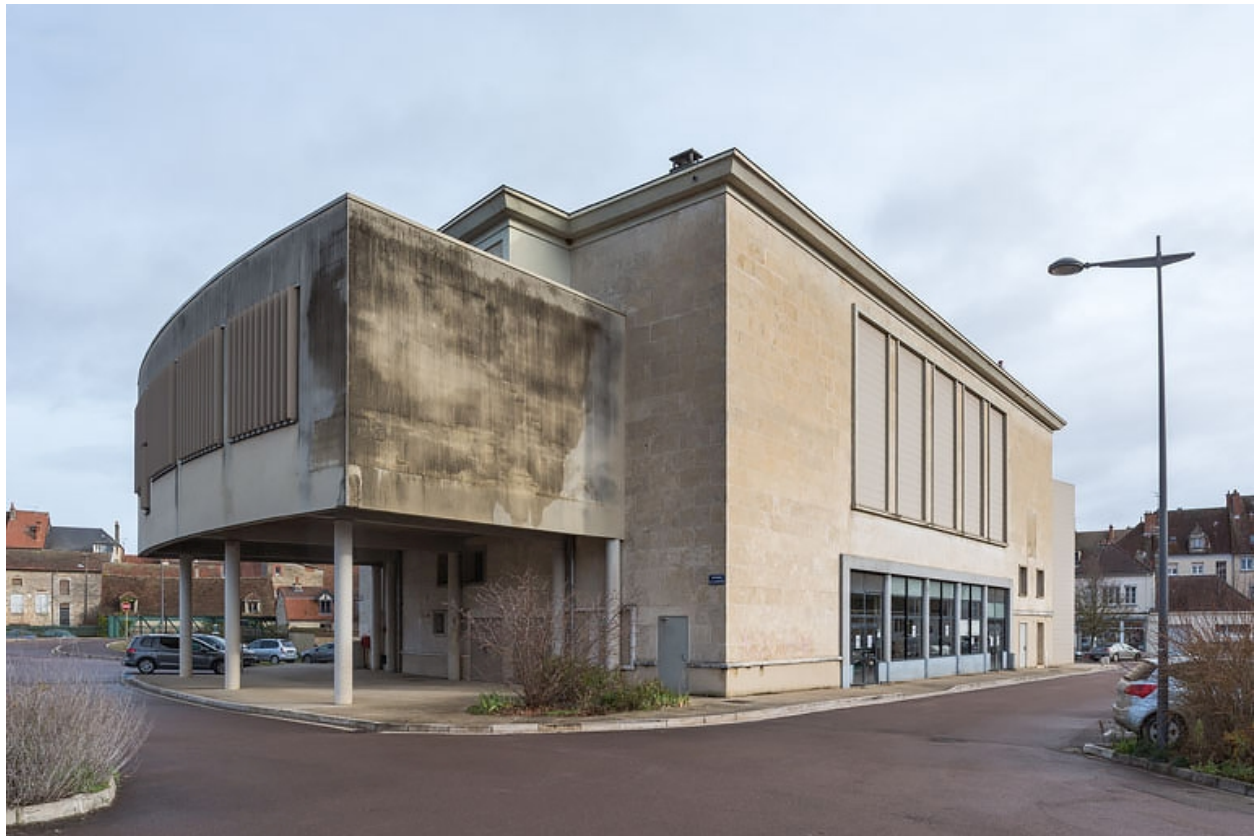
Façades postérieure et latérale droite.
