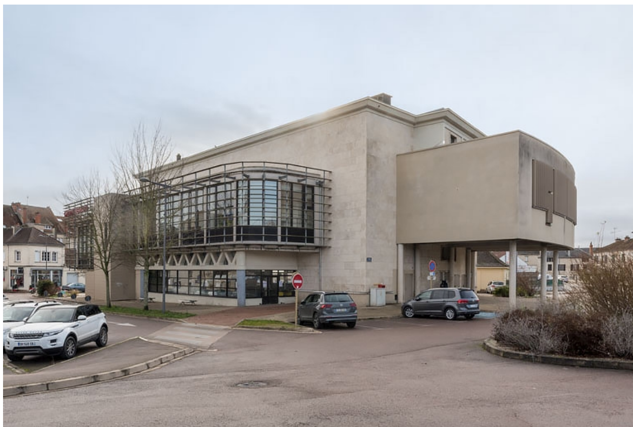
Façades postérieure et latérale gauche.
