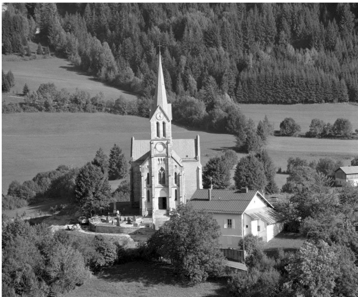
Extérieur : vue générale de la façade ouest.
