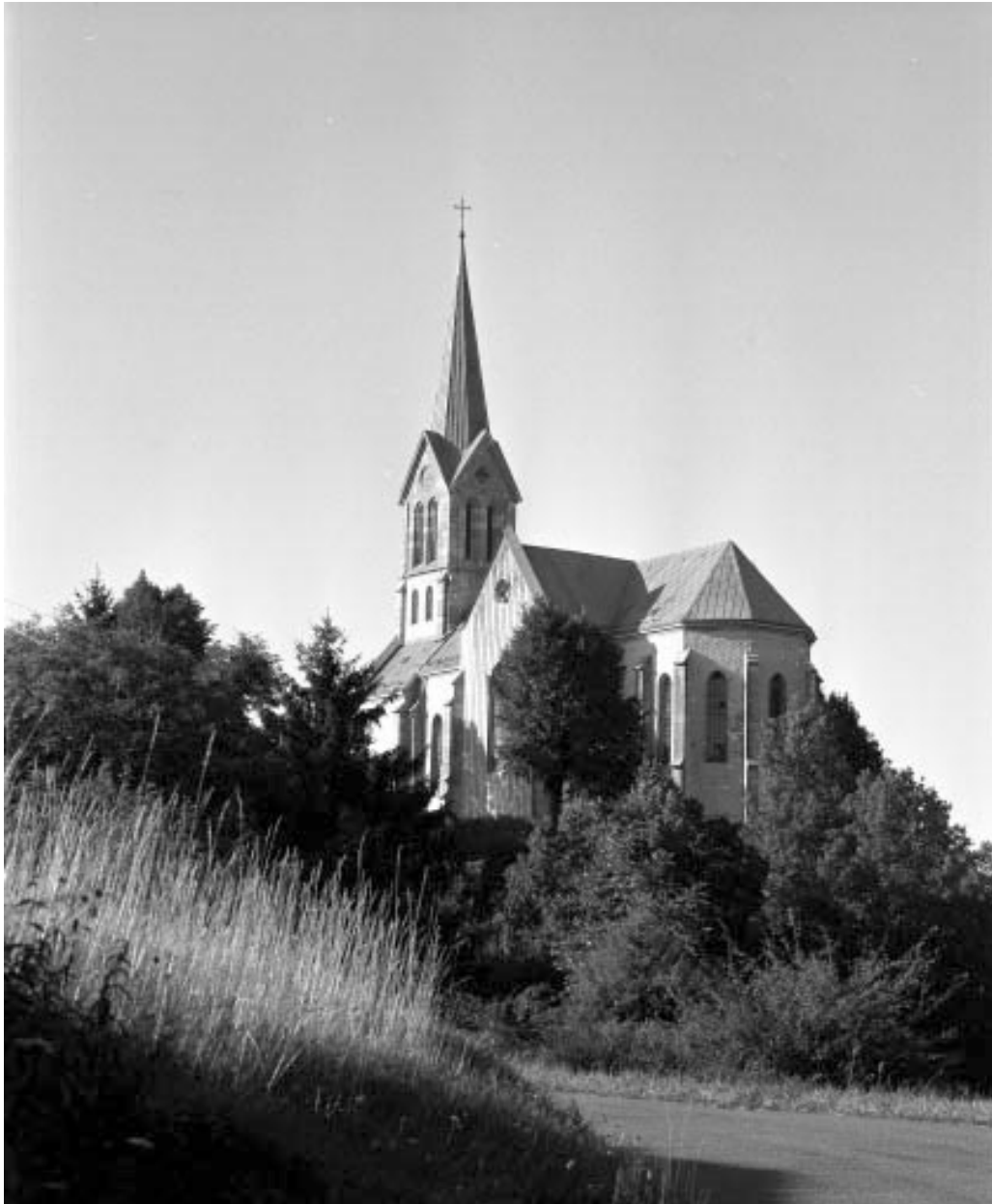
Extérieur : abside et face sud.
