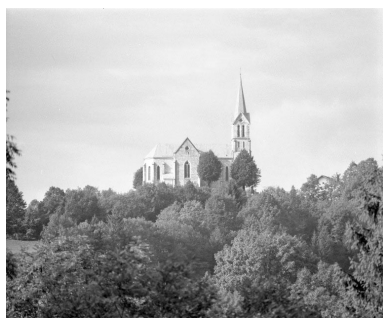
Extérieur : vue générale de la face nord. Phot. Yves Sancey IVR43_19943900970X
