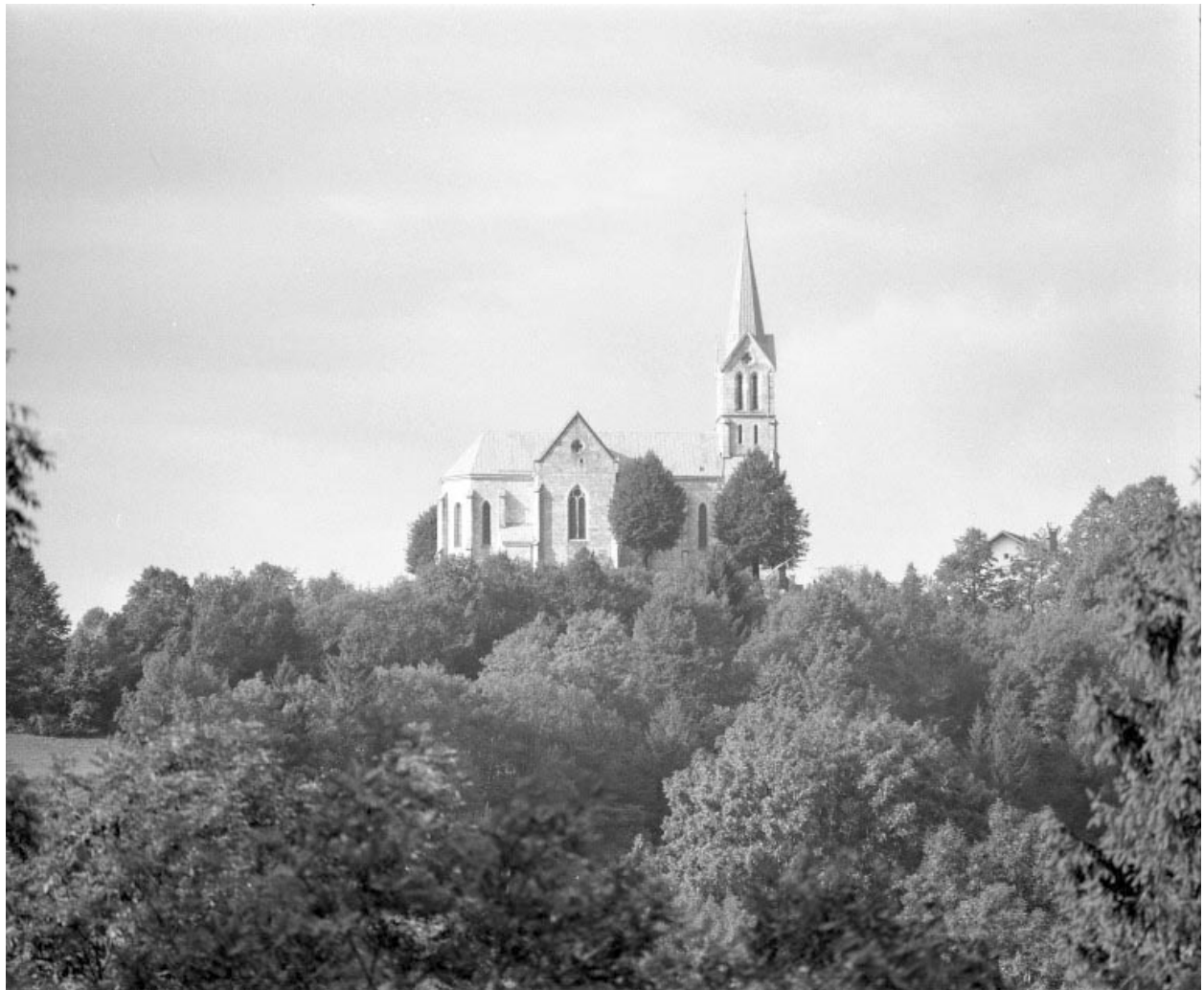
Extérieur : vue générale de la face nord.
