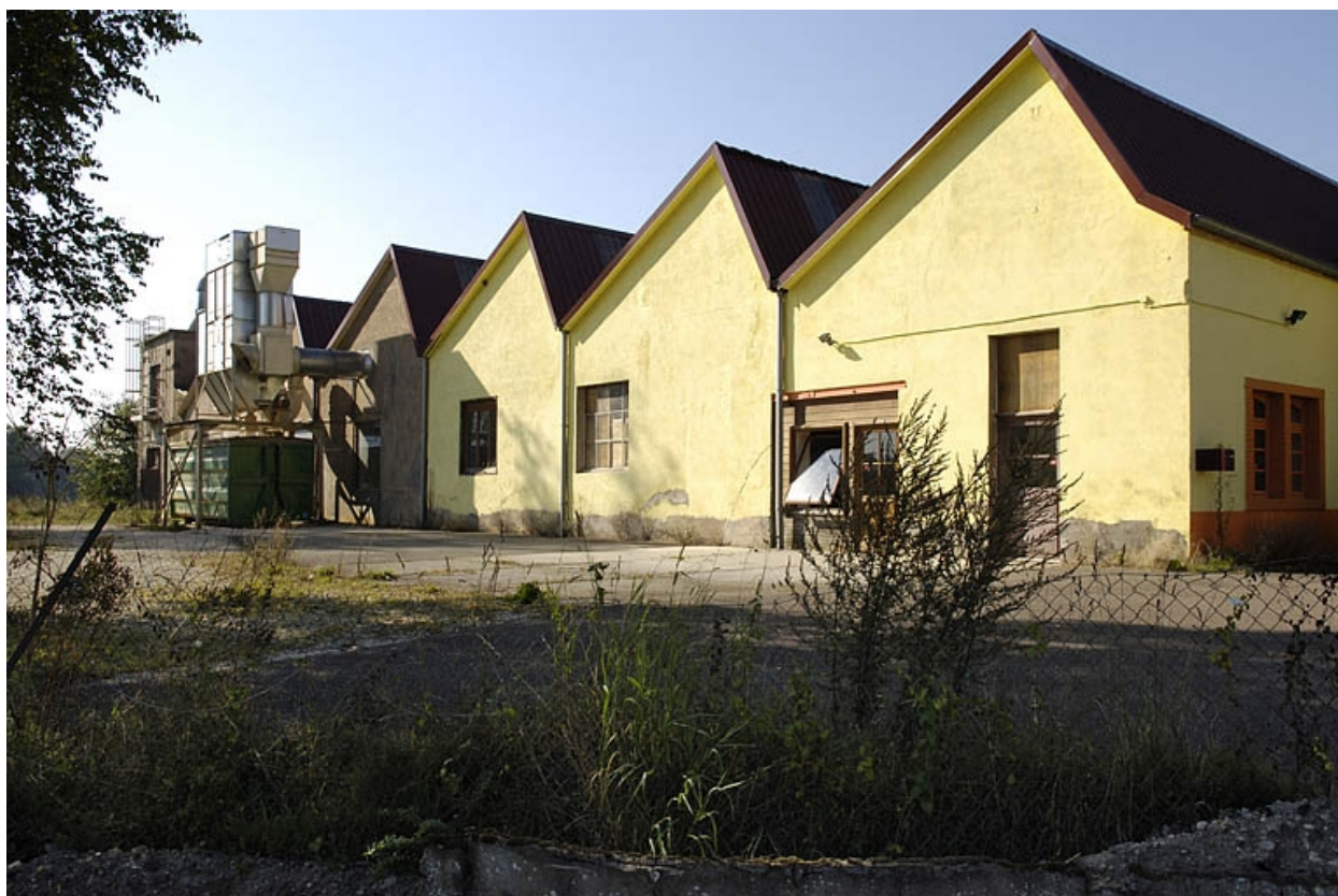
Pignons des sheds depuis l'est.
