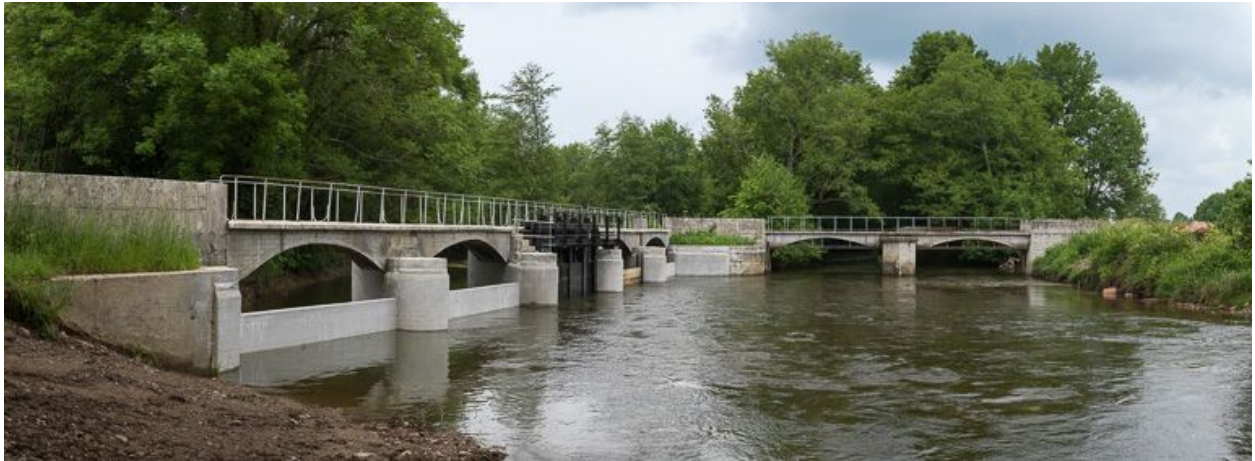
Barrage de prise d'eau sur l'Yonne.
