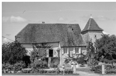
Maison : façade antérieure. Phot. Bernard Pontefract IVR43_19753900992Z
