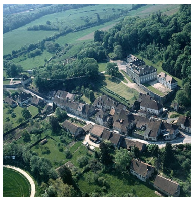
Vue aérienne du château et du Bourg-Dessus. Phot. Yves Sancey IVR43_19903901052XA
