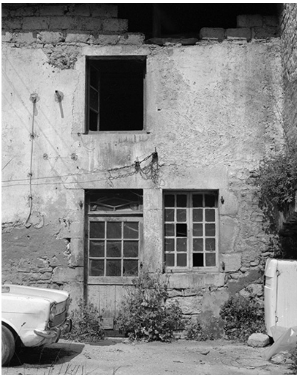
Maison : façade antérieure.
