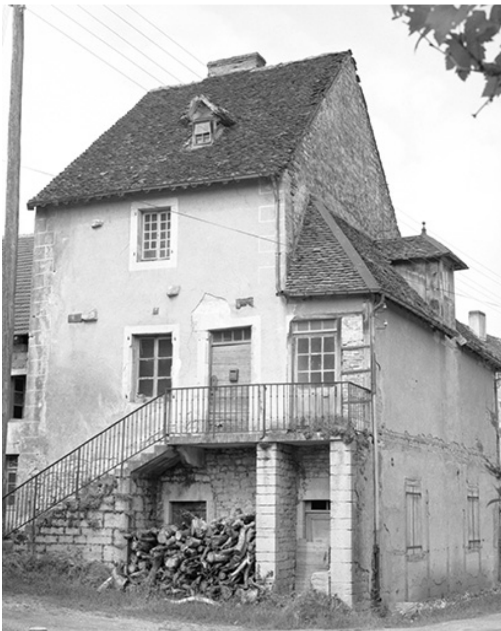
Maison : façades antérieure et latérale droite.
