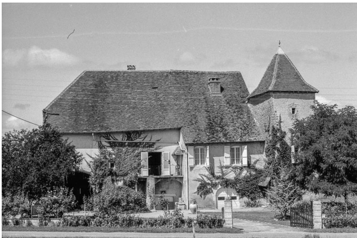
Maison : façade antérieure.
