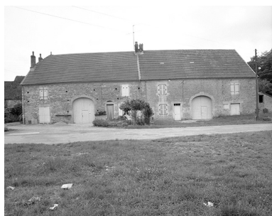
Fermes doubles : vue d'ensemble. Phot. Yves Sancey IVR43_19753901039X
