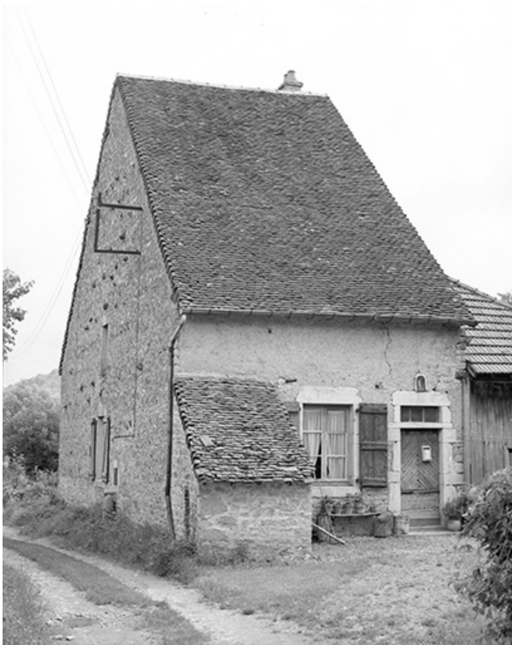
Maison : façades antérieure et latérale gauche.
