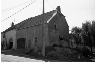
VUe d'ensemble. Phot. Bernard Lardière IVR43_19817000518Z
