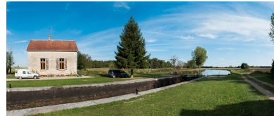
La maison éclusière dans son site. Phot. Pierre-Marie Barbe-Richaud IVR26_20128900577NUC4AQ
