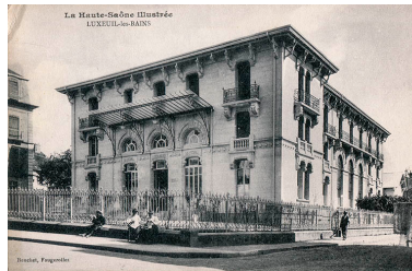
Vue ancienne. Autr. auteur inconnu IVR43_20227000320NUC4A
