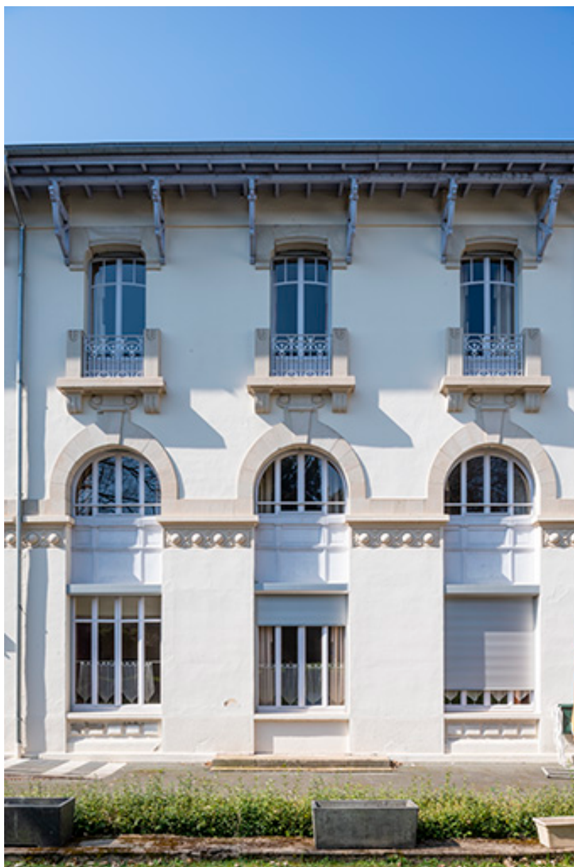
Façade est, vue de face, détail.
