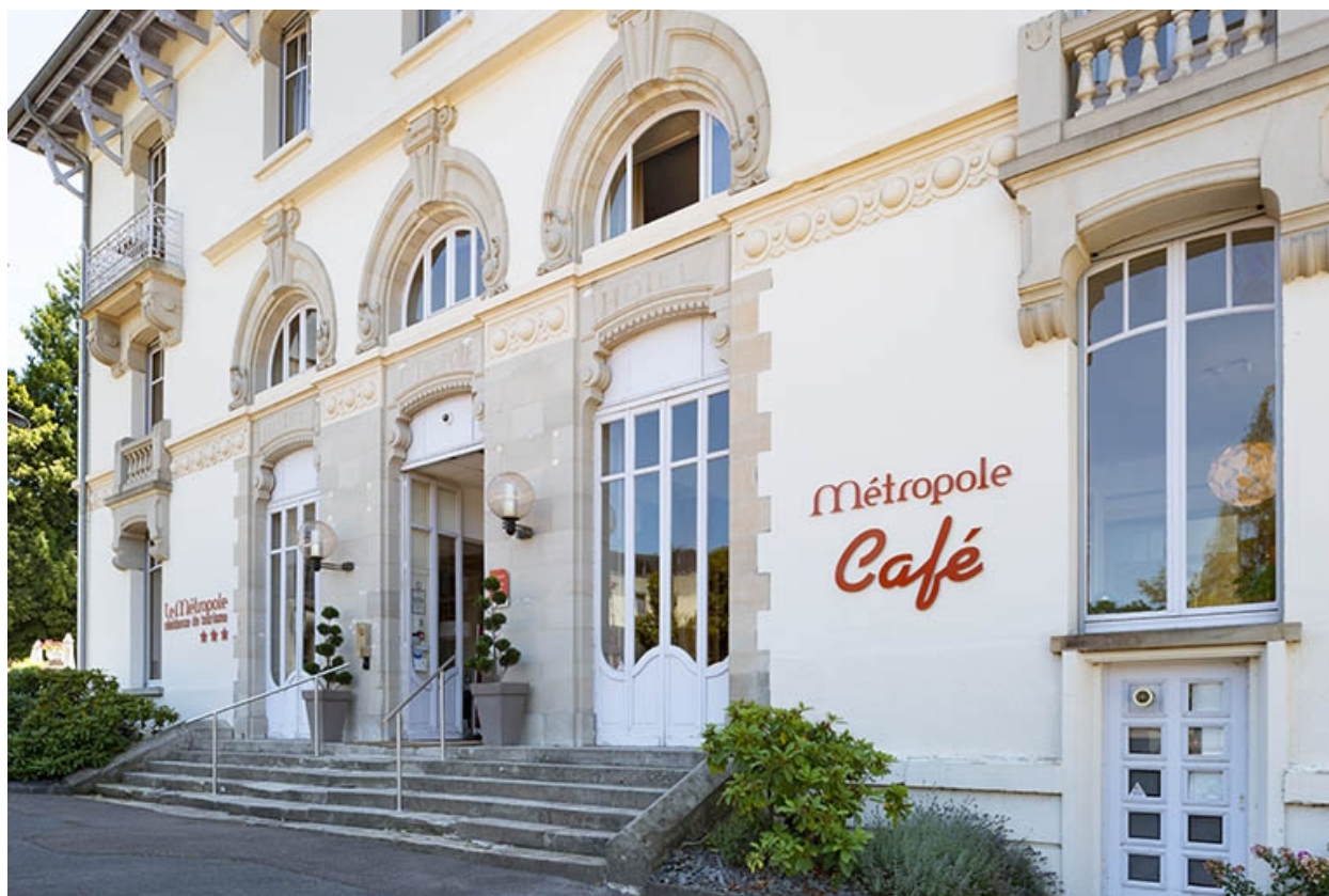
Façade nord, vue de trois quarts, détail.
