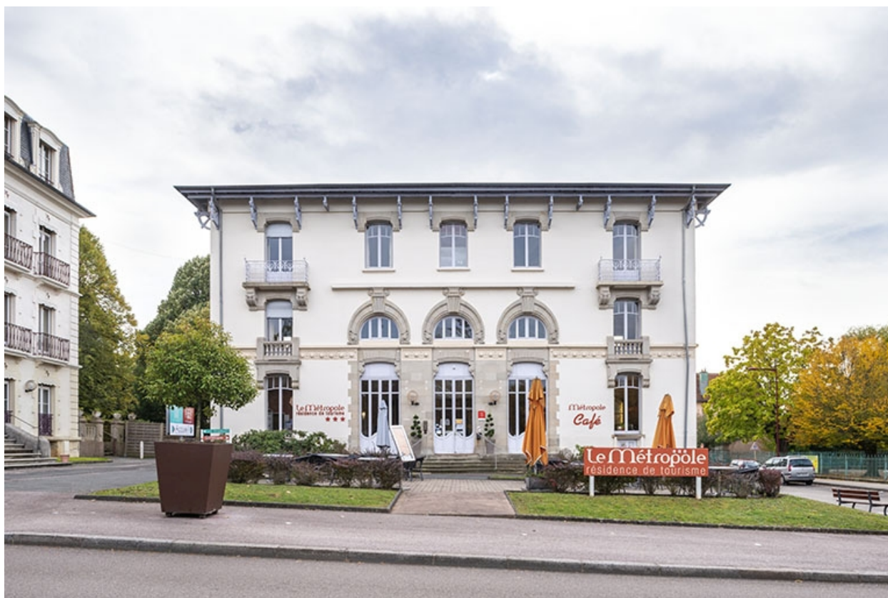
Façade nord, vue de face.
