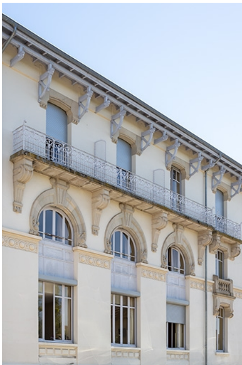
Façade ouest, vue de trois quarts, détail.
