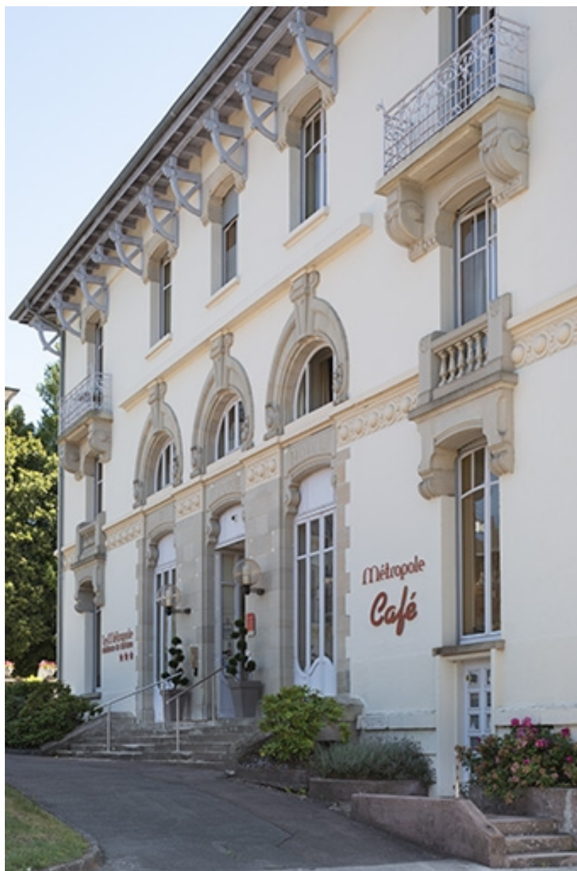
Façade nord, vue de trois quarts, détail.
