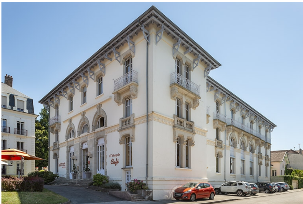
Façade nord, vue de trois quarts.
