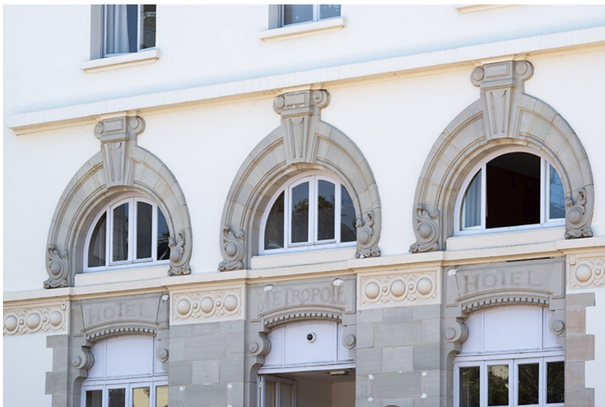
Façade nord, vue de trois quarts, détail.
