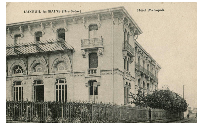
Vue ancienne. Autr. auteur inconnu IVR43_20217000105NUC4A
