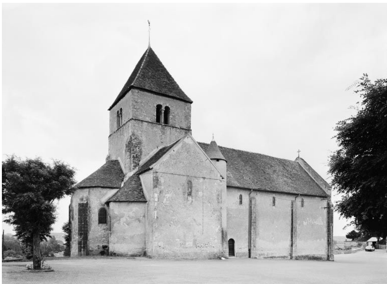
Elévation latérale gauche, vue prise du nord-est.
