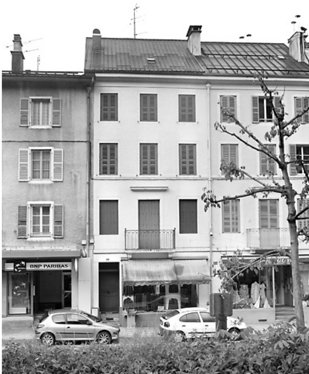
Elévation antérieure du n° 126.
