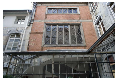
Détail de l'aile contenant l'escalier principal.
