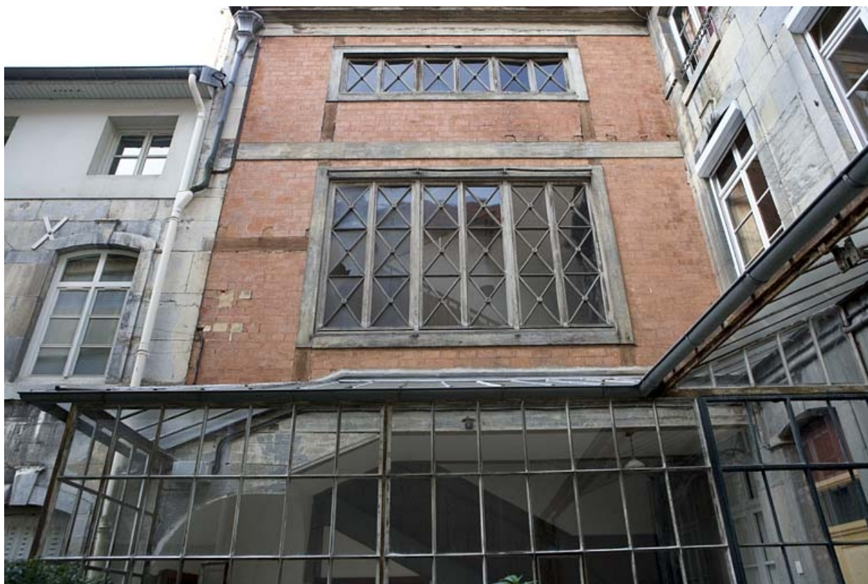
Détail de l'aile contenant l'escalier principal.
