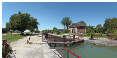
Vue d'ensemble du site d'écluse.
