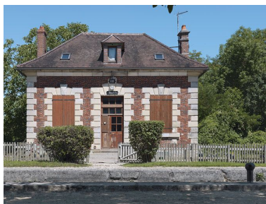
Maison éclusière vue de face.
