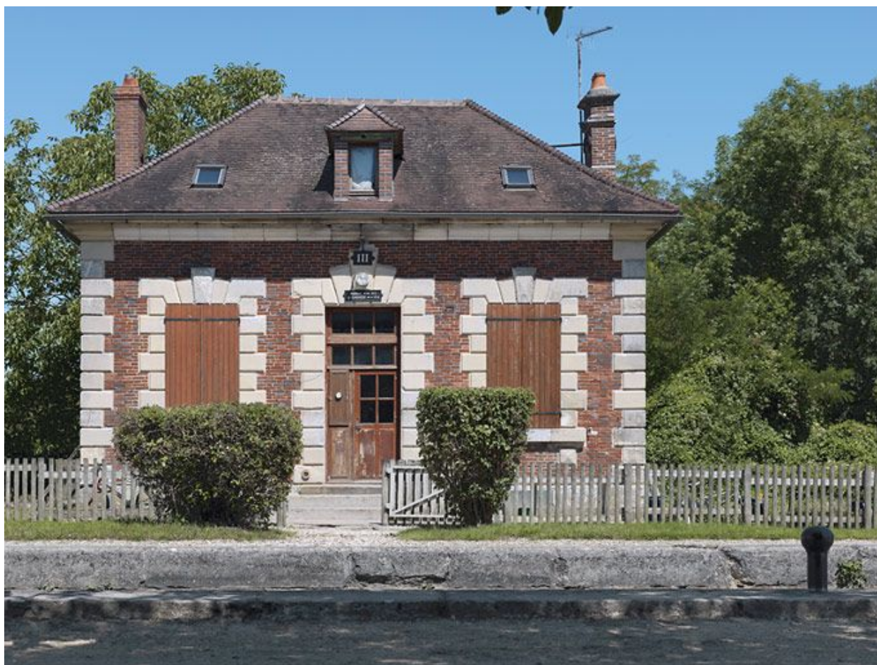
Maison éclusière vue de face.
