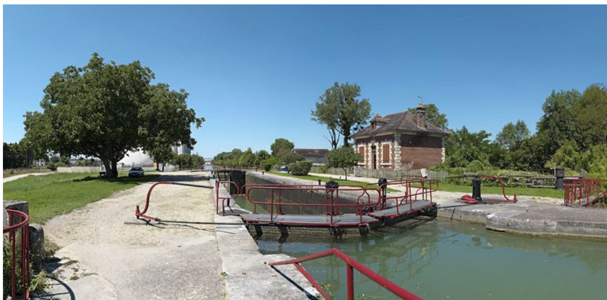
Vue d'ensemble du site d'écluse.
