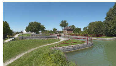
Le site vu d'amont : on distingue le pont canal au premier plan.
