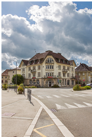
Vue d'ensemble, depuis le nord-ouest (cadrage vertical).
