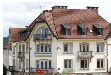
Façade antérieure et pan coupé : niveaux supérieurs.
