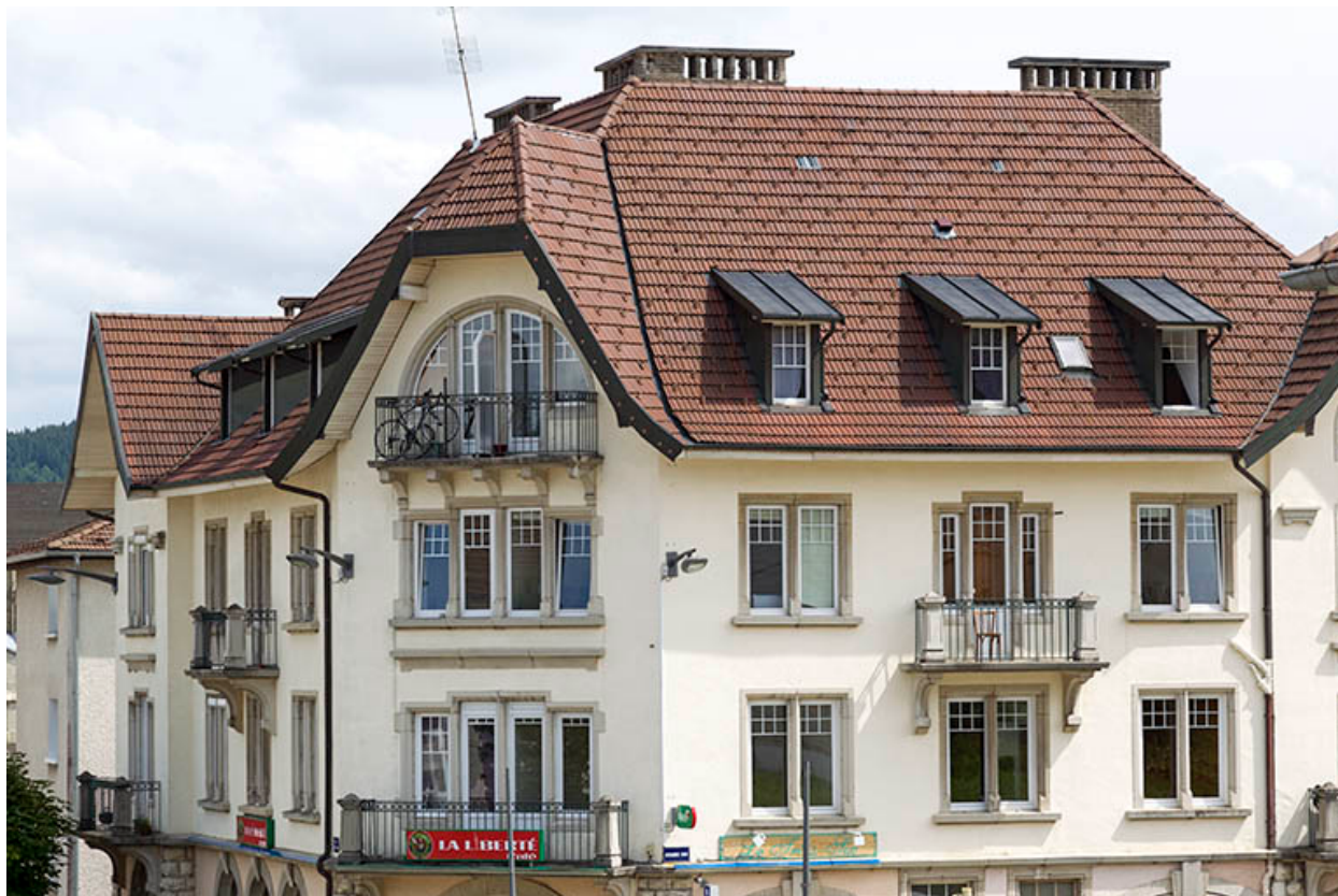
Façade antérieure et pan coupé : niveaux supérieurs.
