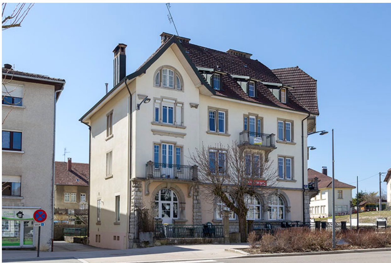
Façade latérale gauche.
