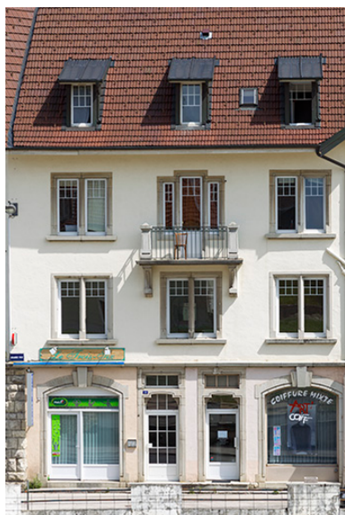
Façade antérieure : travées principales.
