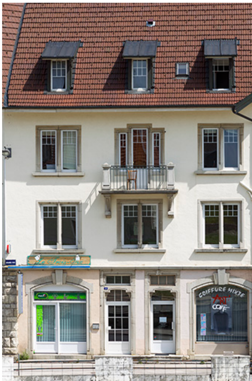
Façade antérieure : travées principales.
