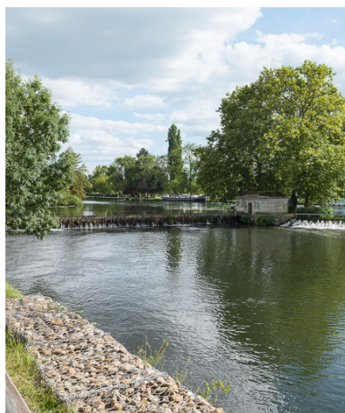
Vue du barrage.
